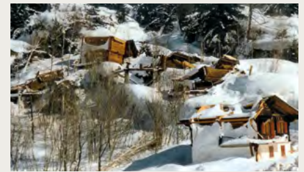
Durch Gratlawine zerstörte Wohnhäuser (Foto: Peter Schwitter 1999)
