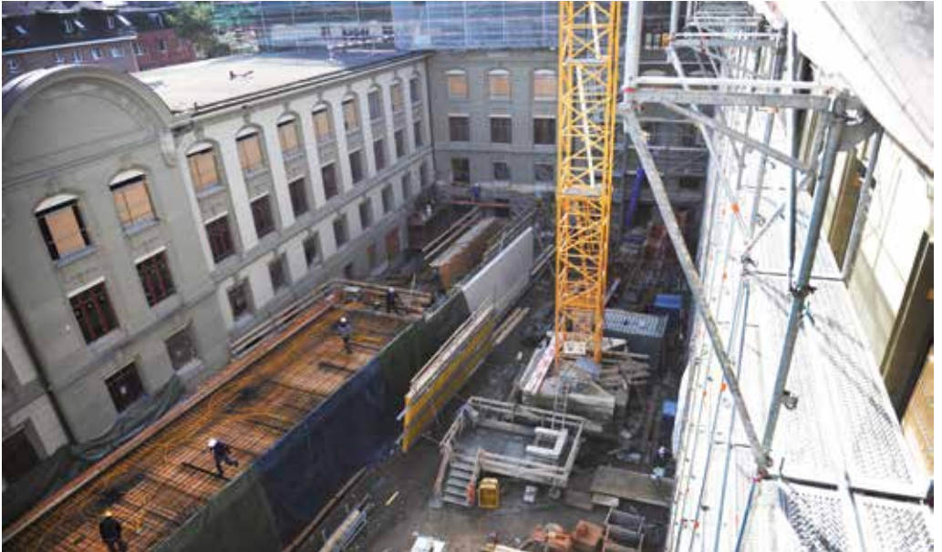
Im Hof des Gebäudes Uni Mittelstrasse entsteht der Anbau der neuen Bibliothek (Bild: Christian Lüthi)
