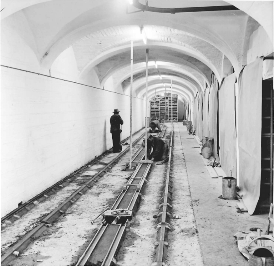
Abb. 2: Einbetonieren der Schienen für die erste Rollregalanlage in Bern, 1952 im Gewölbekeller der Stadt- und Universitätsbibliothek an der Münsterstrasse (© Bürgerbibliothek Bern)
