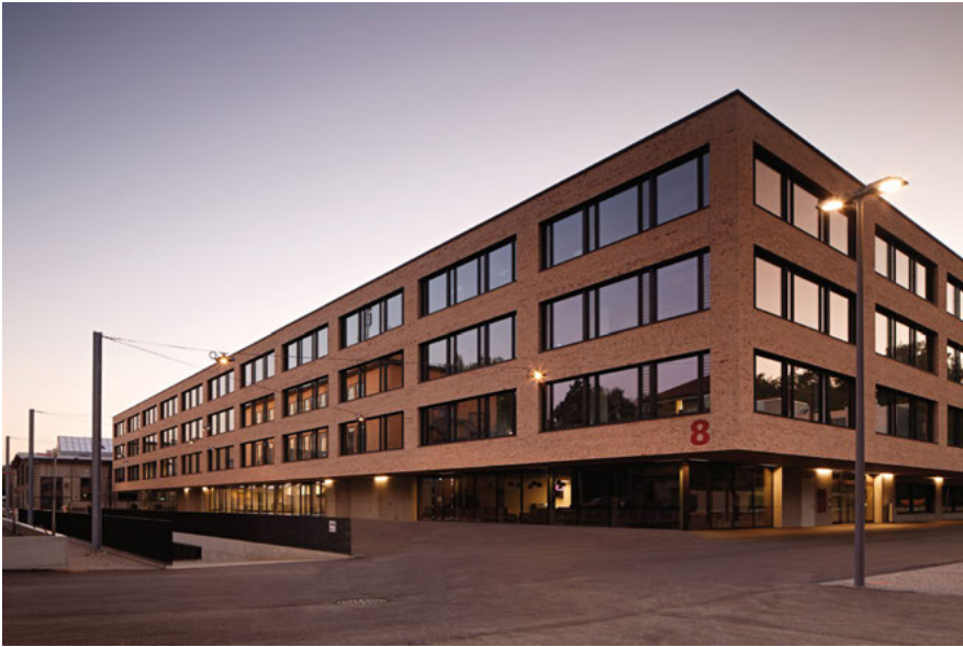
Abb. 3: Hochschulzentrum vonRoll (© Croci & du Fresne Fotografie, September 2013 vor der Eröffnung), im Vordergrund der Neubau mit der Bibliothek in den Untergeschossen, im Hintergrund links die Weichenbauhalle, in die Hörräume eingebaut wurden
