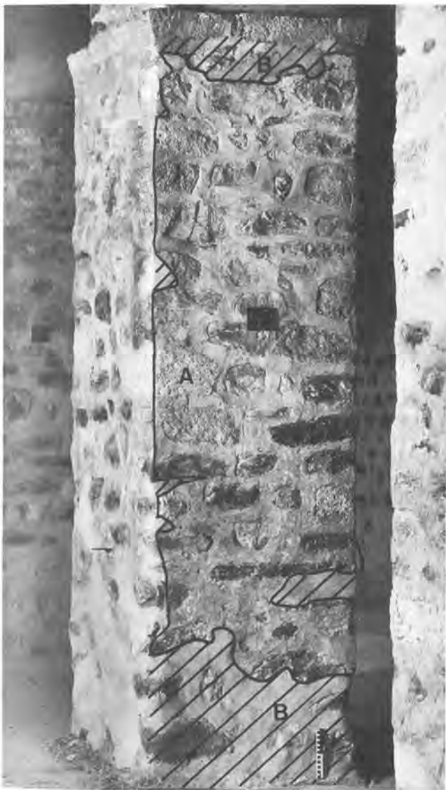
Abb. 4B: Pietra rasa am dritten, nördlichen Pfeiler (Ostseite), A: ursprüngliche Partie, B: wiederhergestellt während der Restaurierung
