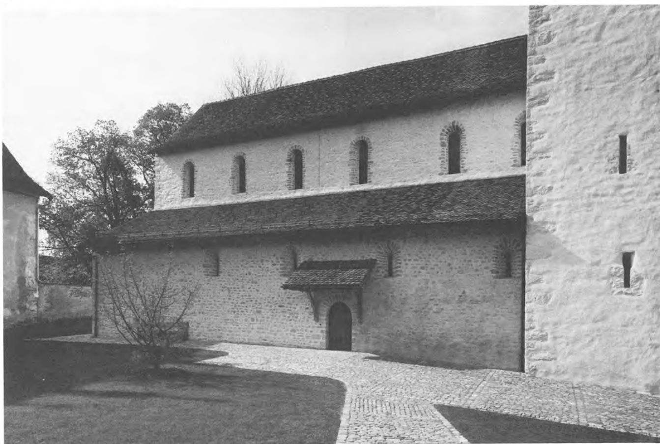
Abb. 8: Ansicht der Kirche von Süden
