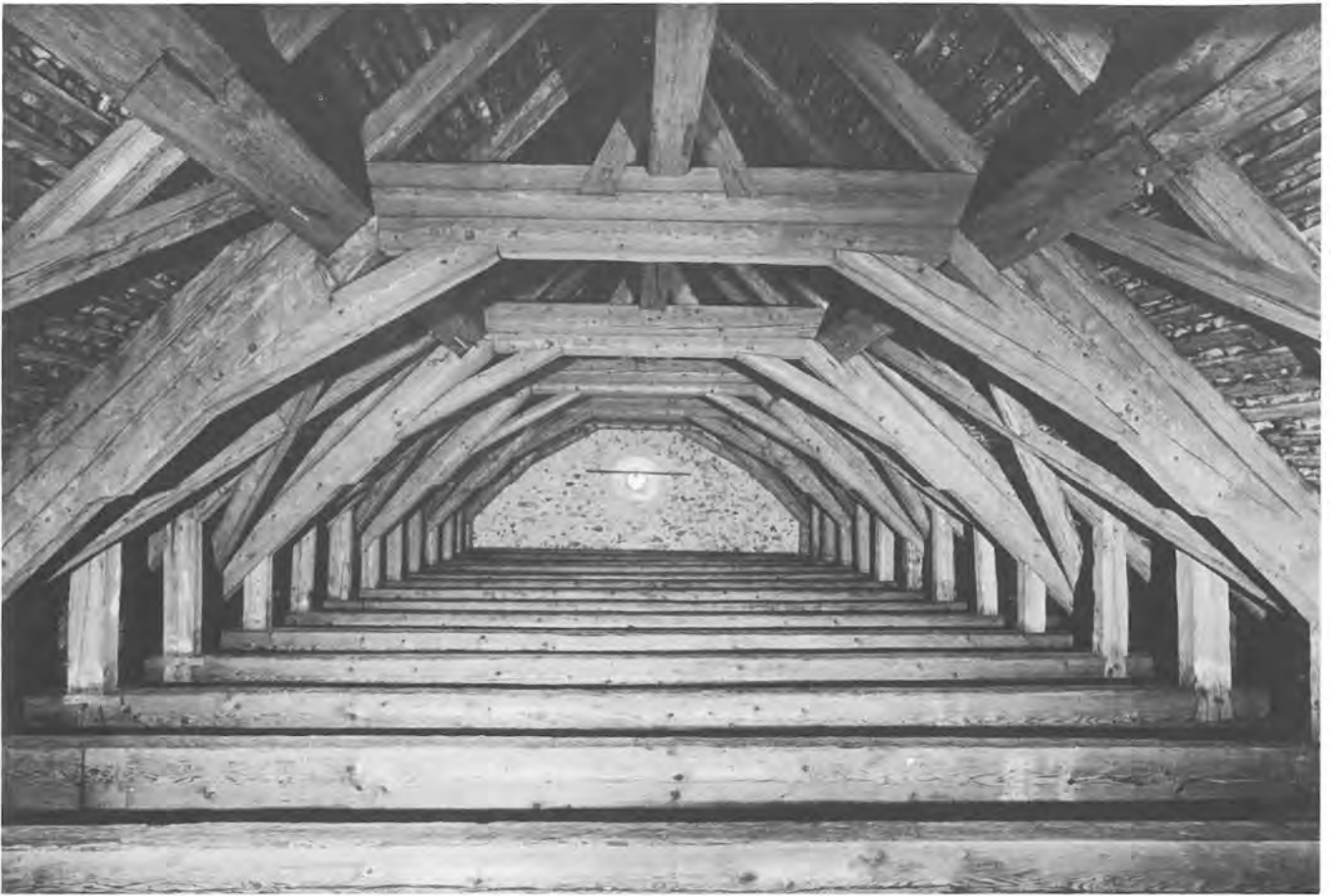
Abb. 11: Dachstuhl von 1576, Blick gegen Westen
