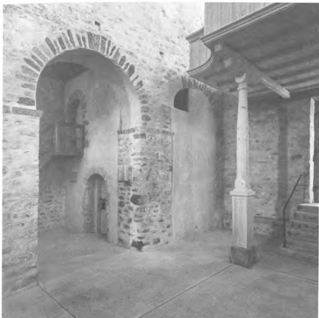
Abb. 20: Spätere Einbauten im Westen des südlichen Seitenschiffs, Ansicht von Nordosten
