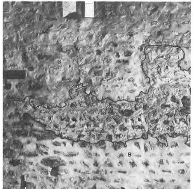
Abb. 4C: Pietra rasa, nördliches Seitenschiff innen, unmittelbar östlich des Nordeingangs, A: ursprüngliche Partie, B: wiederhergestellt während der Restaurierung
