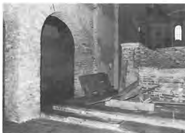
Abb. 60: Piobesi: S. Giovanni Inneres, Blick gegen Nordosten
