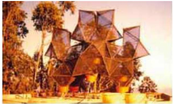
Fig. 2 Fog collector Macrodiamante.
