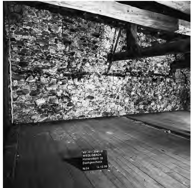
Abb. 63: Hinterstädtli 19: Innenansicht der Stadtmauer mit den vermauerten Scharten im Dachstock des Hauses (vgl. Abb. 16).
