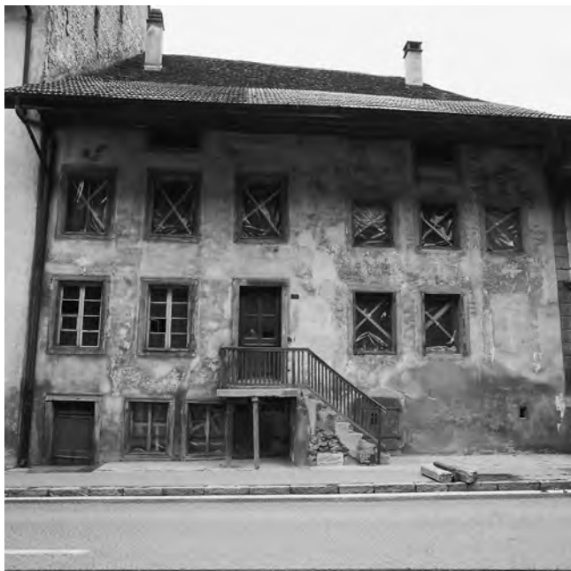
Abb. 53: Städtli 18: Die Südfassade während des Umbaus 1994. Ansicht von Süden.
