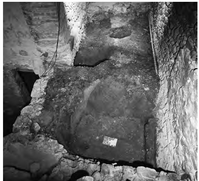
Abb. 35: Städtli 13: Die Nordwestecke des Kernbaus im Erdgeschoss. Am linken vorderen Bildrand die alte Kellertreppe, am rechten Rand die Brandmauer zu Städtli 15.
