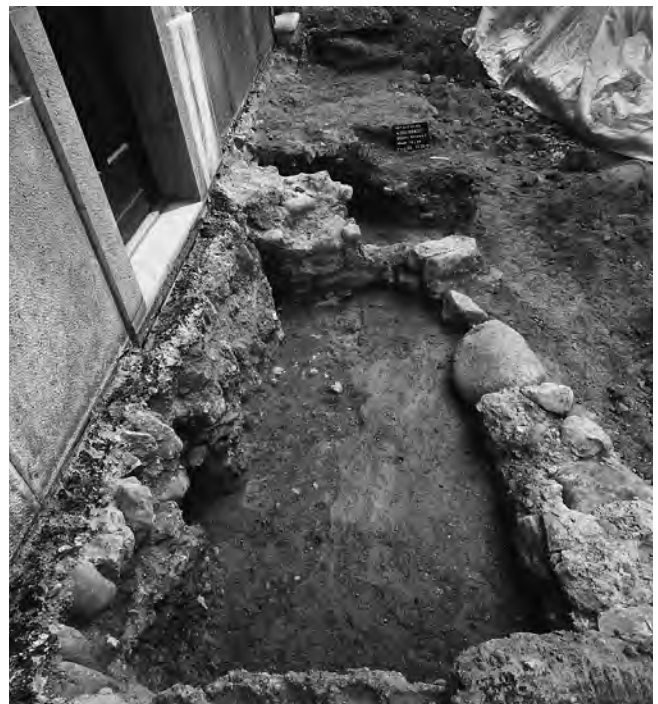
Abb. 69: Städtli 12/14: Die Mauern (12:78) und (12:86) vor dem Haus. Aufsicht und Blick nach Osten.
