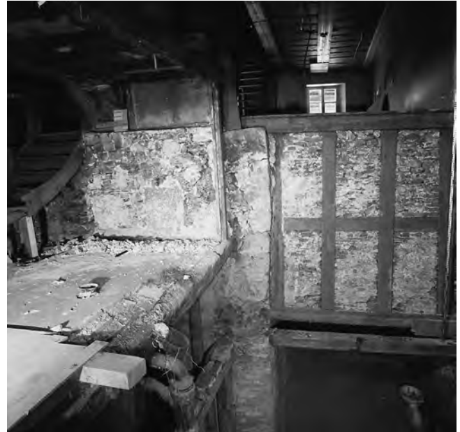
Abb. 34: Städtli 13: Die Nordwestecke des Kernbaus im ersten Obergeschoss. Blick nach Süden.
