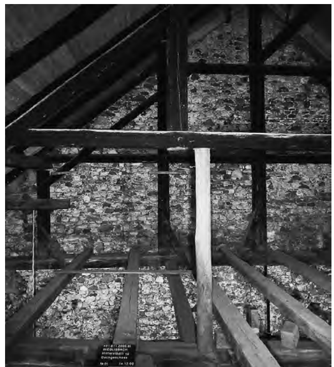
Abb. 64: Hinterstädtli 19: Der Dachstuhl von 1490 und die östliche Brandmauer.
