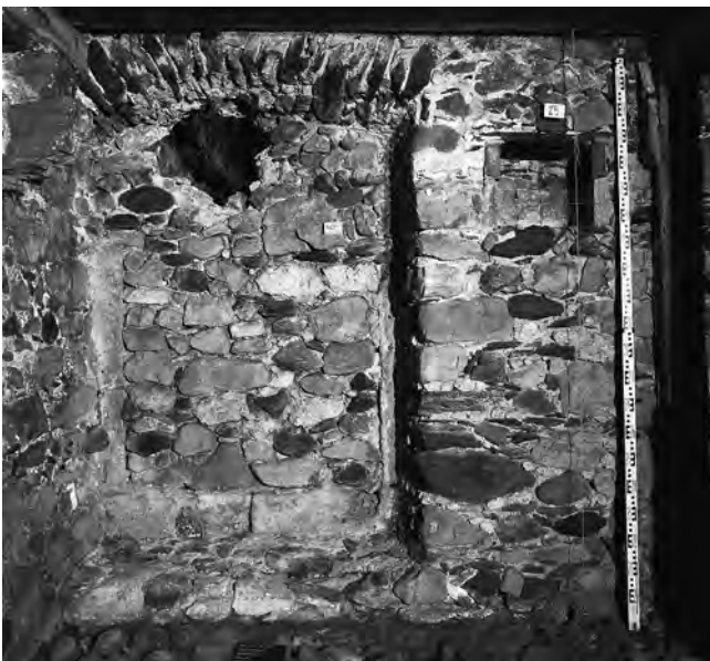
Abb. 33: Städtli 13: Die vermauerte, ehemalige Kellertüre von innen, Blick nach Norden. Der Keller mit der Lichtnische rechts neben der Türe gehört zum Kernbau.
