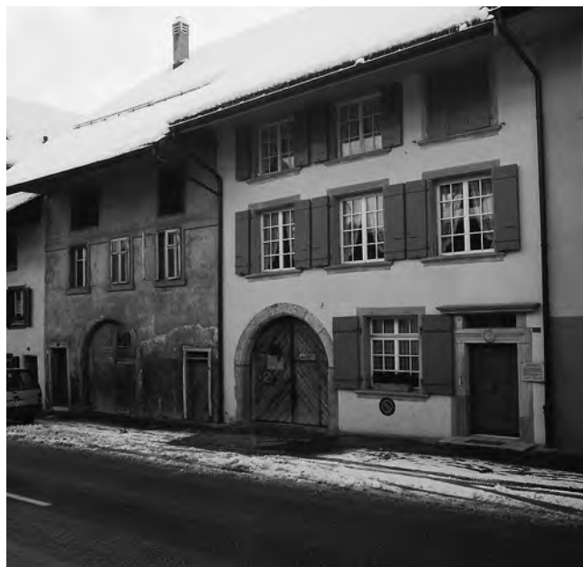
Abb. 46: Städtli 13 (links): Die Nordfassade mit der Toreinfahrt von 1609.
