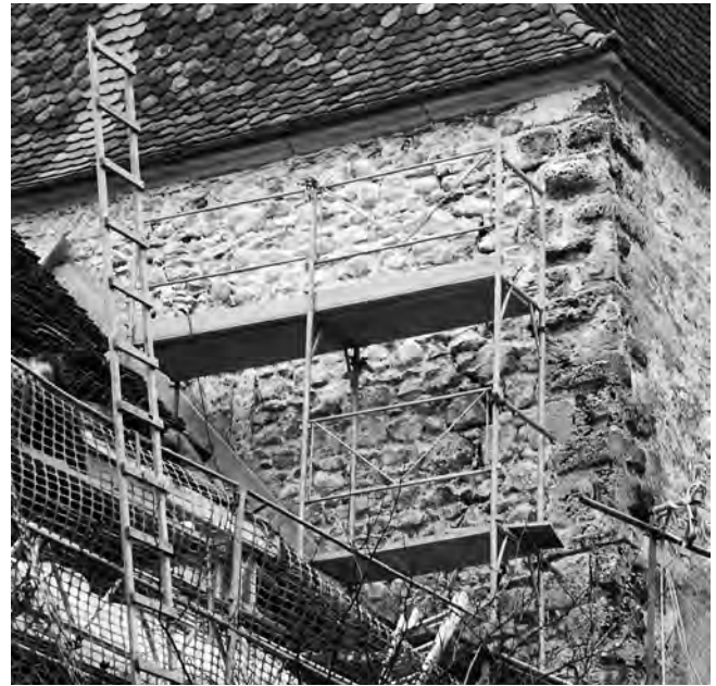
Abb. 25: Stadtliturm: Der südöstliche Eckverband aus Bossenquadern mit Randschlag.
