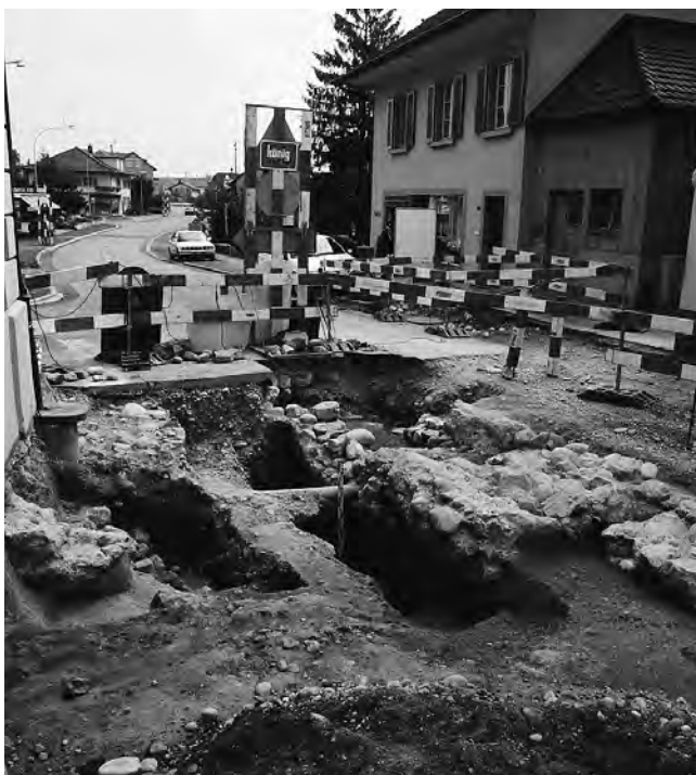
Abb. 17: Fundamentreste des Osttores von Wiedlisbach anlässlich der Grabungen 1994. Übersicht, Blick nach Osten.
