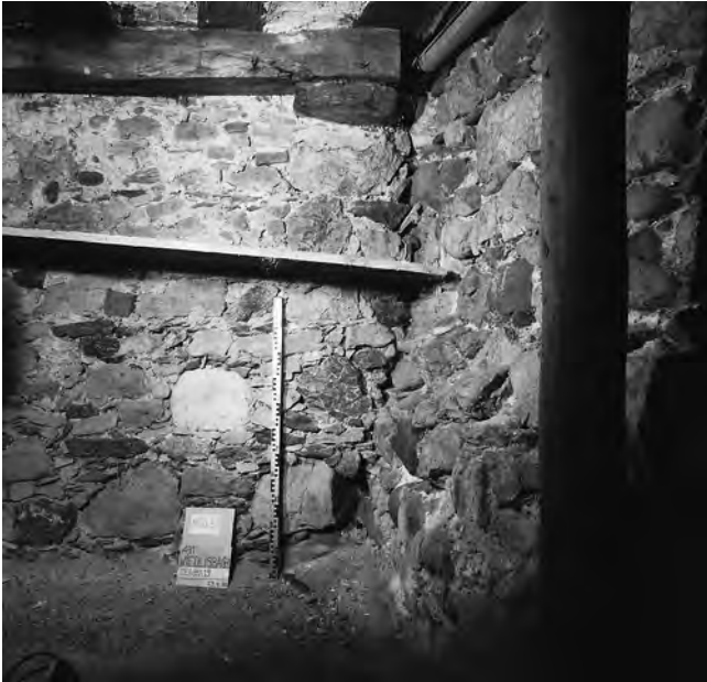
Abb. 32: Städtli 13: Die Ostmauer des Kellers unter dem Kernbau von innen. Sie stösst rechts an die Stadtmauer.
