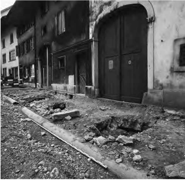
Abb. 72: Städtli 27: Der Keller (27:80) vor dem Haus. Blick nach Südosten.
