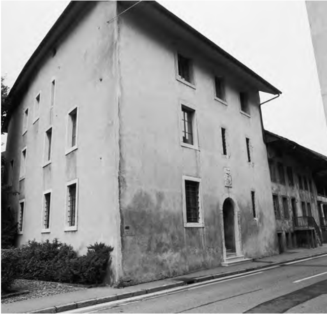
Abb. 59: Das ehemalige Kornhaus Städtli 20 (heute Museum) steht westlich des Hauses Städtli 18. Die Westmauer des ehemaligen Kornhauses bildet die Stadtmauer. Blick nach Nordosten.
