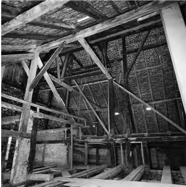
Abb. 62: Städtli 18: Der Dachstuhl, Blick nach Norden.
