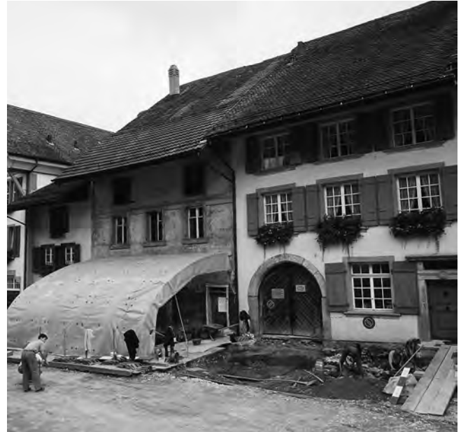
Abb. 31: Städtli 13: Die Nordfassade mit dem Grabungszelt anlässlich der Untersuchungen in der Städtlidurchfahrt 1994.
