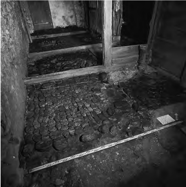
Abb. 49: Städtli 13: Die Reste des Stalles im Nordwestteil des Hauses. Blick nach Norden. Das Gewölbe des darunter liegenden Kellers bildet den Stallboden.
