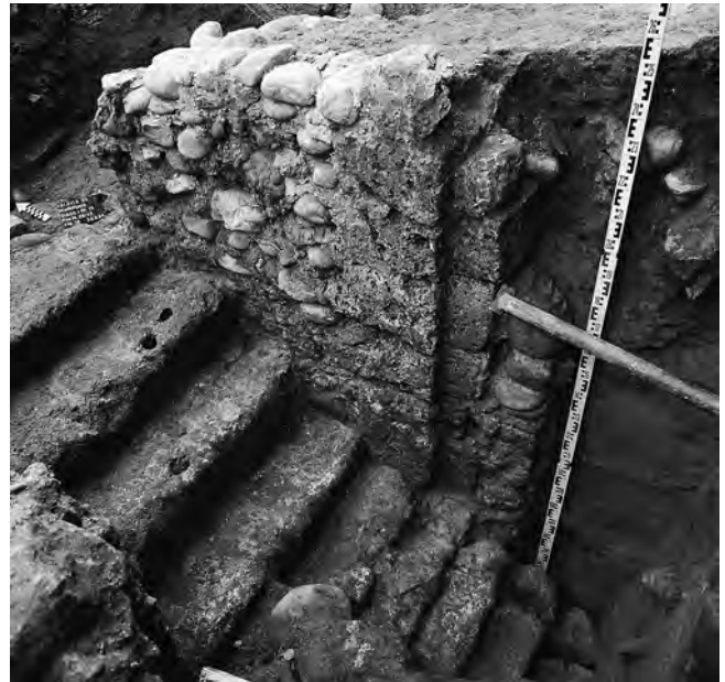
Abb. 40: Städtli 13: Die Kellertreppe vor der heutigen Fassade gehört zum ältesten Bestand. Blick nach Nordosten.
