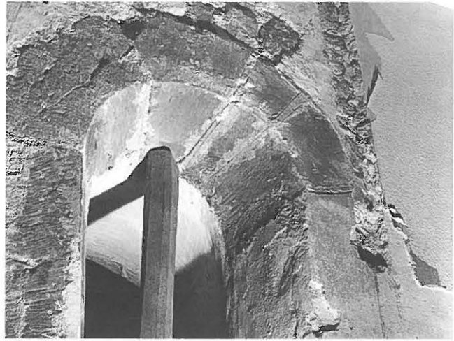
Abb. 219: Detail der Aussenseite von Fenster (207.8). Bemerkenswert ist die Ausbildung der Stossfugen am rechten Bogen zu Stegen. Die Gewände wurden senfgelb überfasst und gegen den weissen Wandputz mit roter Linie konturiert.
