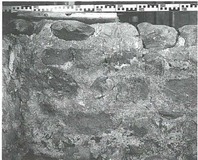
Abb. 83: Deckverputz mit Fugenstrich im Chorinneren.
