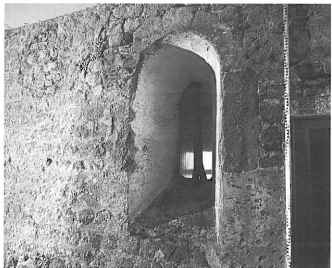
Abb. 221: Detail der Innenansicht Fenster (207.8).
