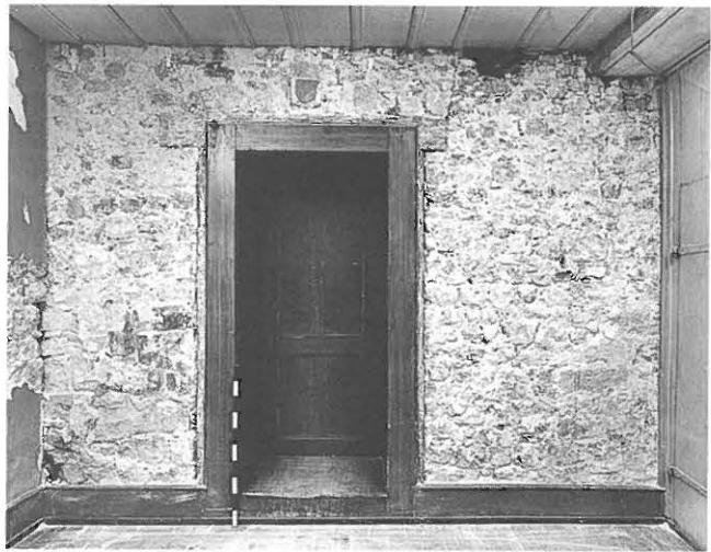
Abb. 307: Östlicher Zugang zu Raum C im Obergeschoss. Über der Türe Wappen Senarclens (Abb. 389.7) in Zweitverwendung.
