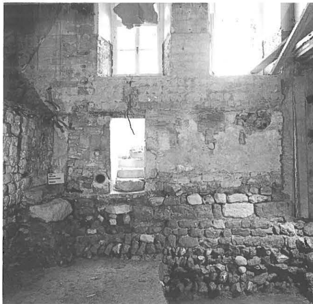
Abb. 234: Raum G auf Kellerniveau nach Süden (Mauer 148). Links die vermauerte Tür (149.1).
