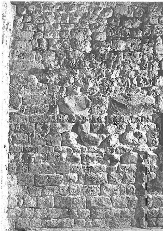
Abb. 266: Baunaht innerhalb des romanischen Mauerwerks der Nordwand (144).
