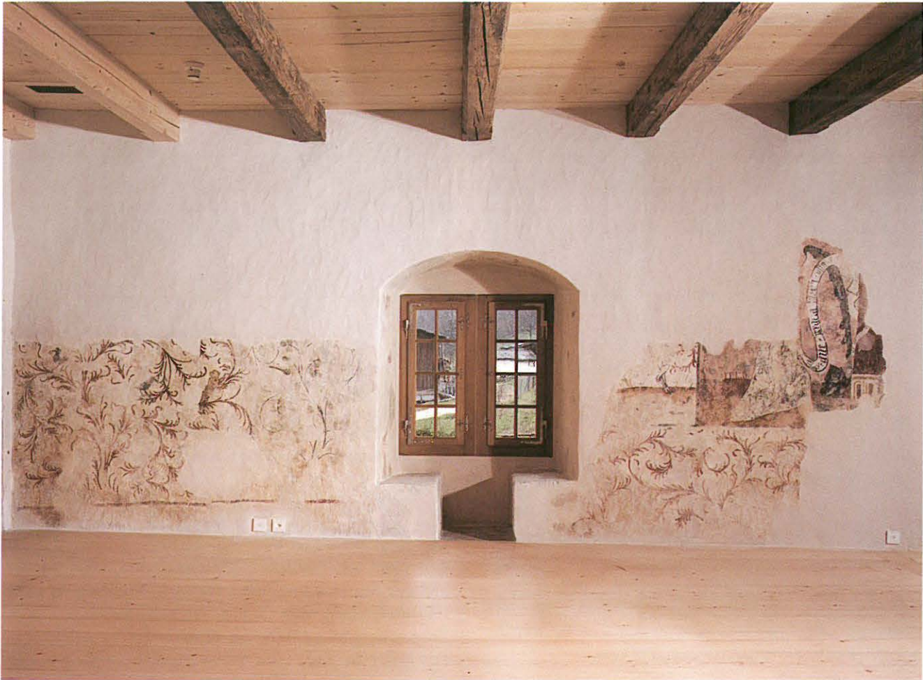
Abb. 300: Die Wandmalereien an der Westwand des «gotischen Saals» nach der Restaurierung. Aufnahme 1988.
