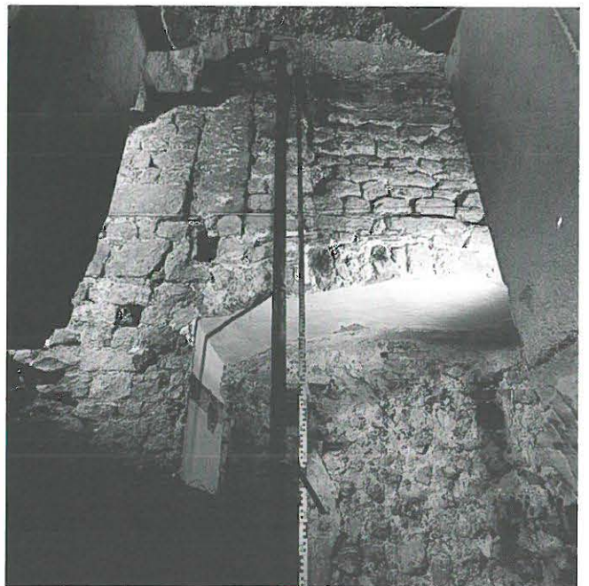
Abb. 213: Südeinde der kreuzgangseitigen Westwand des Ostflügels, bei der neuzeitlichen Nische Reste des Portals (207.3) ins Obergeschoss.
