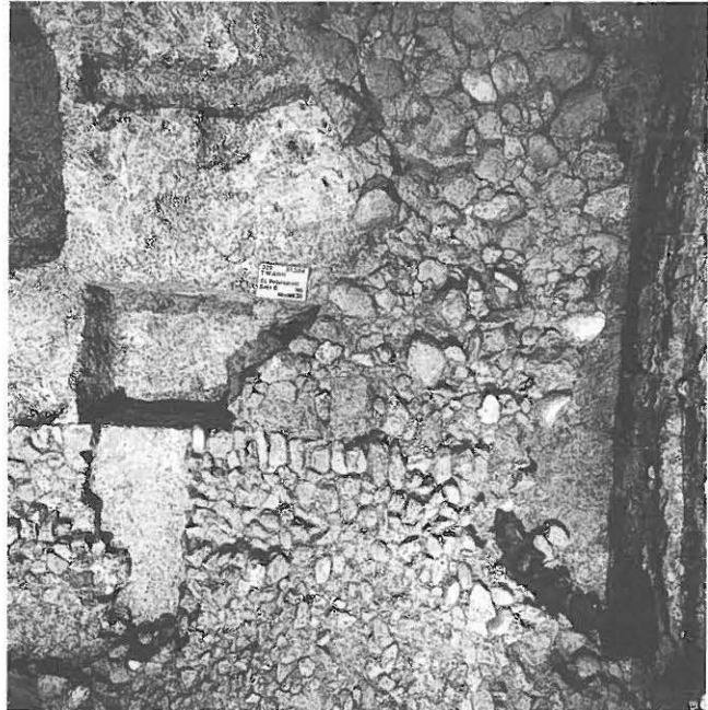
Abb. 149: Die nördliche Nebenapsis (142; oben) stösst an das nördliche Hauptchorfundament (122; unten).
