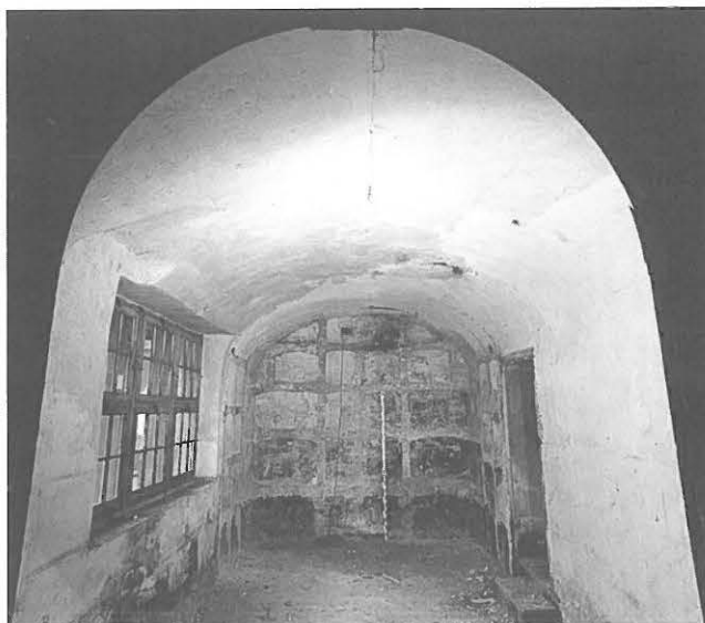
Abb. 19: Das Gewölbe im sog. Kiosk nach Norden. Zustand 1984.
