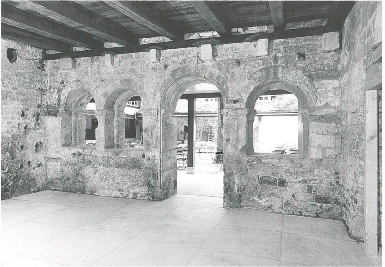
Abb. 198: Innenseite der Kapitelsaalarkaden nach Abschluss der Restaurierungsarbeiten. Sie beschränkten sich auf museale Konservierung.
