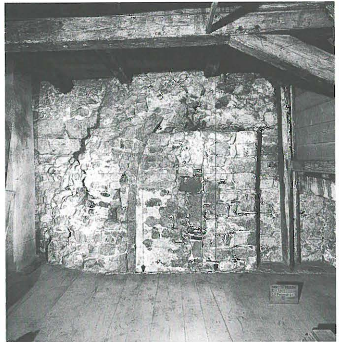
Abb. 161: Befunde zum südlichen Schildbogen im Dachgeschoss. Übersicht.
