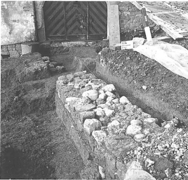
Abb. 318: Hangstützmauer (282), Aufsicht nach Westen.
