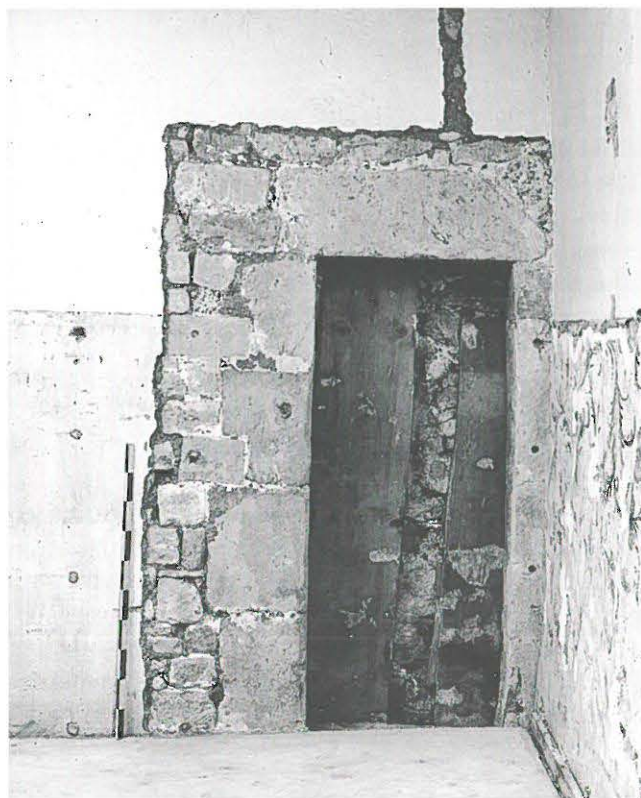
Abb. 302: Durchbruch in die Südwand (132) für eine Pforte in die Priorswohnung.
