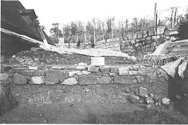
Abb. 317: Hangstützmauer (282) über dem Mönchsfriedhof. Südansicht.
