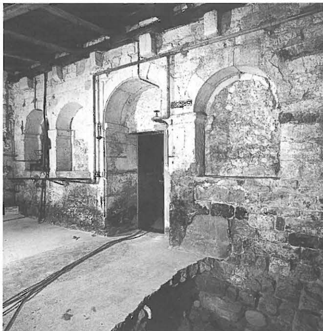
Abb. 22: Die Kapitelsaalarkaden vor der Freilegung, Innenseite.
