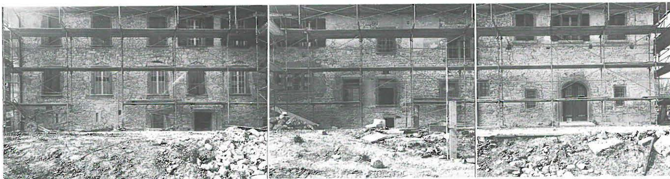
Abb. 316: Ansicht der vom Verputz befreiten Südfassade.
