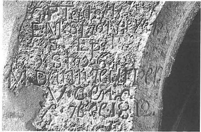
Abb. 320: Renovationsinschrift von 1812 am heutigen Ostzugang. Vgl. Abb. 359.
