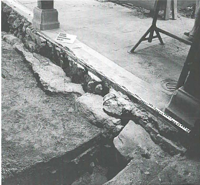
Abb. 268: Jüngere Kreuzgangfundation (222) im Bereich des Südflügels. Darüber Jugendstilstützen und Sockel (226).
