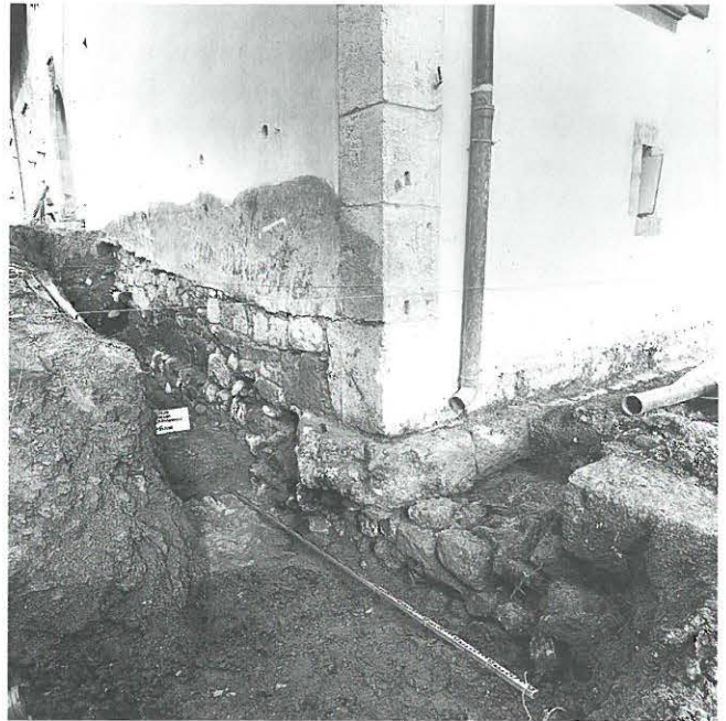
Abb. 251: Heutige Gebäudeecke Südwest mit Fundament (130) des weiter nach Süden ziehenden Westflügels sowie des nach Westen abwinkelnden Fundamentes (134.1).
