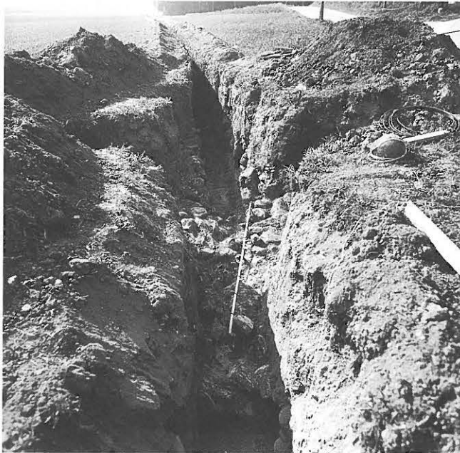
Abb. 59: Werkleitungsgraben W5 unterhalb des Bauernhauses mit Steinpackung (32a).
