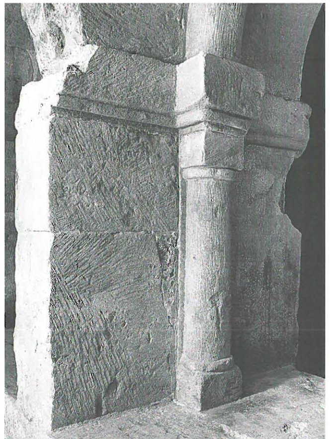
Abb. 200: Originale Steinbearbeitung an der Südseite des Mittelpfeilers der Doppelarkade. Blick von Südwesten.
