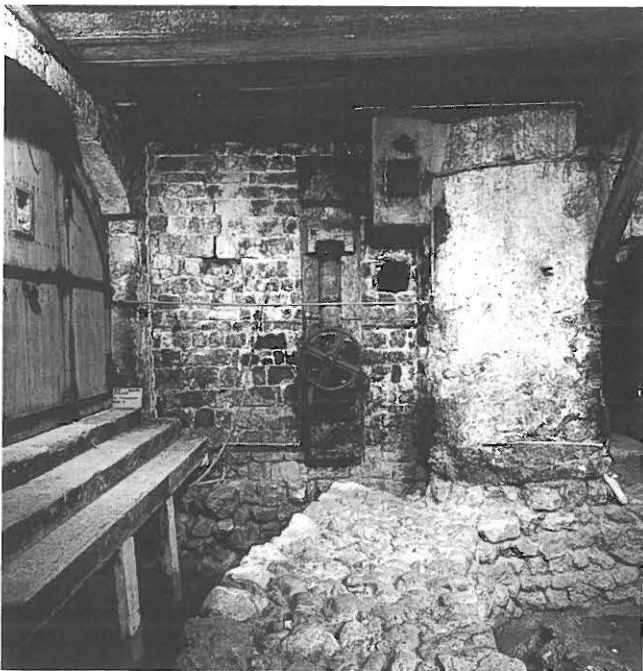
Abb. 163: Befunde im Erdgeschossbereich, Ostteil...
