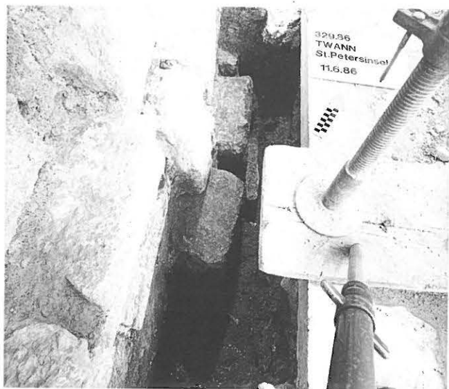
Abb. 122: Südende des Fundamentes (107), welches belegt, dass in südlicher Fortsetzung der Chorquadrate die Anlage des Ostflügels der Konventsbauten begonnen wurde.
