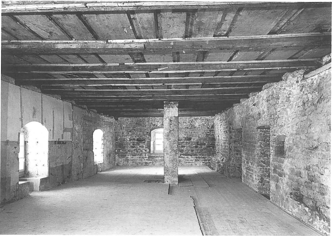
Abb. 259: Übersicht nach Norden im Obergeschoss des Westflügels. Freilegungszustand 1985.
