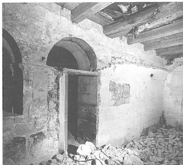
Abb. 20: Die Aufnahme während dem Abbruch des Gewölbes 1986.
