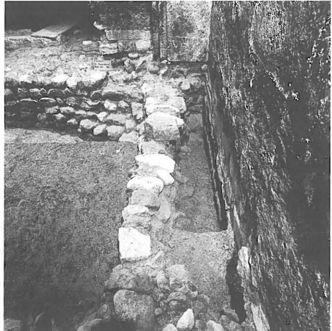
Abb. 139: Spannfundament (116) des südlichen Nebenchors. Im Hintergrund der basislose Ansatz für Chorpfeiler (167). Blick nach Süden.
