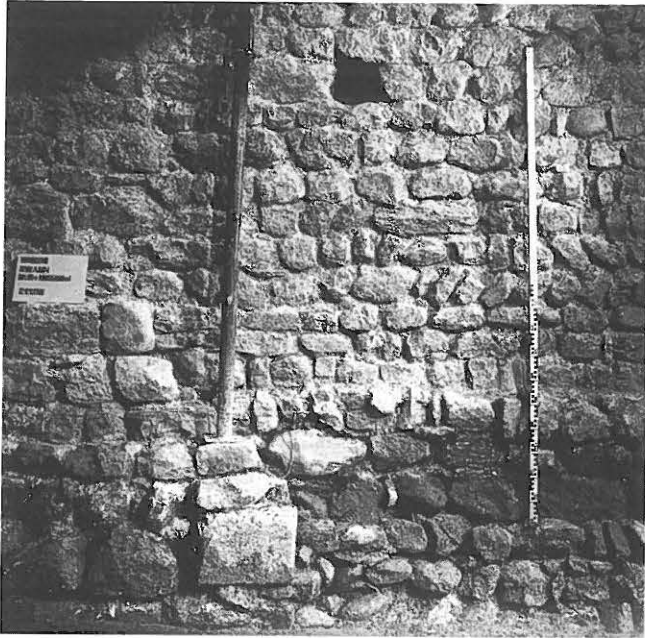
Abb. 120: Nordfundament (147) des südlichen Konventflügels. Links unter der Fototafel die mit den Strukturen zu Basilika I im Verband stehende Zungenmauer (90).
