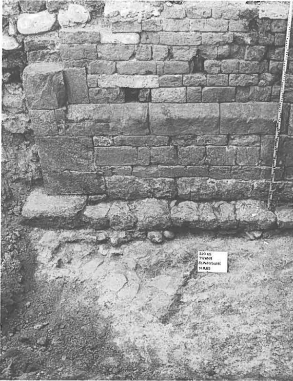
Abb. 157: Sockelmauerwerk (156) des nördlichen Nebenchores.
