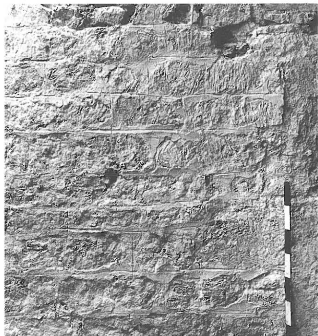
Abb. 215: Mauerdetail an der inneren Westwand mit Fugenstrich und Kalkschlämmung. Rechts: Anbördelungen an hölzerne Trennwand.
