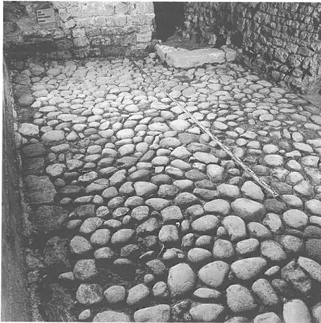
Abb. 309: Pflasterung in der ehem. Pforte (Raum A).
