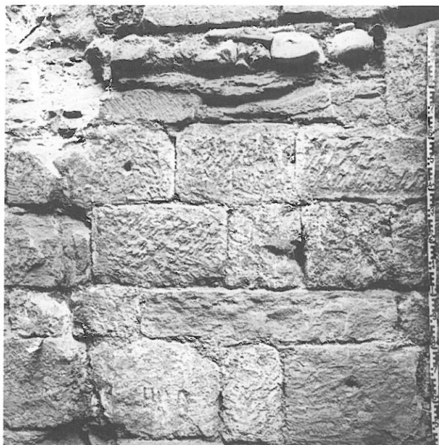
Abb. 50: Mauerwerk des Selsturms (T 2), Aussenseite.
