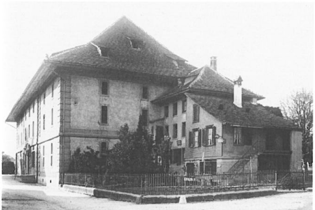
Abb. 76: Kornhaus mit der mutmasslichen Korndarre und dem vor 1843 angebauten Wohnhaus. Ansicht um 1910.
