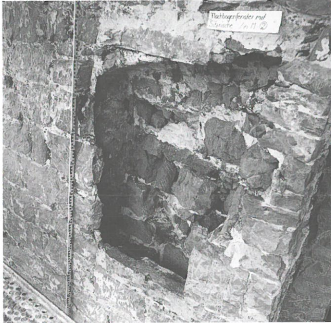
Abb. 36: Fenster (383) von Haus II b in der Stadtmauer (Phase 2).
