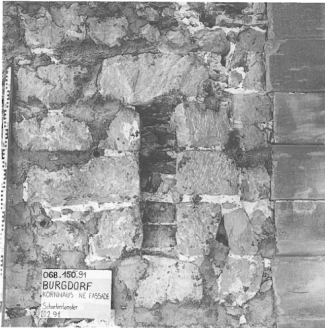
Abb. 34: Scharte (386) im Flickmauerwerk (385) der Phase 2 b.
