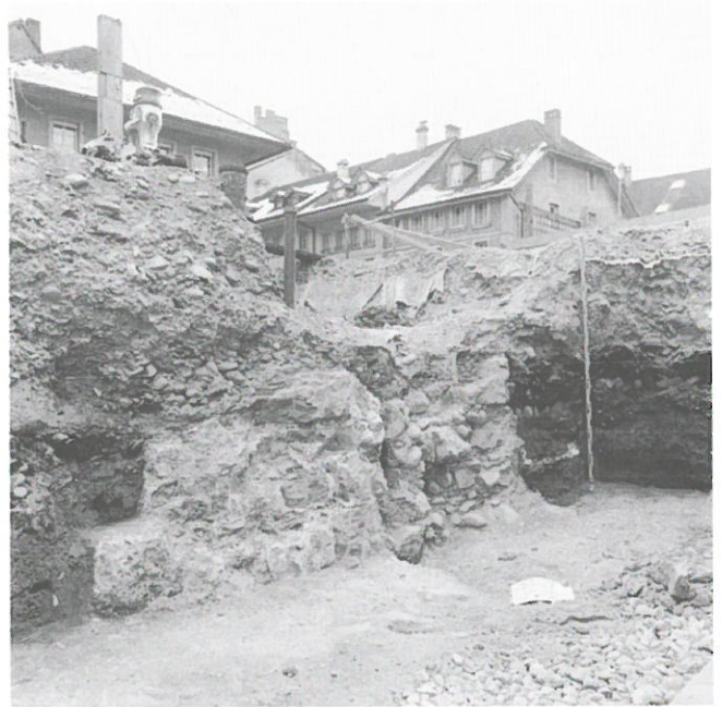
Abb. 48: Ansicht nach Südosten an die von modernen Leitungen durchschlagenen Reste der Stadtmauer und dem nachträglich angebrachten Strebepfeiler (404).
