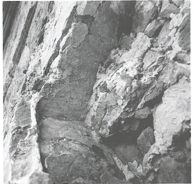
Abb. 37: Fenster (383) mit verputzten Leibungen und Nischenbogen.
