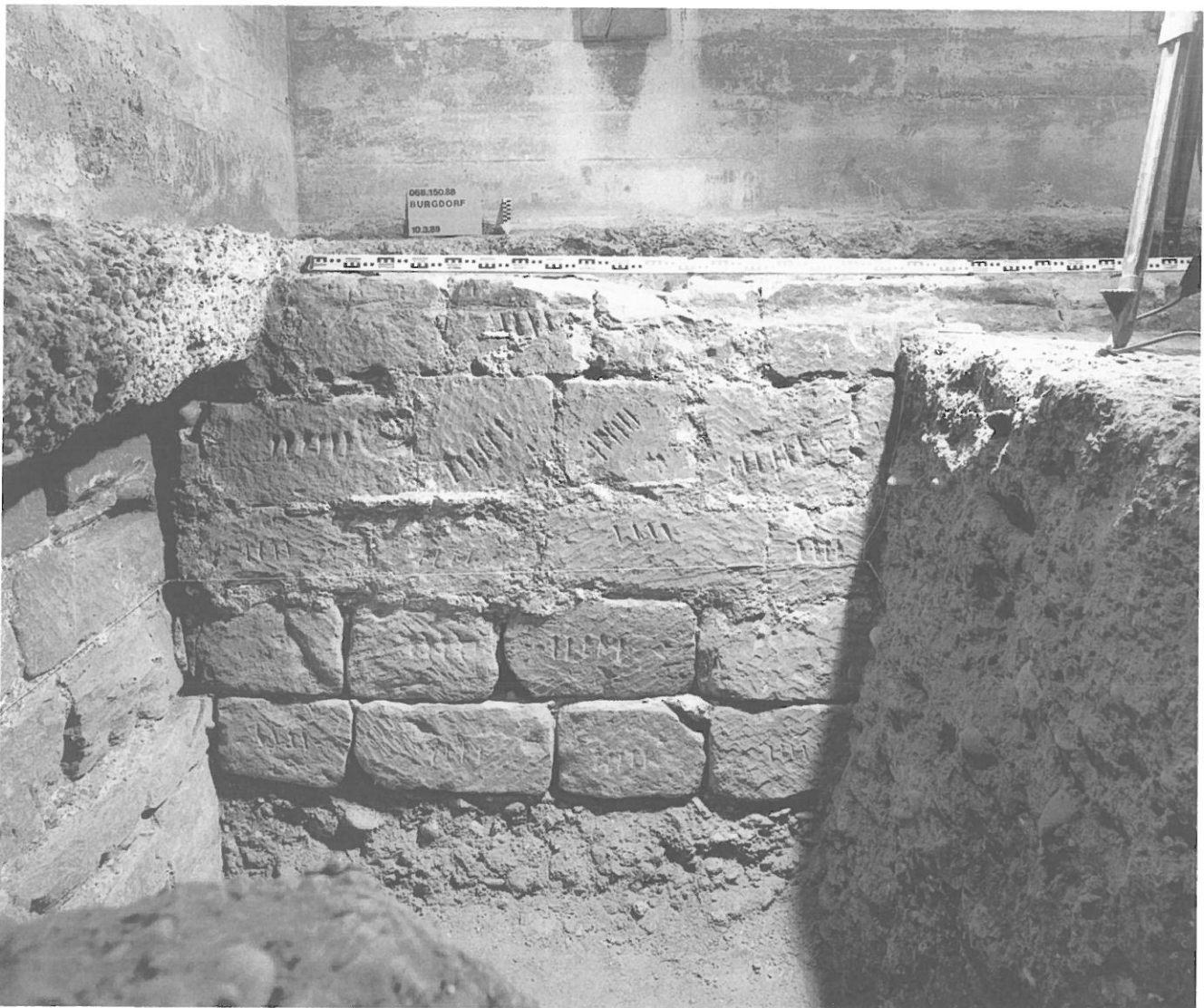
Abb. 21: Ansicht an die Aussenseite der Westmauer von Haus I mit Lagerhöhenzeichen.
