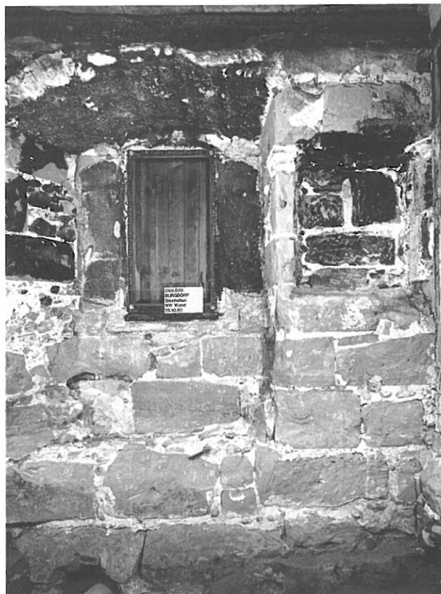
Abb. 27: Stube für die Köchin, Fenster in Nordwand.
