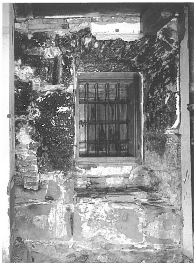
Abb. 23: Küchenfenster in der Westwand.
