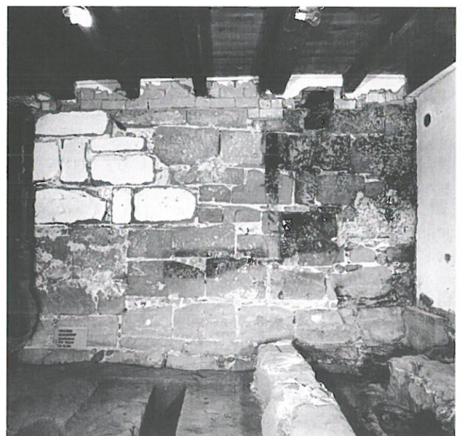
Abb. 21: Ansicht Westwand im Bereich Conventstube und Küche.
