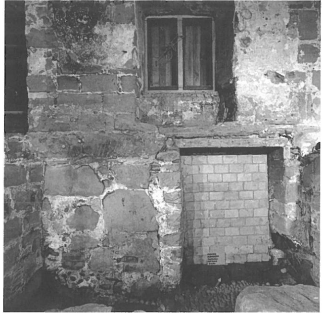
Abb. 31: Kellerzugang auf der Nordseite des Gebäudes.
