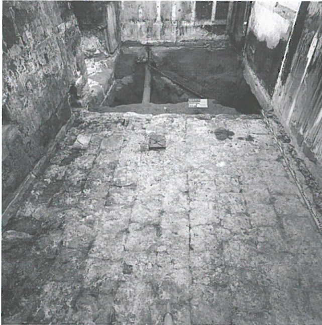
Abb. 24: Mörtelnegative des Tonplattenbodens in der Küche.
