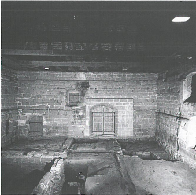
Abb. 43: Ansicht der Ostwand.
