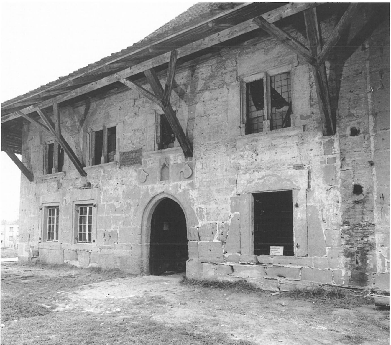
Abb. 9: Südfassade des Siechenhauses.
