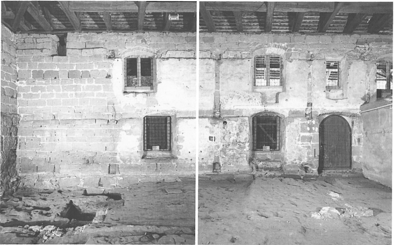
Abb. 40/41: Ansicht der Südwand (östliche Hälfte).
