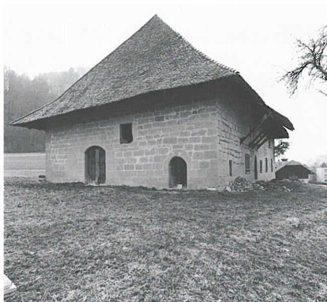
Abb. 13: Ost- und Nordfassade des Siechenhauses.
