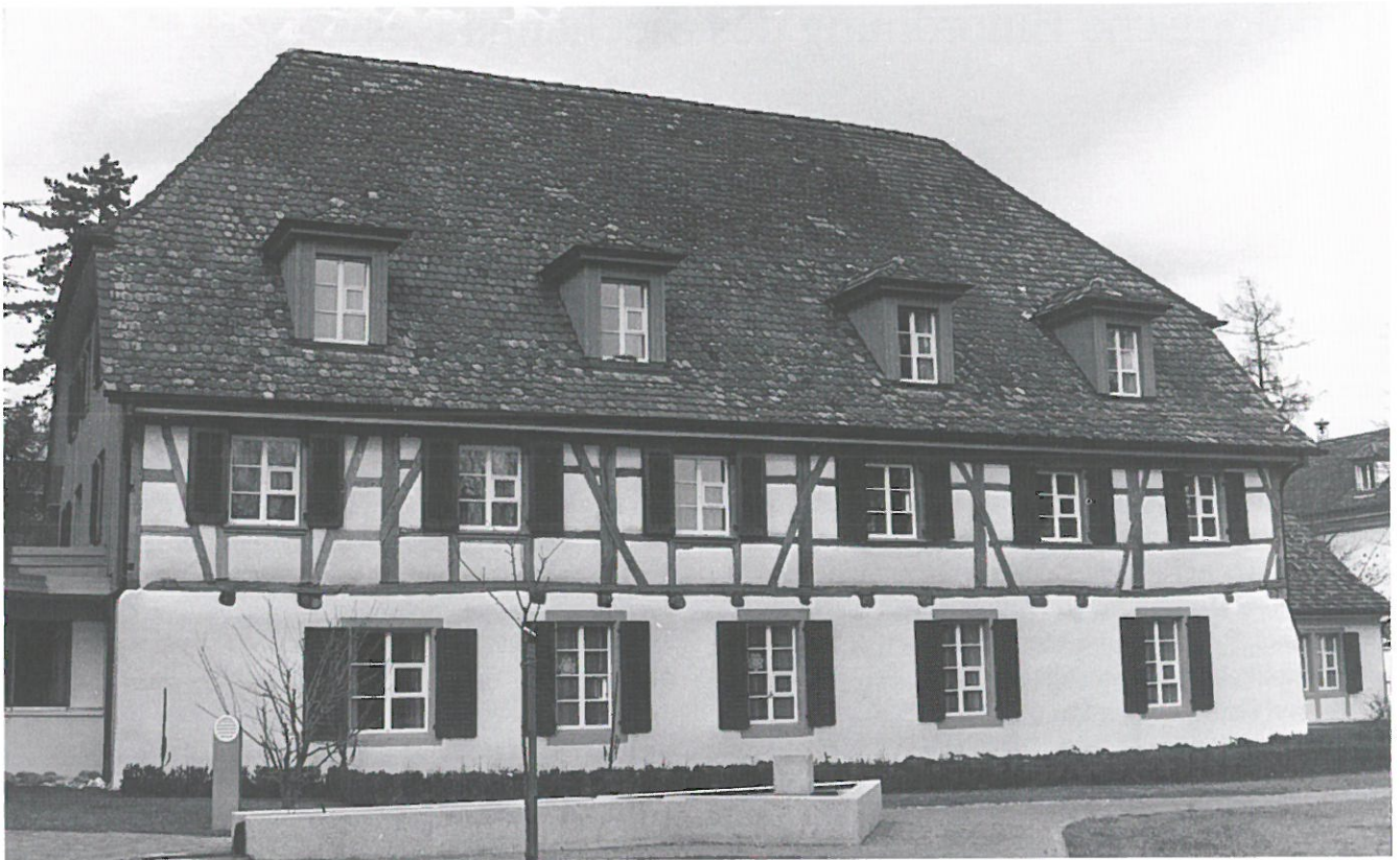
Abb. 49: Siechenhaus in Steig, Südansicht.
