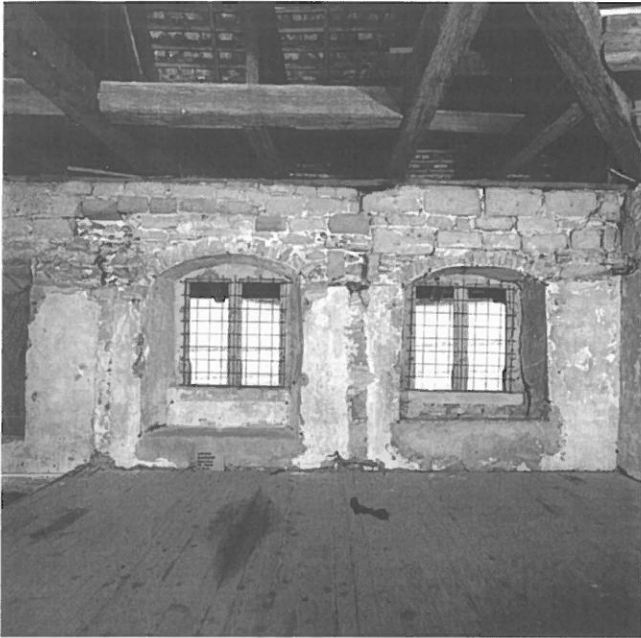
Abb. 44: Ansicht der Südwand im Bereich der Kammern VI und VII.
