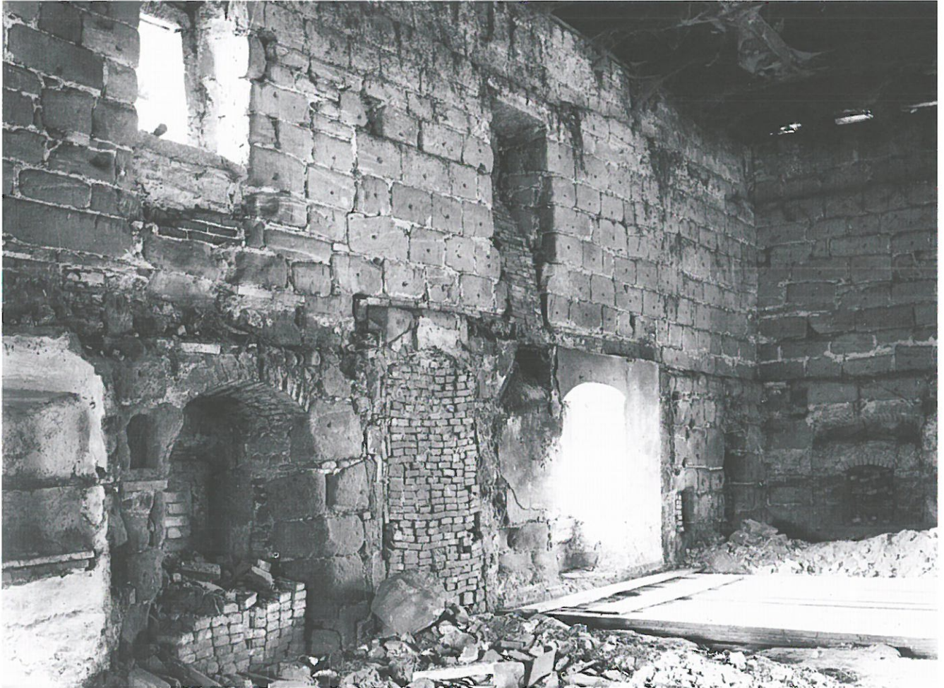
Abb. 32: Ansicht der Nordwand, 1905.
