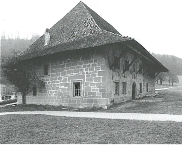
Abb. 11: West- und Südfassade des Siechenhauses.
