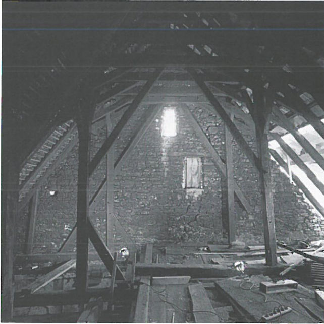
Abb. 23: Unterseen - Obere Gasse 42. Einblick von Norden in den Dachstuhl.
