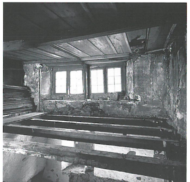
Abb. 26: Unterseen - Obere Gasse 42. Südwest-Stube des 2. Obergeschosses. Fensterdurchbruch von 1653. Vgl. Abb. 8.
