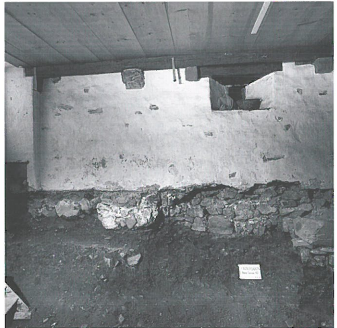
Abb. 19: Unterseen - Obere Gasse 42. Nordostecke des Gründungsbaus mit Erweiterung sowie heutigem Fundament. Vgl. die steingerechte Ansicht in Abb. 8.
