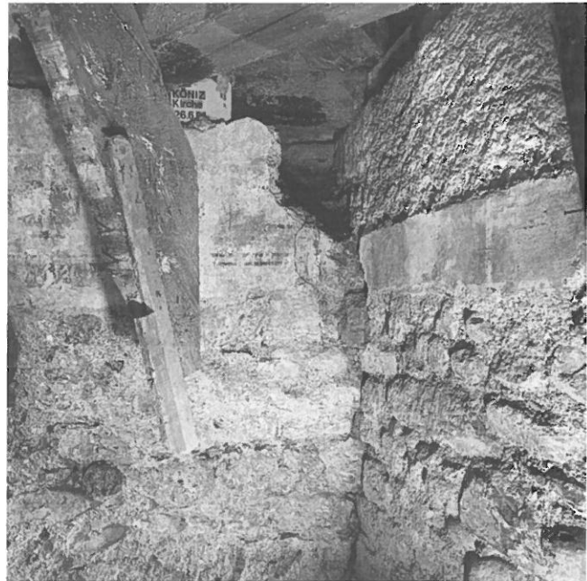
Abb. 15: Köniz - Kirchenchor 1981. Die Nordwestecke des Chores auf der Höhe der seitlichen Mauerkrone. Die waagrechte Naht des Verputzes endet unterhalb der Mauerkrone (rechts). Im Hintergrund ist an der Triumphbogenmauer das Verankerungsloch der gotischen Decke sichtbar.
