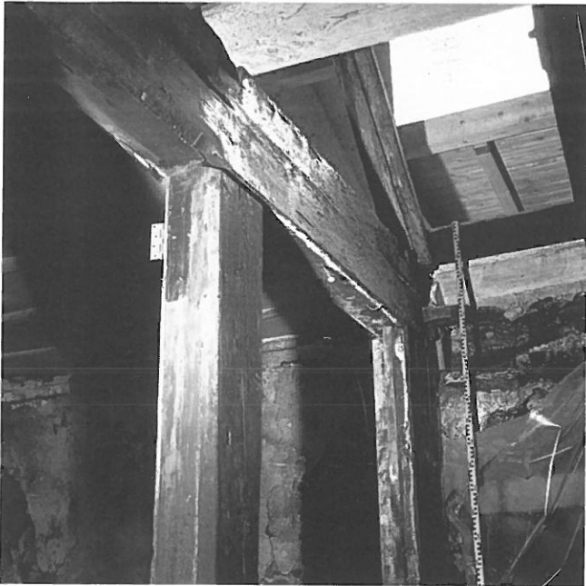
Abb. 27: Unterseen - Obere Gasse 42. Südwest-Stube des 2. Obergeschosses. Bohlenständerkonstruktion der Nordwand von 1653.
