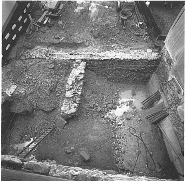
Abb. 14: Unterseen - Obere Gasse 42. Aufsicht auf Stadtmauer und städtiseitig anstossende älteste Gebäudemauer.
