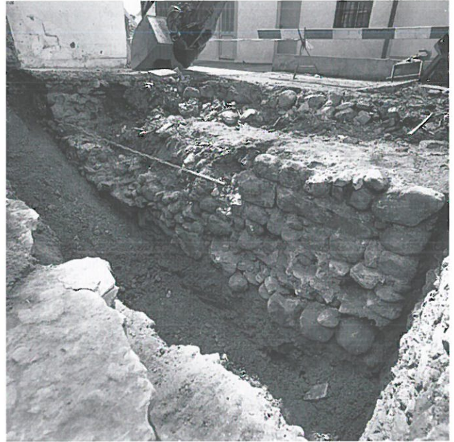
Abb. 18: Unterseen - Obere Gasse 42. Nördliches Fundament des Gründungsbaus. Rechts der Anstoss an die Stadtmauer.
