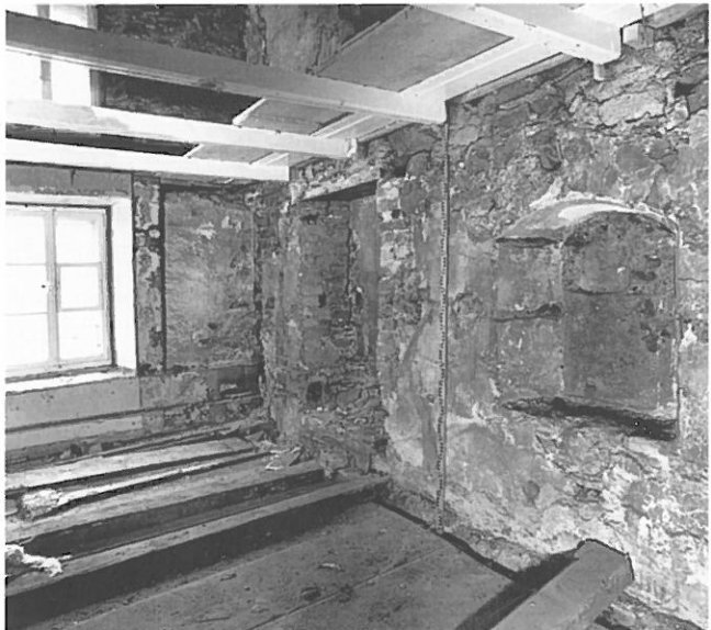
Abb. 21: Unterseen - Obere Gasse 42. Die Befunde in der südlichen Brandmauer des 1. Obergeschosses. Vgl. Abb. 8.
