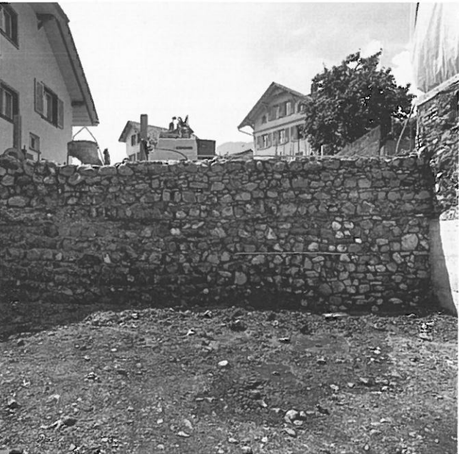
Abb. 12: Unterseen - Obere Gasse 42. Innenseite der Stadtmauer nach der Freilegung.
