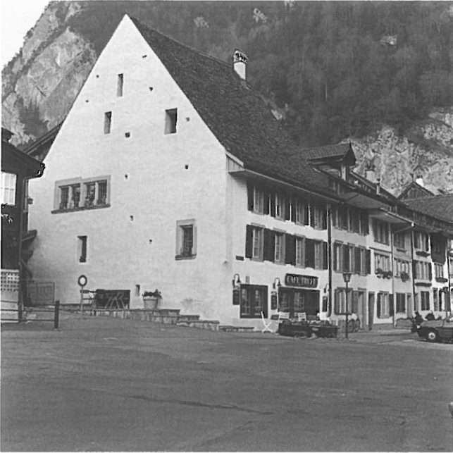
Abb. 11: Unterseen - Obere Gasse 42. Die heutige Liegenschaft von Südosten. Zustand nach der Restaurierung.
