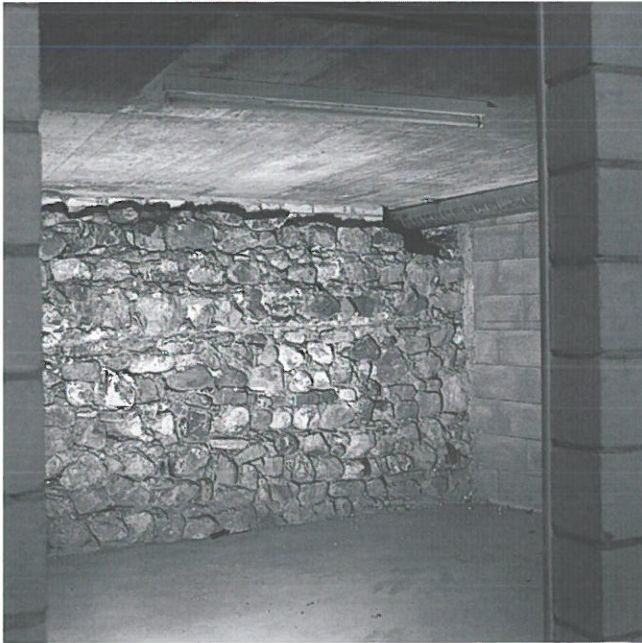
Abb. 16: Unterseen - Obere Gasse 42. Die im Keller konservierte Stadtmauer.
