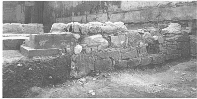
Abb. 123: Konventgebäude, Westtrakt. Ostmauer, südlicher Teil. Ansicht von Westen.
