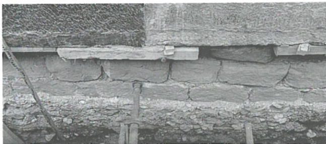
Abb. 38: Südseitenschiff. Fundament und unterste Lagen des aufgehenden Mauerwerks.
