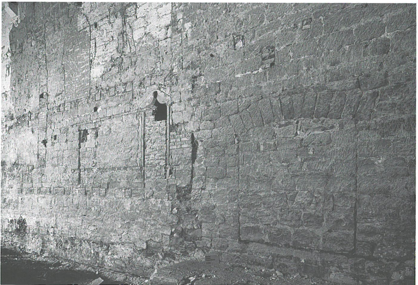
Abb. 44: Fassade Nordseitenschiff. Teilansicht mit westlicher Arbeitstüre.
