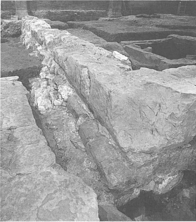
Abb. 117: Jüngere Kreuzgang-Westmauer auf Fundamenten der westlichen Rückmauer des älteren Kreuzganges aufsitzend. Ansicht gegen Norden.
