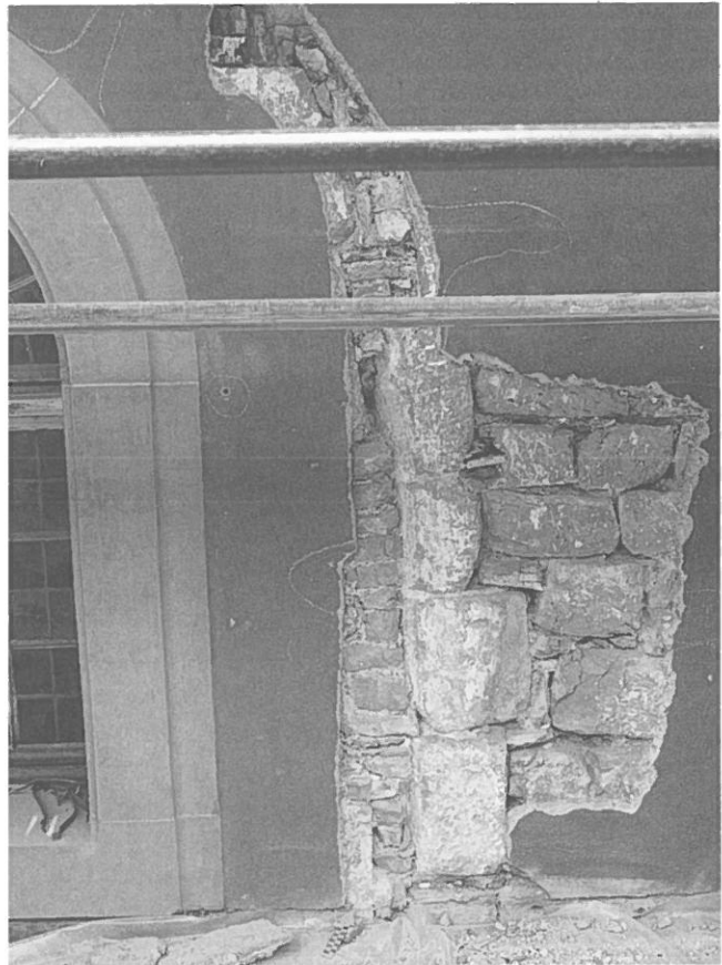
Abb. 53: Obergaden Südseite. Teile eines zum ursprünglichen Bestand gehörigen Spitzbogenfensters (Westseite).
