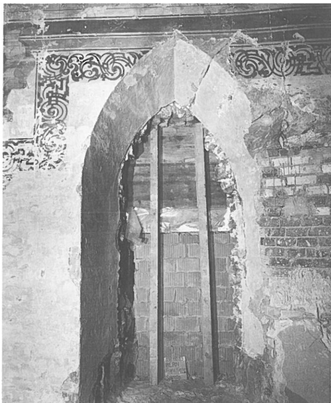
Abb. 64: Quergang, Nordwand. Freigelegtes Spitzbogenfenster.
