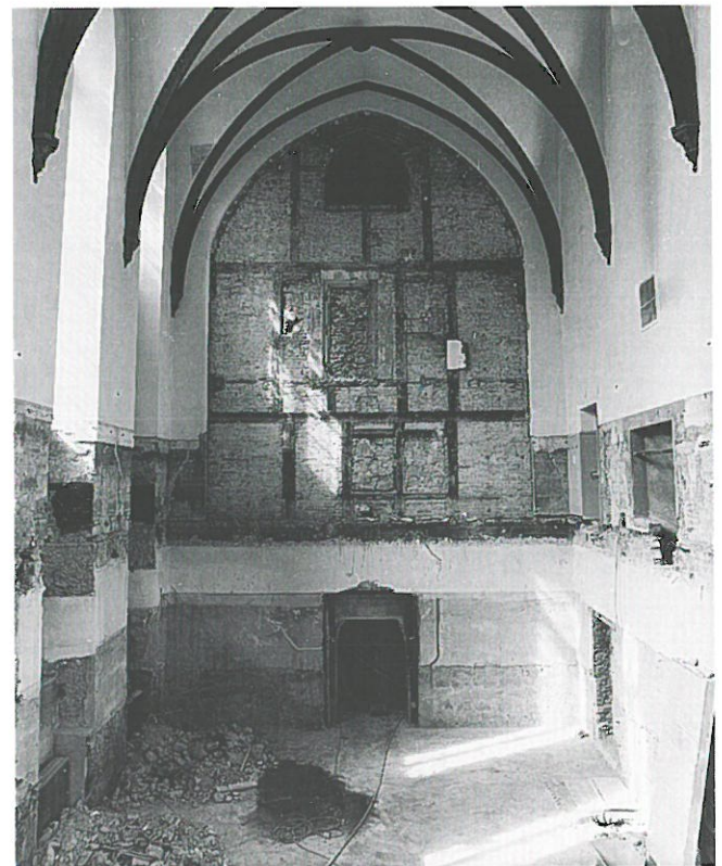
Abb. 14: Chor, Westwand, nach Abbruch des Zwischenbodens.
