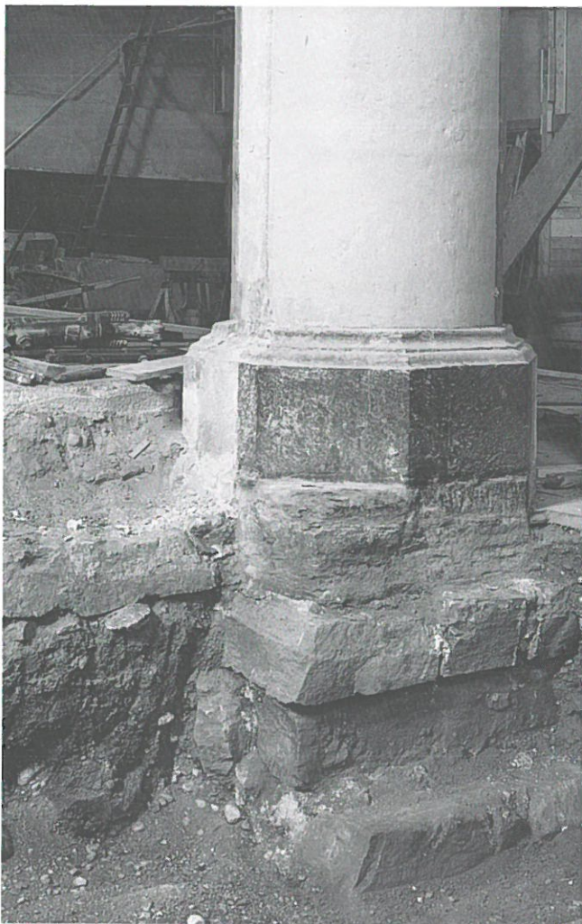
Abb. 57: Während der Sondierungen im Jahre 1950 freigelegtes Fundament einer Säule der Langhausarkade.
