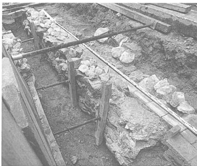
Abb. 37: Sondierung Predigergasse. Fundament der ehemaligen Westmauer von Südwesten.
