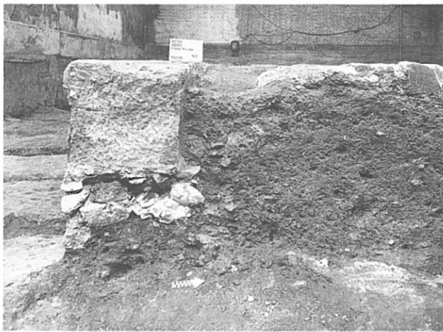
Abb. 118: Kreuzgang-Südflügel. Der massive Sandsteinblock der jüngeren Kreuzgangkonstruktion sitzt auf dem Fundament der älteren Kreuzgangmauer. Ansicht gegen Westen.
