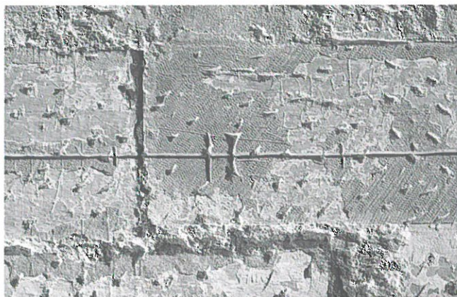
Abb. 79: Lettnerrückwand. Messstrecke, mittlerer Bereich.
