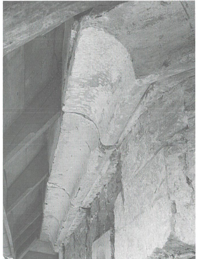
Abb. 51: Chor Südfassade. Traufgesims (Aufnahme von Renovation 1960er Jahre).
