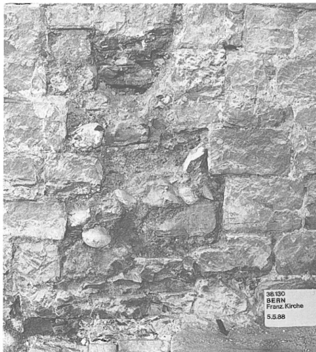
Abb. 49: Fassade Nordseitenschiff. Ausriss eines ursprünglichen Mauerverbandes (Westmauer des älteren Kreuzganges).
