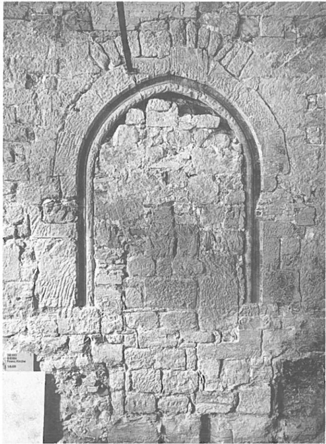
Abb. 45: Fassade Nordseitenschiff. In nachreformatorischer Zeit vermauertes Kirchenportal.
