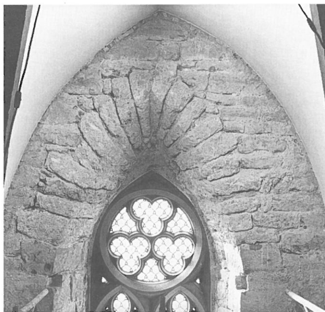
Abb. 26: Chor, Südwand. Bogen eines Spitzbogenfensters.
