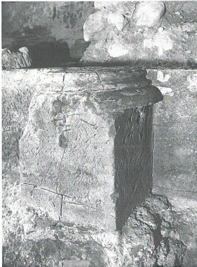
Abb. 109: Konventgebäude, Ostflügel. Sakristei-Ostwand mit Basis des Wanddienstes auf Sockel.
