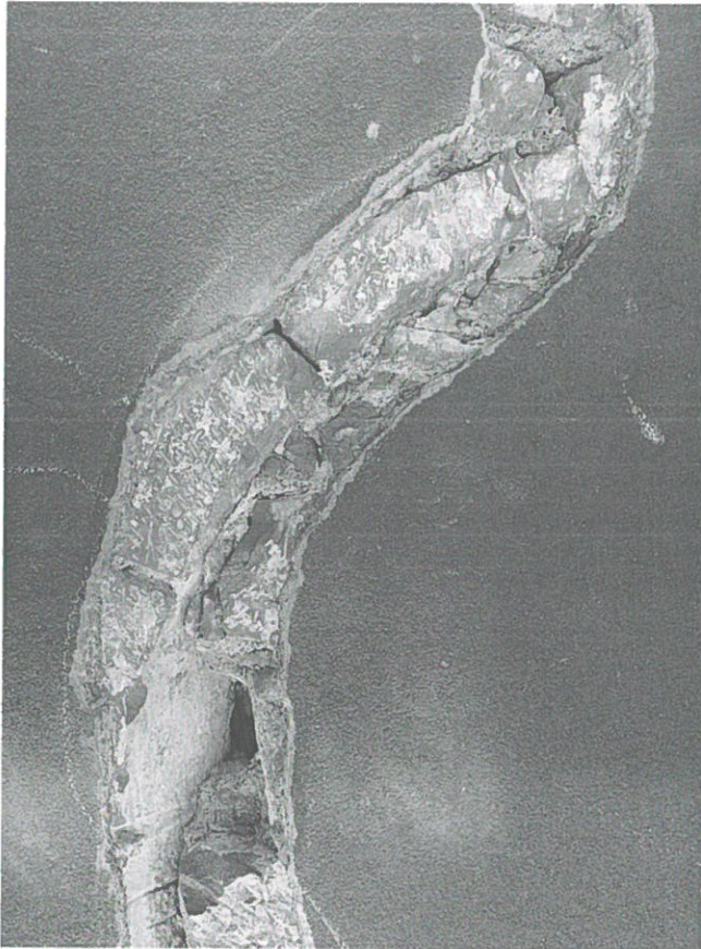
Abb. 54: Obergaden Südseite. Teile eines zum ursprünglichen Bestand gehörigen Spitzbogenfensters (Ostseite).
