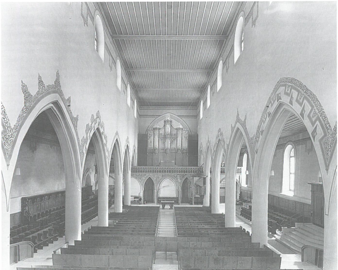
Abb. 56: Langhaus gegen Osten. Aufnahme vor der jüngsten Renovation.
