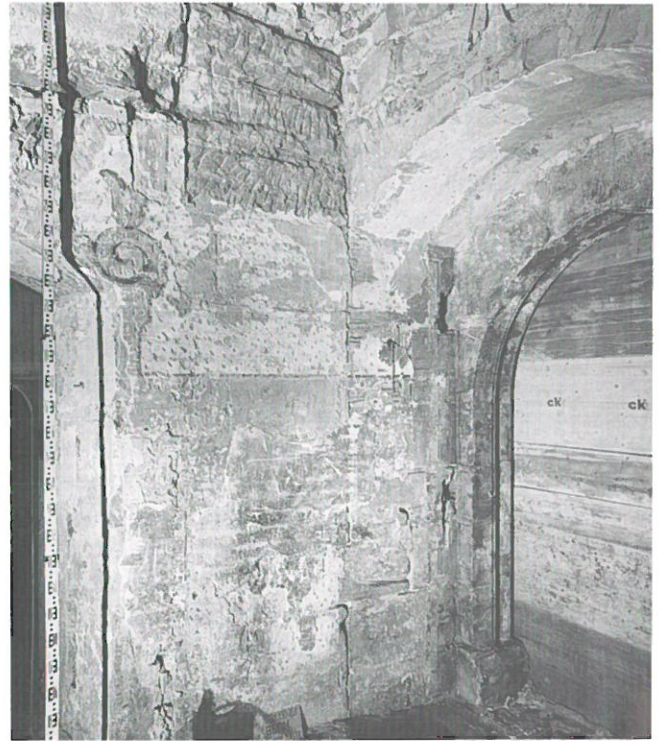
Abb. 62: Quergang, Nordwestecke, Anstoss der Lettnerrückwand gegen Kreuzgangportal. Oben Mitte sind die abgearbeiteten Werkstücke des Brückenbogens ersichtlich.
