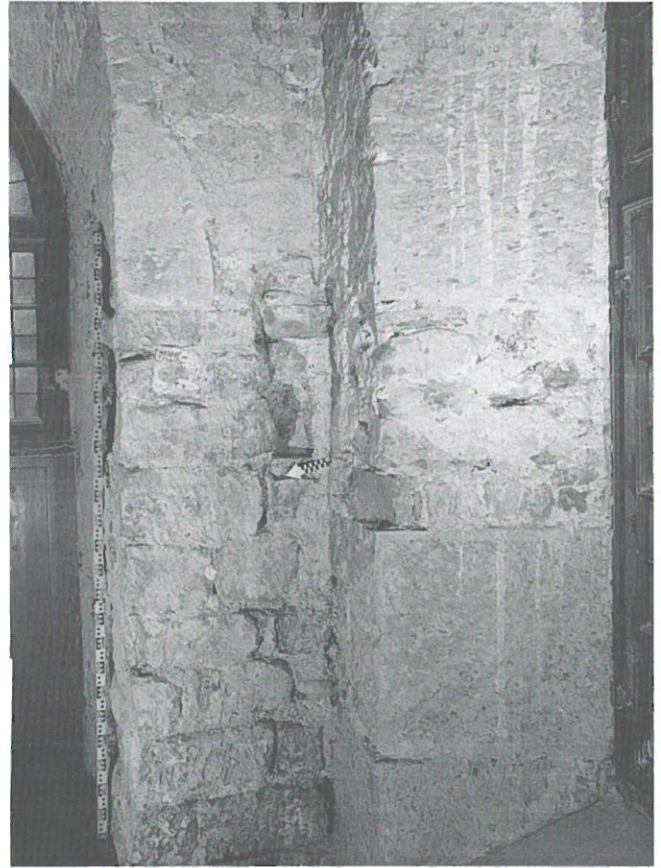
Abb. 66: Chorbogenwand, Südseite. Südlicher Teil der Bogenöffnung zur ehemaligen Marienkapelle.
