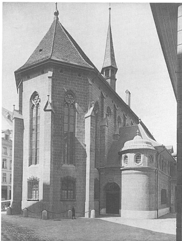
Abb. 2: Chor und Nordannex kurz nach der Fertigstellung der Renovation Indermühle (1912/13). Ansicht von Nordosten.
