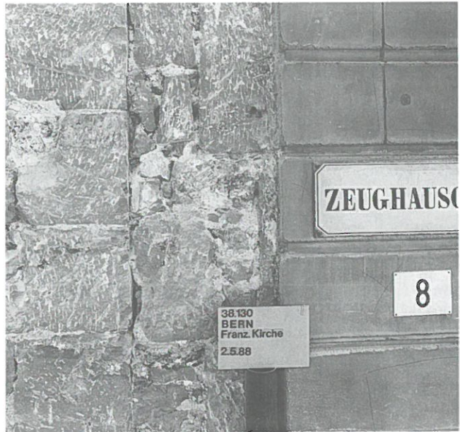
Abb. 39: Fassade Südseitenschiff. Links der ursprüngliche Verband der Südostecke.
