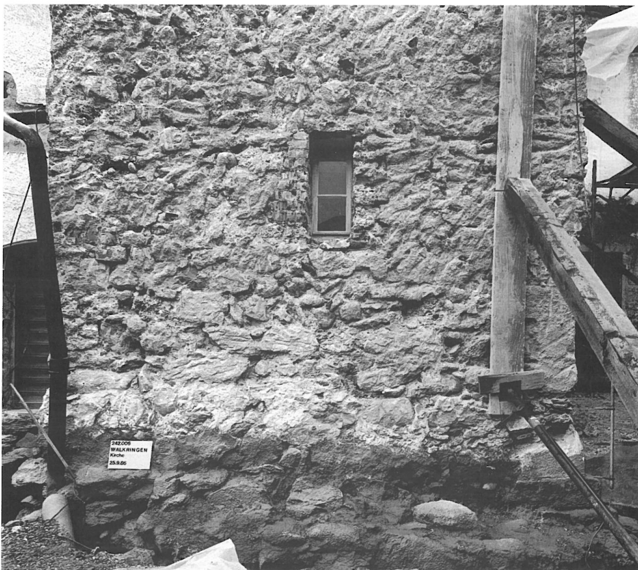
Abb. 31: Das Mauerwerk der ältesten Turmphase an der Südmauer.
