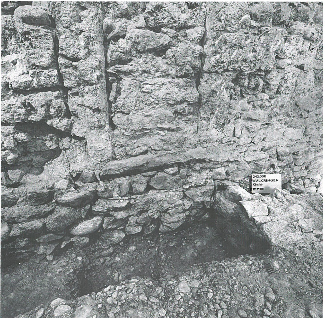
Abb. 17: Die nördliche Schulter der Apsisanlage bei der Sakristeitüre von 1514/15 (Nordrand der Kirche).
