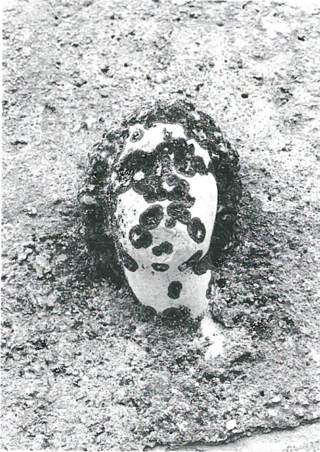
Abb. 2: Jünglingskopf im Westgiebel der Kirche von Walkringen BE, Vorderansicht. Ungereinigter Zustand.
