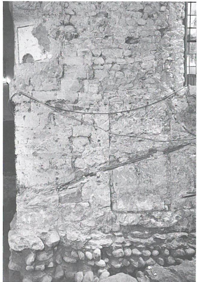
Abb. 15: Nordwestecke des Altarhauses.
