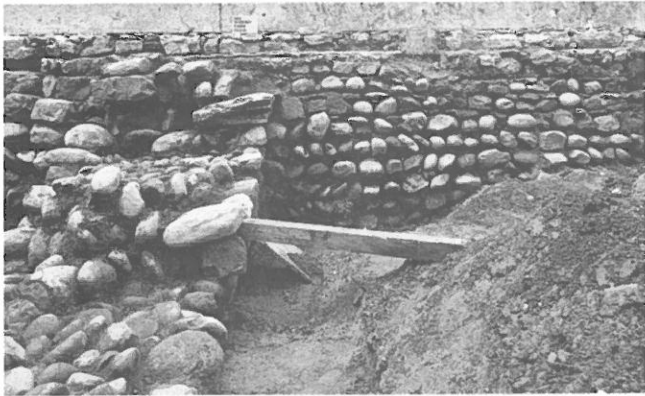
Abb. 8: Südmauer des Schiffes. Aussenseite des Fundamentes der Anlage I. Im Vordergrund Fundament der Klostergebäude.
