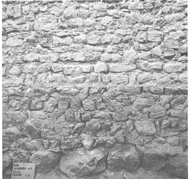
Abb. 9: Ostmauer des Altarhauses. Aufgehendes Mauerwerk der Anlage I im unteren Bereich, im oberen Drittel Strukturen der Anlage III.
