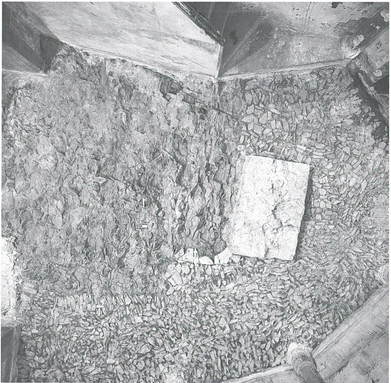
Abb. 14: Die Unterlage des Mörtelbodens im Altarhaus.
