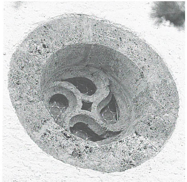
Abb. 33: Das Rundfenster in der Westmauer des Schiffes.
