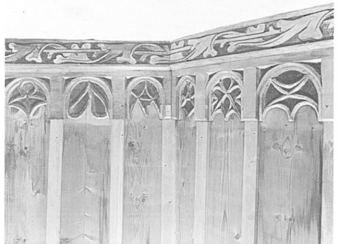
Abb. 36: Leistendecke. Stösse mit Blattranken (links) und mit Weinranken (Mitte). Die originalen Masswerkauflagen (links) und die feinere, vielleicht teilweise erneuerte Ausführung an der Westwand (rechts).
