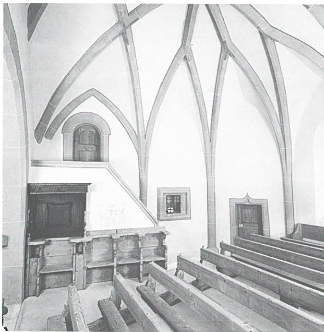
Abb. 41: Das Rippengewölbe des Chores.
