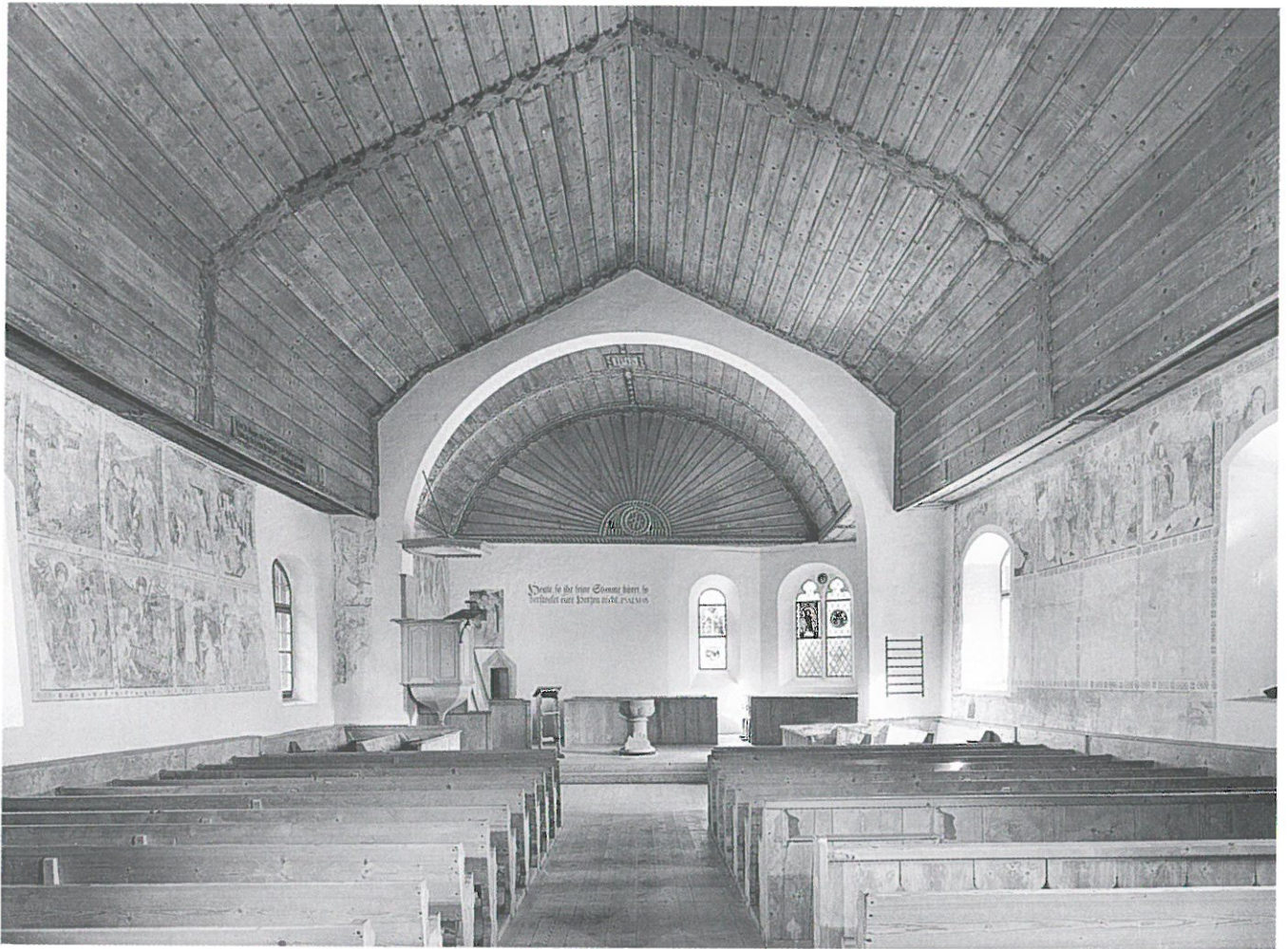
Abb. 49: Die Holzdecken in der Kirche von Zweisimmen (St. Maria)
