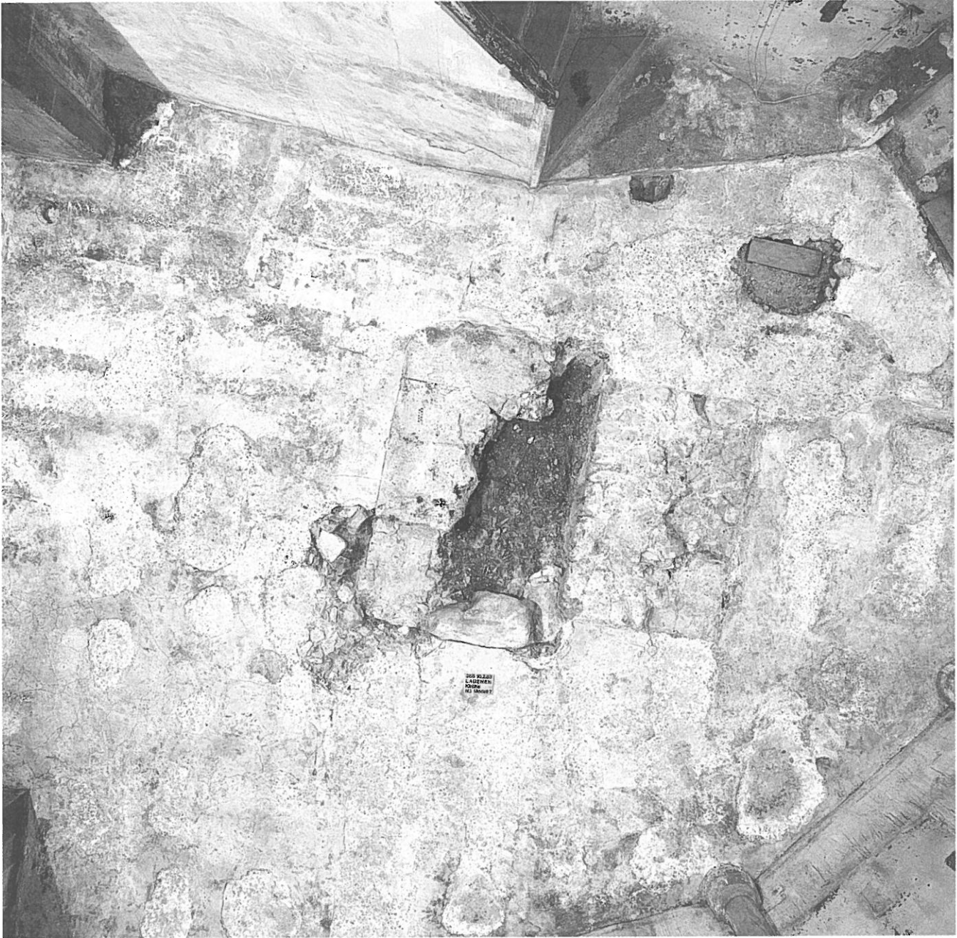
Abb. 13: Mörtelboden im Altarhaus und Altarfundament.
