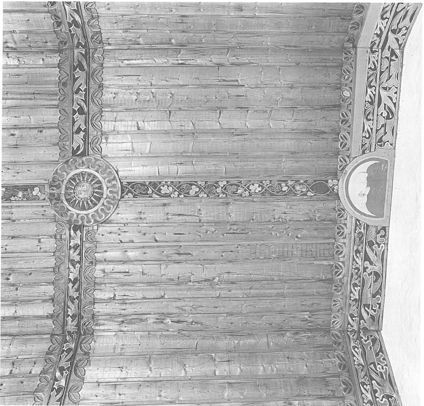
Abb. 35: Die gewalzte Leistendecke des Schiffes (links der westliche, rechts der östliche Teil).
