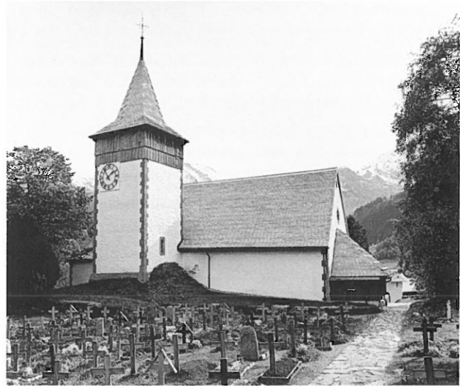
Abb. 2: Die Nordseite der Kirche mit Turm und Friedhof.
