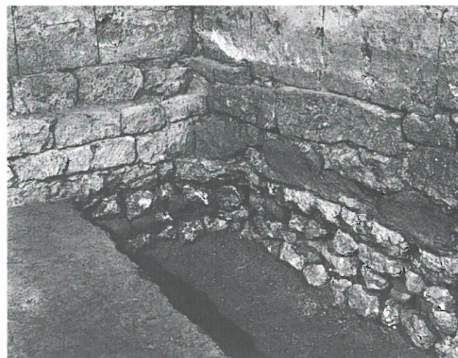
Abb. 9: Ansicht an die südwestliche Ecke des romanischen Schiffes.
