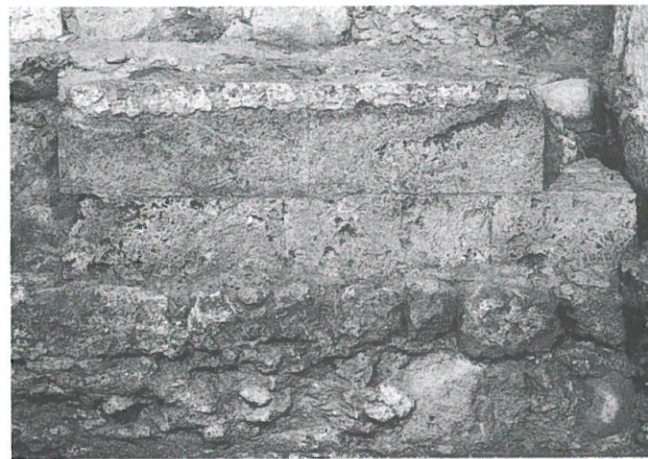
Abb. 10: Ansicht an die Südwand des romanischen Altarhauses.
