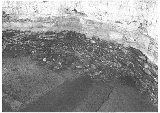
Abb. 27: Die mit Steinmaterial gefüllte Grube (gegen Nordosten).
