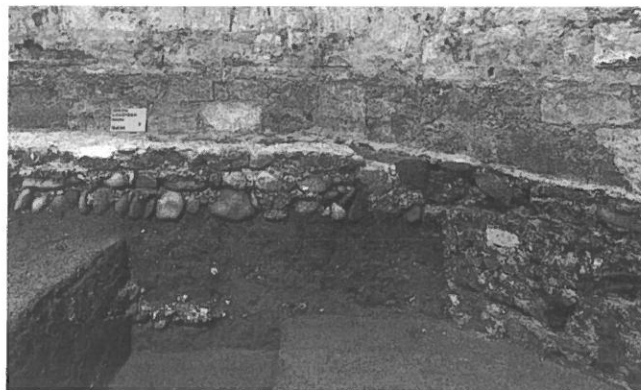
Abb. 31: Die südliche Seite des Altarhauses von 1521 mit der älteren Umfassungsmauer.
