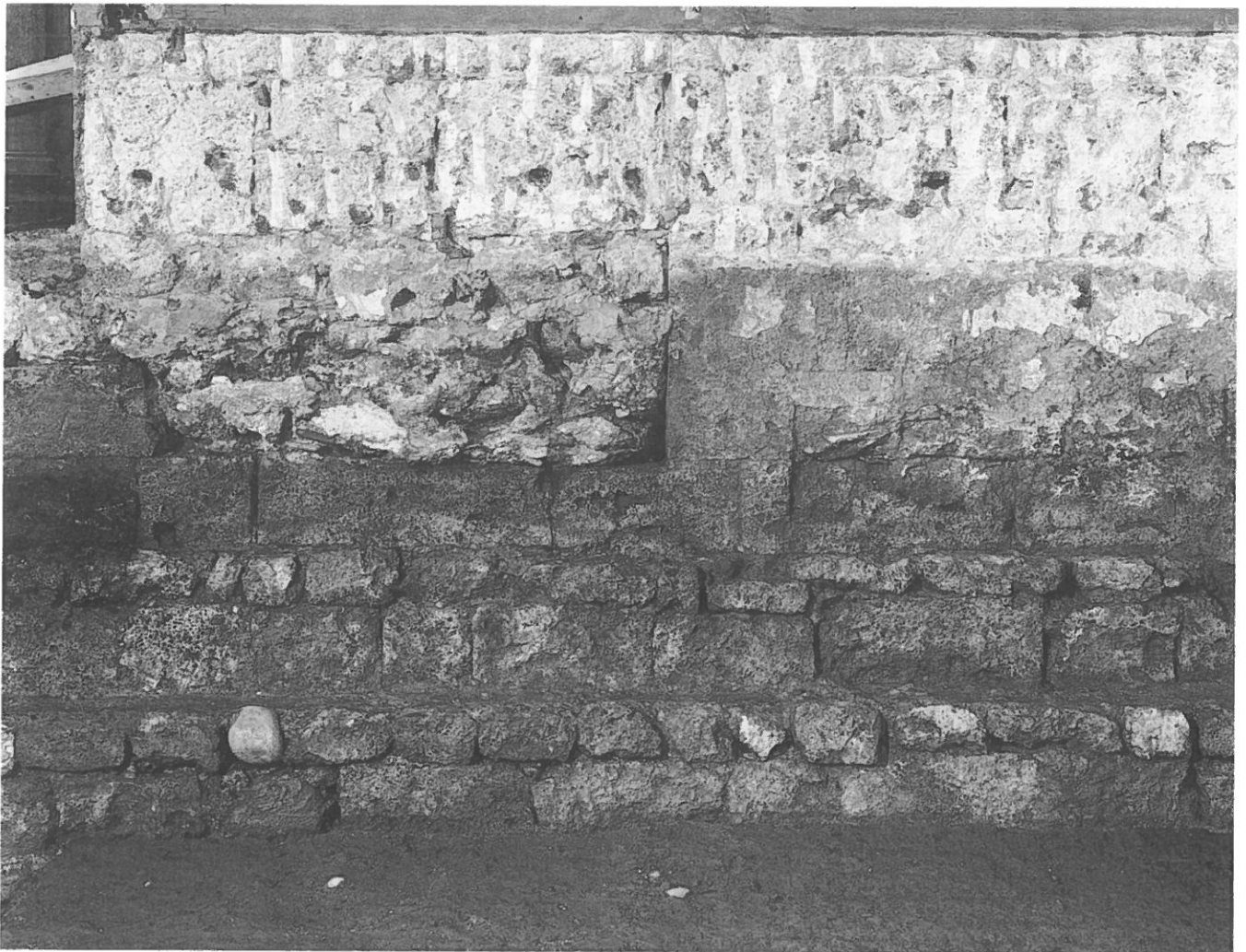
Abb. 7: Ansicht an die Südwand des romanischen Schiffes (mit den Strukturen des älteren südlichen Eingangs).
