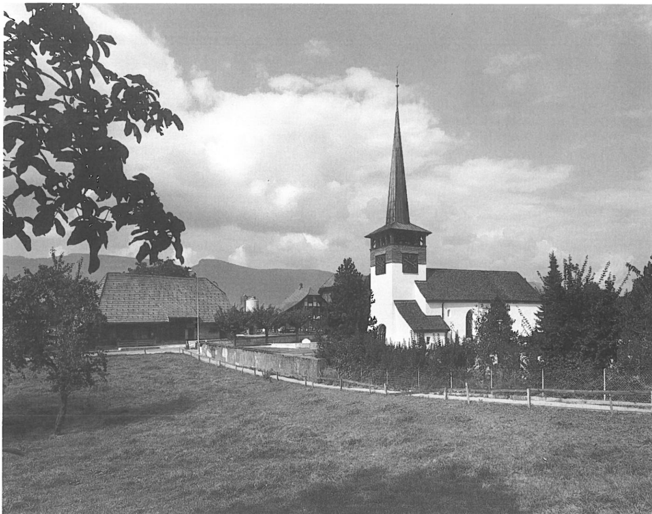
Abb. 3: Die Südseite der Kirche nach der Restaurierung von 1986/87.
