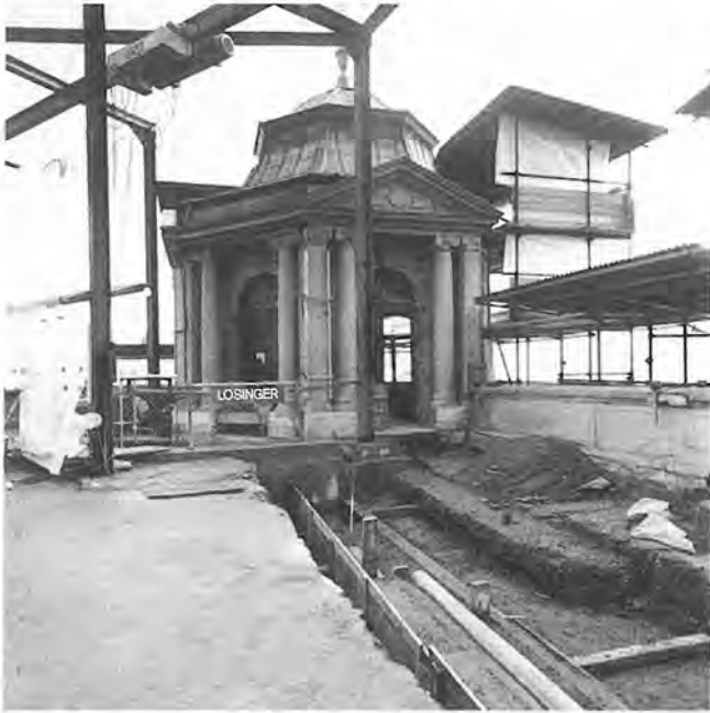
Abb. 2: Der südwestliche Pavillon mit dem Sanierungsschacht.
