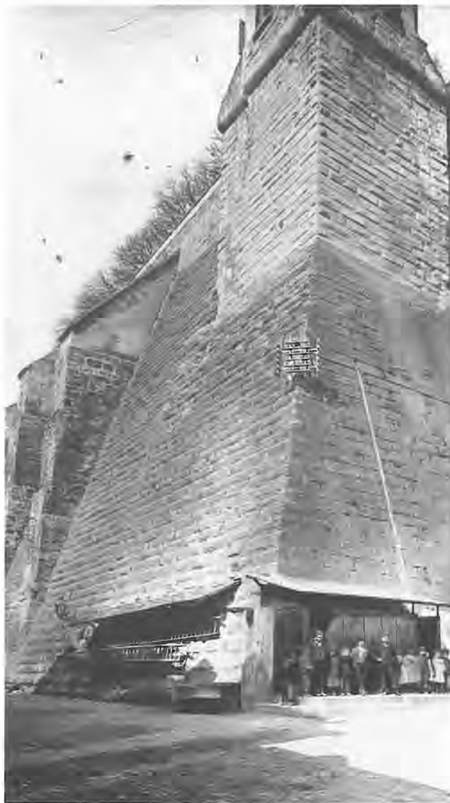
Abb. 90: Südostecke der Plattform mit bossenquadrierter Böschungsmauer unter dem Schaft des Eckpavillons, nach 1506. Deutlich sichtbar sind die gleichsam in der Böschungsmauer ertrunkenen Strebepfeiler, am vordersten eine schräge Nut eines Dachansatzes. Vgl. Abb. 18 ff.
