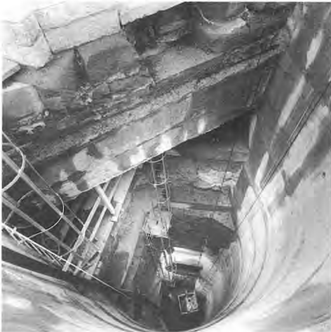
Abb. 3: Einblick in den Sanierungsschacht.
