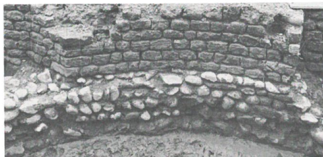
Abb. 51: Tschugg. Rundbau, östlicher Kreisvorsprung mit zwei Aussparungen für eine Aufhängevorrichtung (?).
