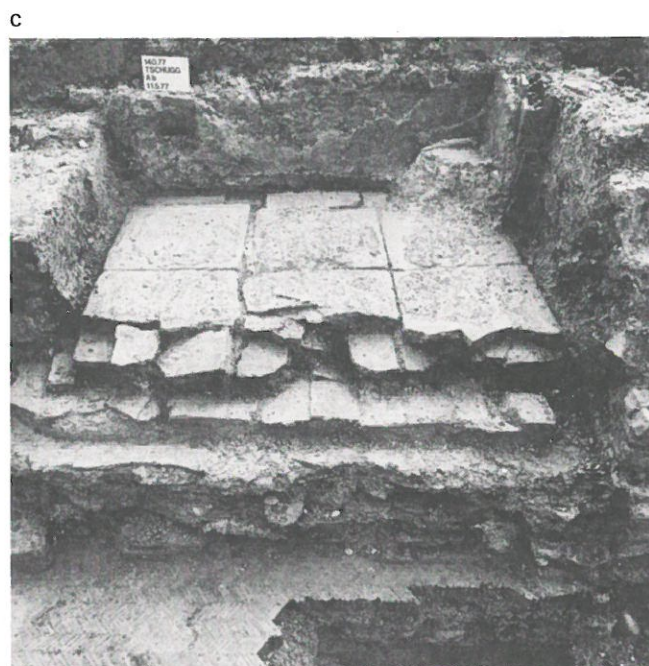
Abb. 64: Tschugg. Raum A/b, Bauvorgänge des Alveusanbaus: a) Ziegelboden als Unterlage für Hypokauststützen, b) Hypokauststützen, c) Suspensurplatten, d) Mörteldecke über Suspensurplatten mit Hohlziegeln und Marmorverkleidung an den Wänden.
