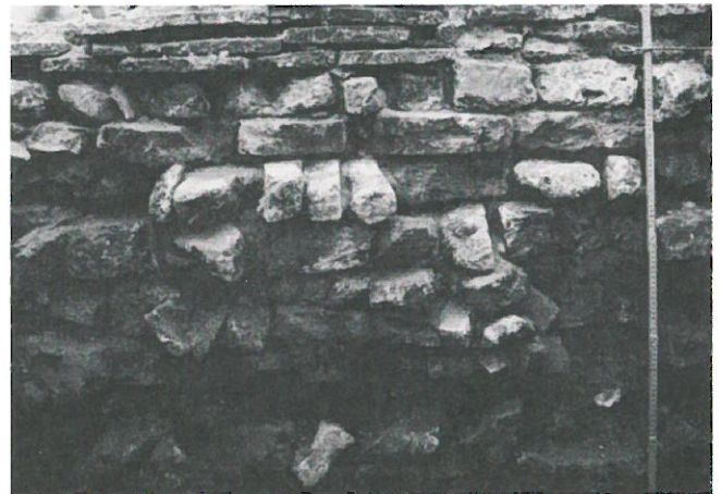
Abb. 25: Tschugg. Zwischenmauer B/b – C/b mit Ziegelverkleidung auf der sichtbaren West- (links) und unregelmässiger Technik auf der verdeckten Ostseite (rechts).
