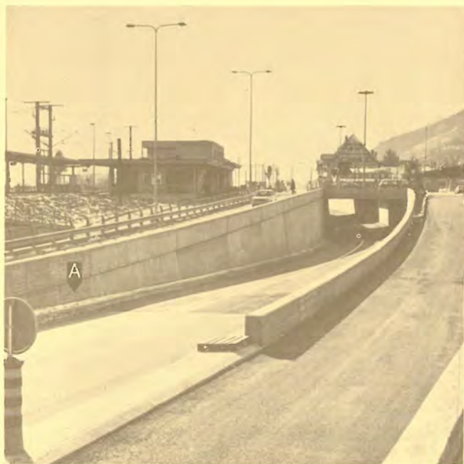
Fig. 20: Douanne. A = devant la gare, le passage sous voie de la route nationale 5 a justifié et limité l'emplacement des fouilles. Son niveau le plus bas correspond approximativement à la surface des couches archéologiques (voir l'emplacement fig. 19).
