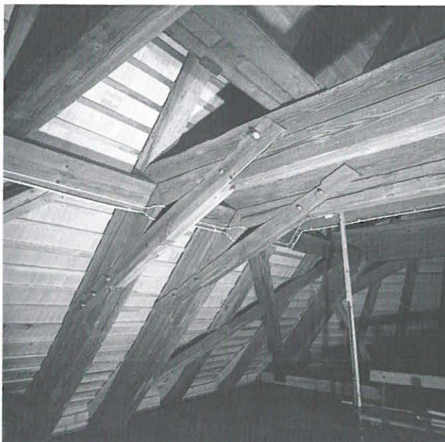
Abb. 16: Kopfhölzer der Dachstuhlkonstruktion des 17. Jahrhunderts.
