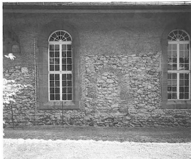
Abb. 61: Bolligen, Kirche. Nordfassade mit vermauertem Rundbogenportal im romanischen Schiff.
