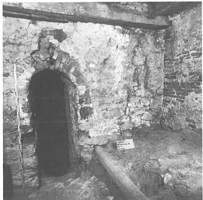
Abb. 119: Laufingen, ehem. Ziegelscheune. Die Beschickungsöffnung des Brennofens 2.
