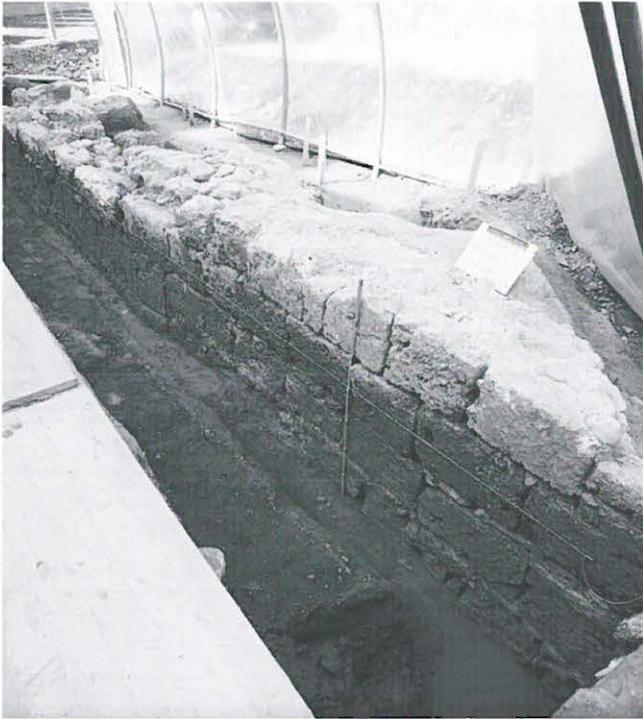
Abb. 12: Ein Teil der Stadtmauer (G07/I07) im Bereich des späteren Stadtplatzes ist aufgrund des Mauercharakters noch im 14. Jahrhundert erbaut oder erneuert worden.
