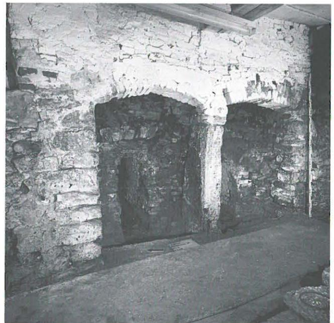
Abb. 121: Laufen, ehem. Ziegelscheune. Die Einf Feuerungsöffnungen des Ofens 2.
