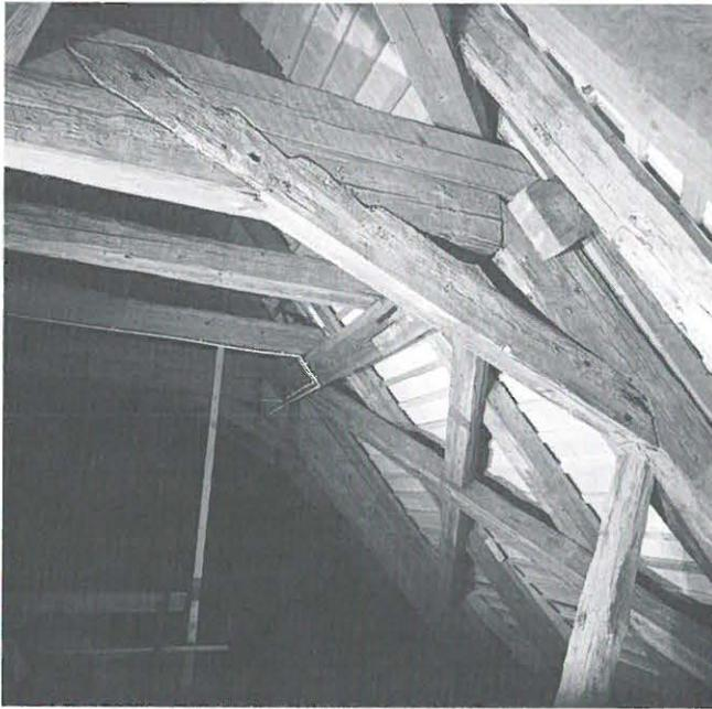
Abb. 15: Kopfhölzer eines wiederverwendeten Gebindes aus dem 16. Jahrhundert.
