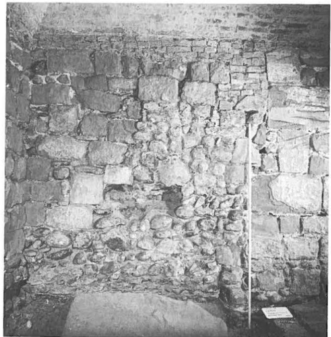
Abb. 13: Innenansicht der Westmauer im Untergeschoss mit dem alten Bestand links, der Baunaht im Bereich des Massstabes und der spätmittelalterlichen Erneuerung rechts.
