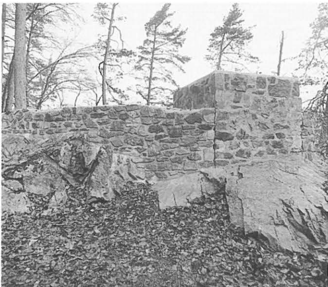
Abb. 336: Matten, Galgen. Pfeilerdetail nach Konservierung.
