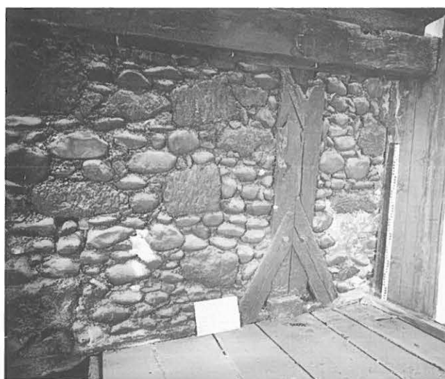
Abb. 312: Laupen, Kreuzplatz 1. Mauerwerk der Phase IV (Brandmauer Nordost) mit Ummantelung eines Ständers mit Fusshölzern der Phase III.
