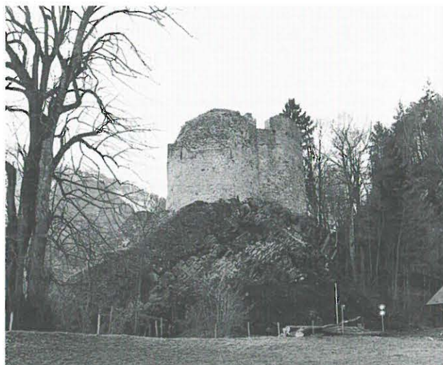
Abb. 471: ...und nach der Sanierung und Felsreinigung 1993.
