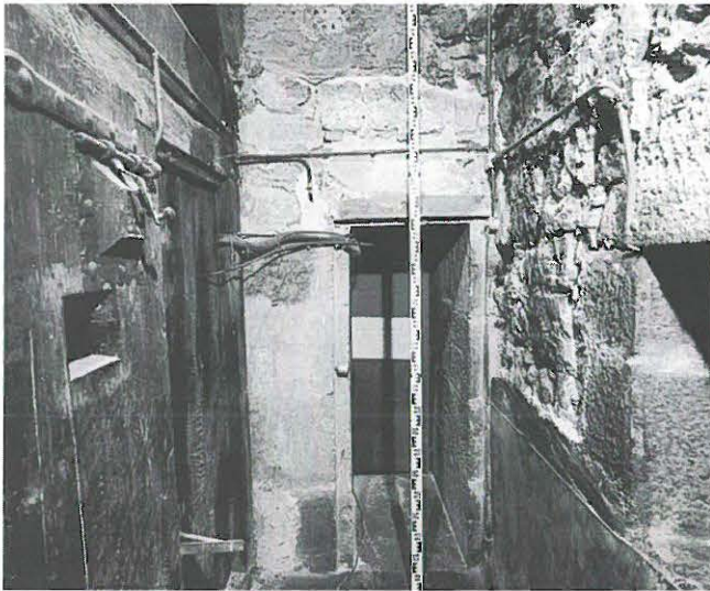
Fig. 373: La Neuveville, Tour de Rive. Intérieur au 1 er étage. A gauche, les cellules en bois (28), tout au fond la porte de communication (27) avec l'église.
