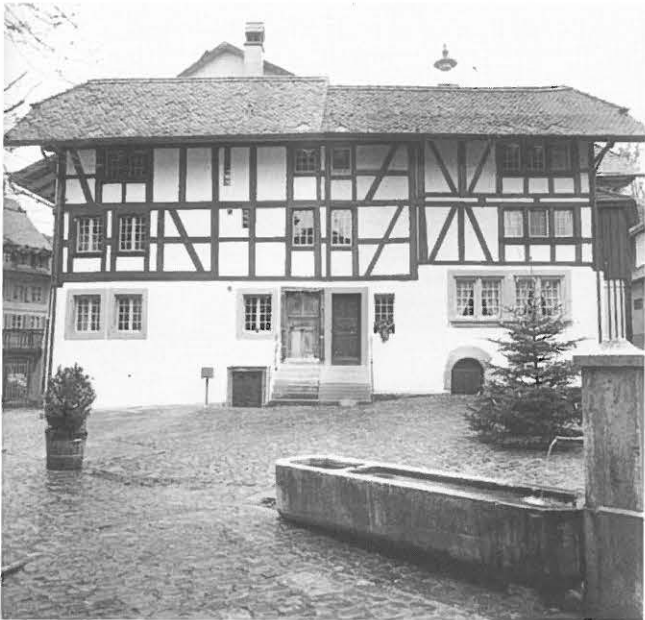
Abb. 303: Laupen, Kreuzplatz 1. Die Häuser 1 und 3 von Westen. Zustand nach der Restaurierung 1993.
