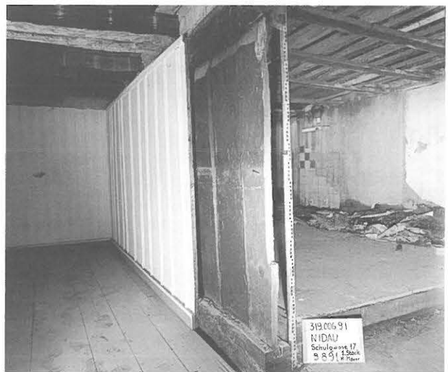
Abb. 390: Nidau, Schulgasse 17. Im «Sandwich» verpackter Bohlenwandrest (Abb. 389: 18a) des 16. Jahrhunderts im 1. Obergeschoss.
