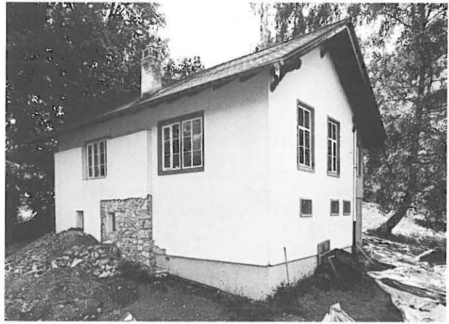
Abb. 503: Zweisimmen, Unterweisungshaus. Blick von Nordosten an den Kernbau.
