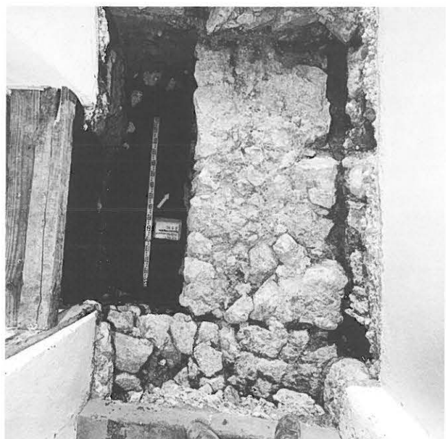
Abb. 386: Nidau, Schulgasse 17. Anschluss der Mauer (2) an die Stadtmauer (1).
