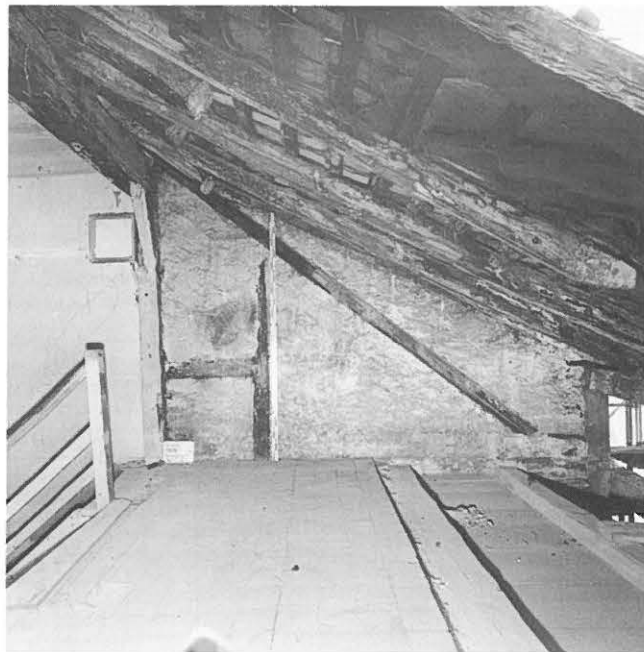
Abb. 428: Thun, Obere Hauptgasse 11. Phase III, Ansicht der Westmauer im 4. Obergeschoss.
