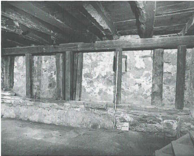
Abb. 216: Befunde im Keller nach Norden.
