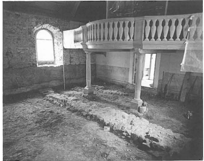
Abb. 176: Boltigen, Kirche. Im Vordergrund liegt das Mauerfundament des Westabschlusses der Phase I und im Hintergrund befindet sich das Fundament eines Vorbaus (oder Westverlängerung).
