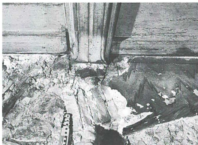
Fig. 359: La Neuveville, Rue du Collège 21. Solive moulurée.
