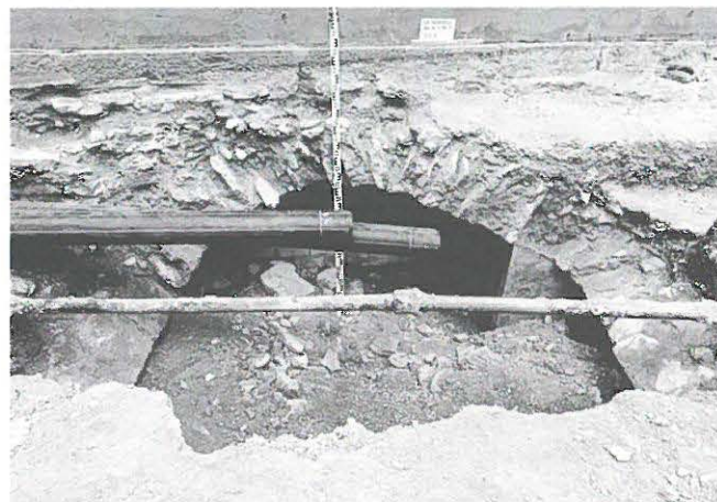
Fig. 365: La Neuveville, Rue du Tempé. Découverte d'une cave voûtée, vue vers l'ouest sous la voûte inférieure.
