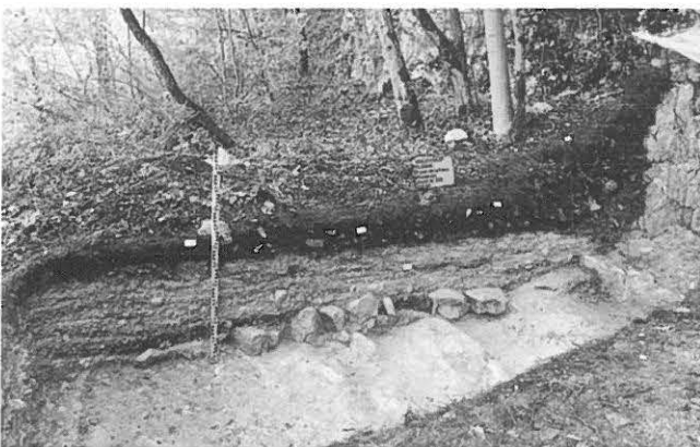
Abb. 133: Vauffelin - Forêt de la Paroi. Cette straggraphie montre plusieurs niveau de l'ancienne route. Est-ce que les couches les plus profondes correspondent à la route antique? Vue vers l'ouest.
