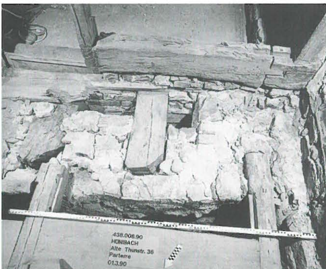
Abb. 217: Mauerkrone der Nordwestecke des Kernbaues.
