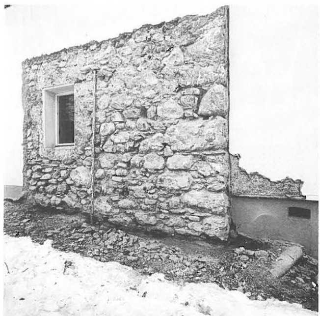
Abb. 504: Zweisimmen, Unterweisungshaus. Detail der Mauersondage an der Nordostecke.
