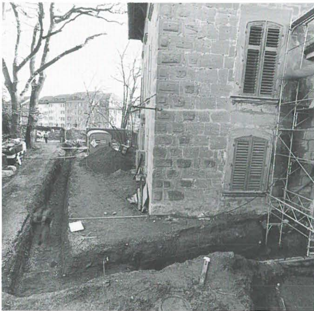
Abb. 149: Bern, Schloss Holligen. Nordwestecke des Wohnturmes von Westen mit Leitungsgräben 1993.
