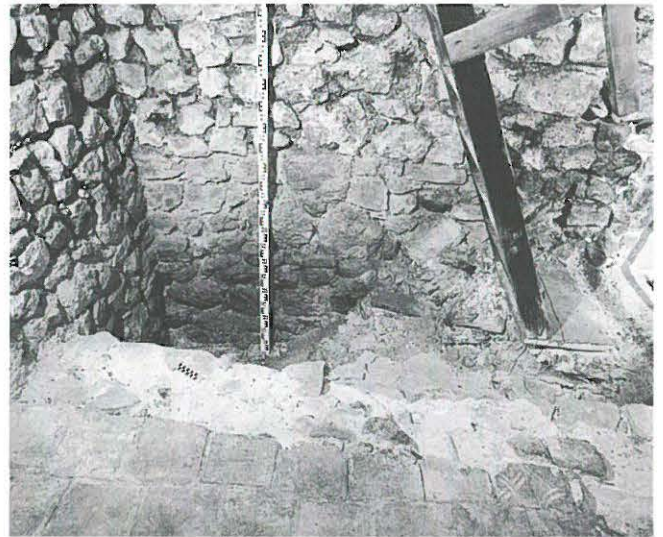
Fig. 376: La Neuveville, Tour de Rive. 2 e étage: sol de dalles en terre cuite (34) et mur de séparation (33), vus vers l'est.
