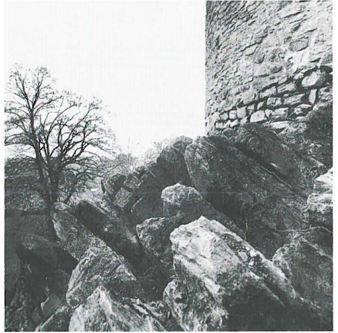
Abb. 480: Wilderswil, Unspunnen. Detail der Felsplatten nach der Reinigung 1993.
