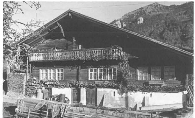
Abb. 182: Brienzwiler, Staatsstrasse 4. Südansicht.
