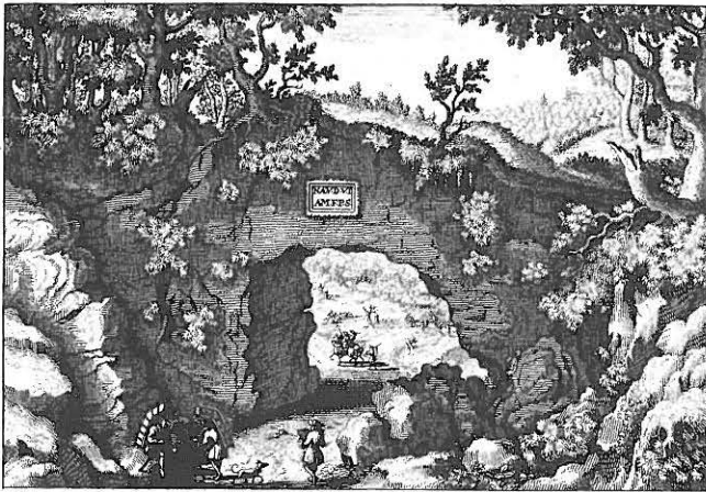
Fig. 124: Tavannes - Pierre Pertuis. Tunnel de Pierre Pertuis. Vue de la route au milieu du 17 e siècle (tiré de Ruchat 1714).
