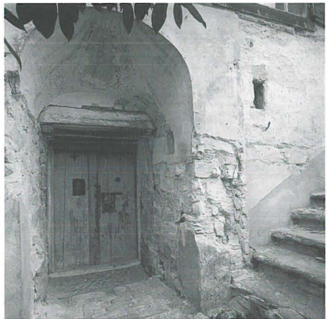
Abb. 211: Hilterfingen, alte Thunstrasse 36. Detail Kellerportal.
