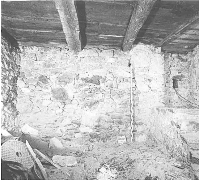
Abb. 186: Brienzwiler, Staatsstrasse 4. Detail Ostmauer des Kernbaus, vgl. Plan Abb. 185.
