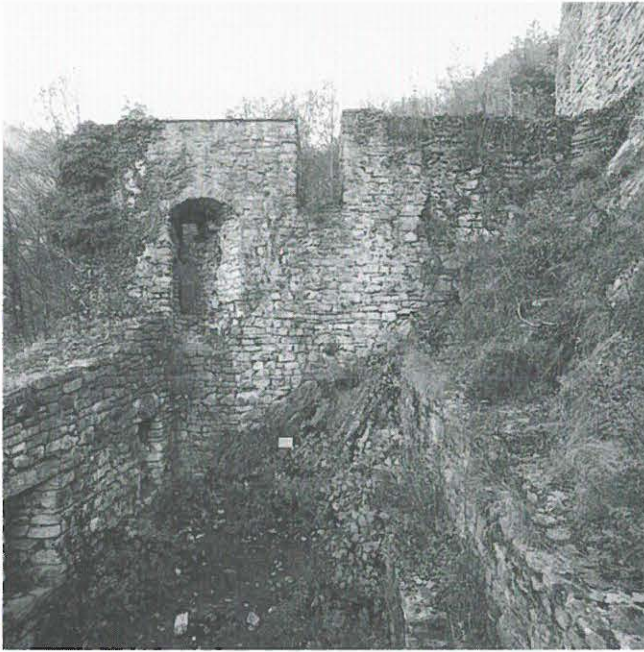
Abb. 478: Wilderswil, Unspunnen. Südpalas. Blick an die Westwand vor der Sanierung...
