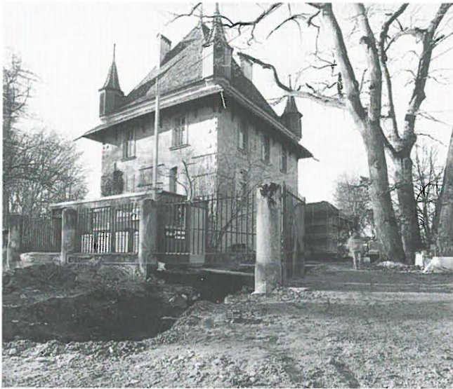
Abb. 148: Bern, Schloss Holligen. Ansicht von Nordosten mit Leitungsgräben 1993.
