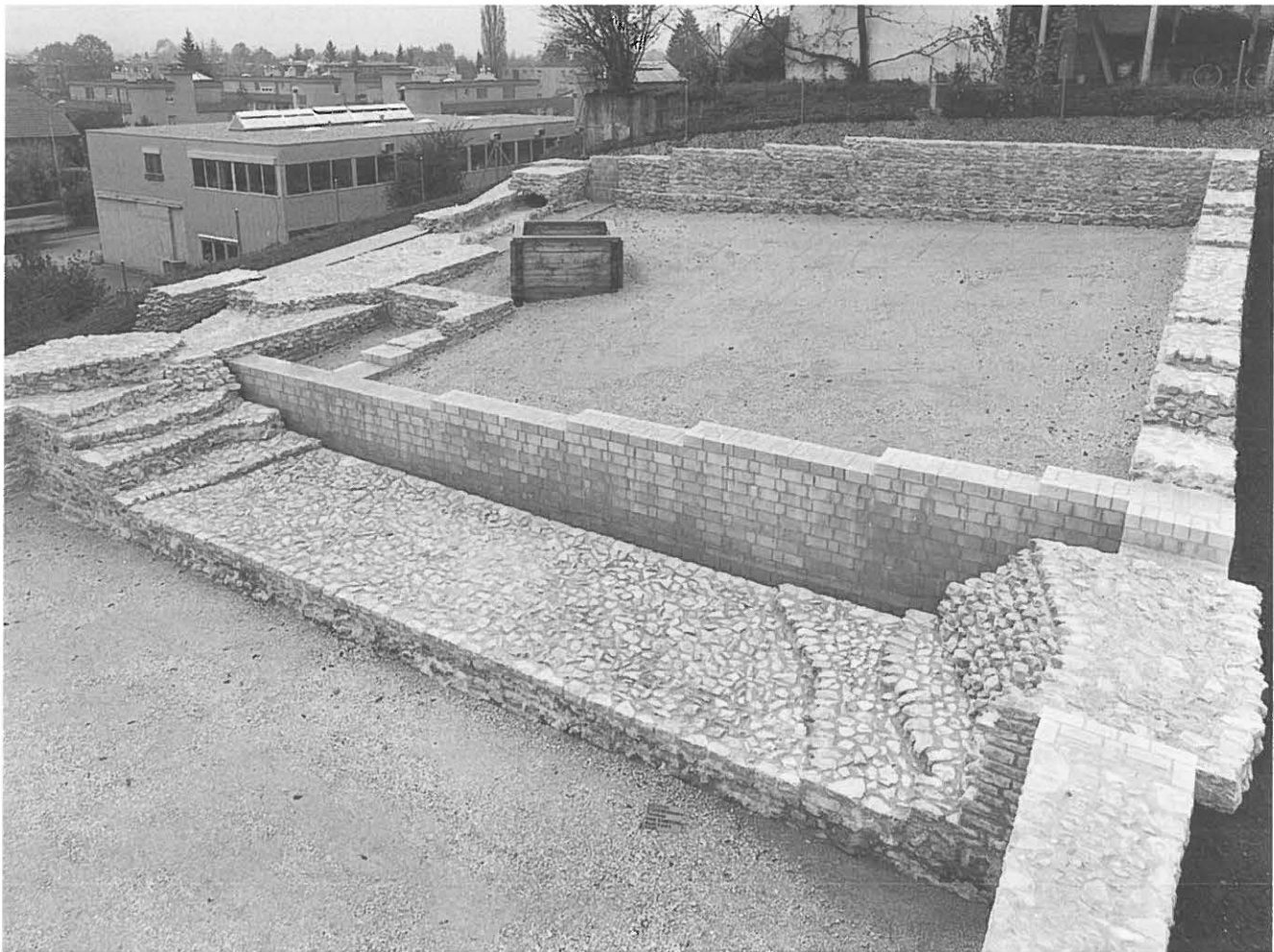
Abb. 117: Studen - Grabefeld / Petinesca 1993–96. Sanierungsetappe 1995. Die Innenfläche des hangwärtigen Gebäudetraktes ist mit beige Mergelsplitter gekennzeichnet. Er ist sowohl während der jüngeren als auch in der älteren Steinbauphase durch eine Quermauer unterteilt (breite Kalksteinmauer der 2. Bauphase bzw. neue Kalksandsteinmauer der 1. Bauphase). Das Gelniveau lag auch in römischer Zeit auf verschiedenen Ebenen. Blickrichtung Süden.
