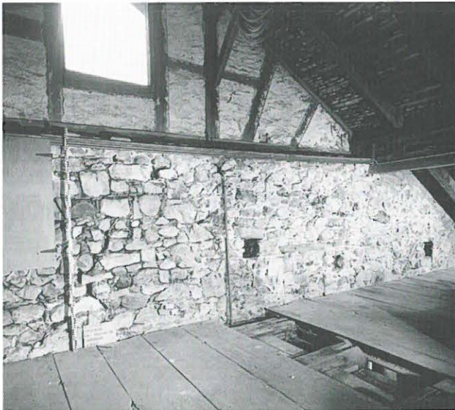
Abb. 222: Hilterfingen, alte Thunstrasse 36. Dachgeschoss. Ansicht der südlichen Giebelmauer mit älterer Schräge.
