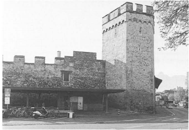
Abb. 438: Thun, Venner-Zyro-Turm mit Stadtmauer. Zustand 1993.
