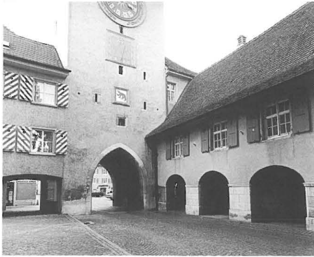
Abb. 290: Laufen BL, Alter Polizeiposten und Obertor von Süden. Zustand 1991.
