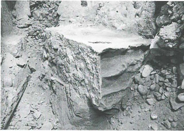
Abb. 142: Bern, Bundesgasse 20. Detail der inneren Grabenmauer. Deutlich sichtbar ist die stark ausgewitterte einstige Front im Bild rechts.
