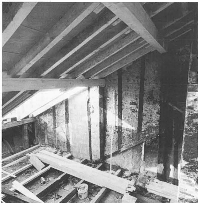
Abb. 429: Thun, Obere Hauptgasse 9. Phase III, Ansicht der Westmauer im 4. Obergeschoss.
