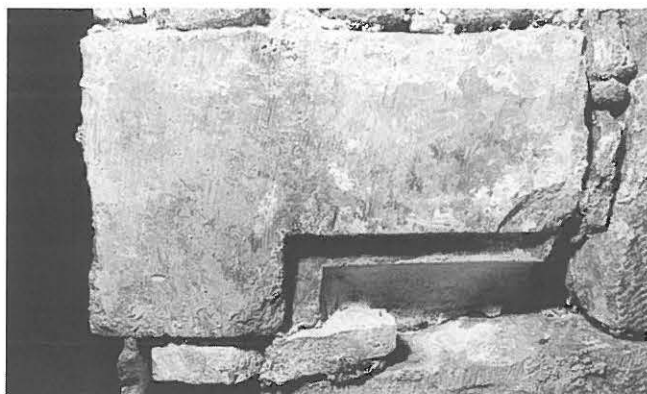
Fig. 360: La Neuveville, Rue du Collège 21. Remploi de fenêtres dans la maçonnerie.
