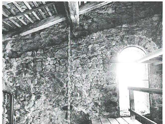
Fig. 377: La Neuveville, Tour de Rive. Secteur du toit avec le réhaussement (35) vu vers l'est.
