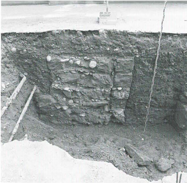
Abb. 192: Burgdorf, Mühleitor. Die Stadtmauer nach Norden, rechts die Quader der ehem. gegen den Graben sichtbaren Aussenseite.
