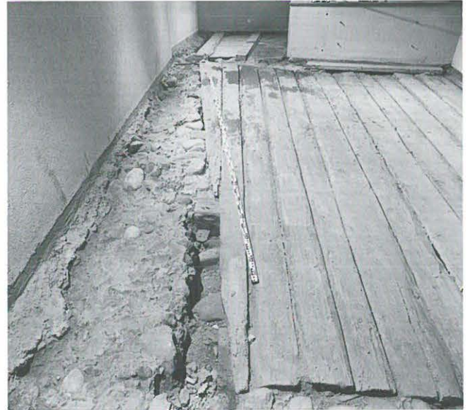
Abb. 318: Laupen, Marktgasse 4. Die Abbruchkronen der zur Vergrösserung des Raumes zurückgeschroteten Stadtmauer. Blick nach Nordosten.
