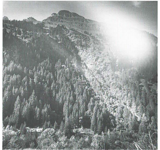
Abb. 324: Lauterbrunnen, Trachsellaunen. Blick von Osten auf die Verhüttungsanlage, Zustand 1994.
