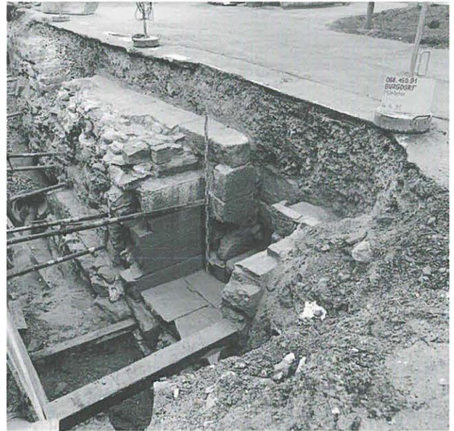
Abb. 193: Burgdorf, Mühleitor. Fundament des steinernen Fahrdammes nach Westen.
