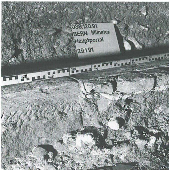
Abb. 161: Bern, Münsterportal. Sandsteinschwelle mit Abtreppung zur Aufnahme der abschliessenden Tonplatten.
