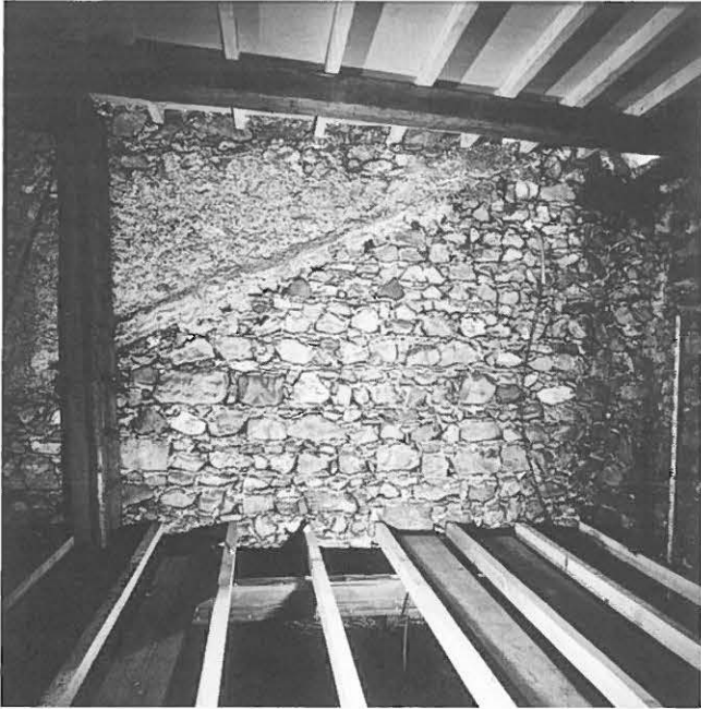
Abb. 424: Thun, Freienhofgasse 20. Südliche Brandmauer: Wechsel von Mauerwerk (2) zu Mauerwerk (4).
