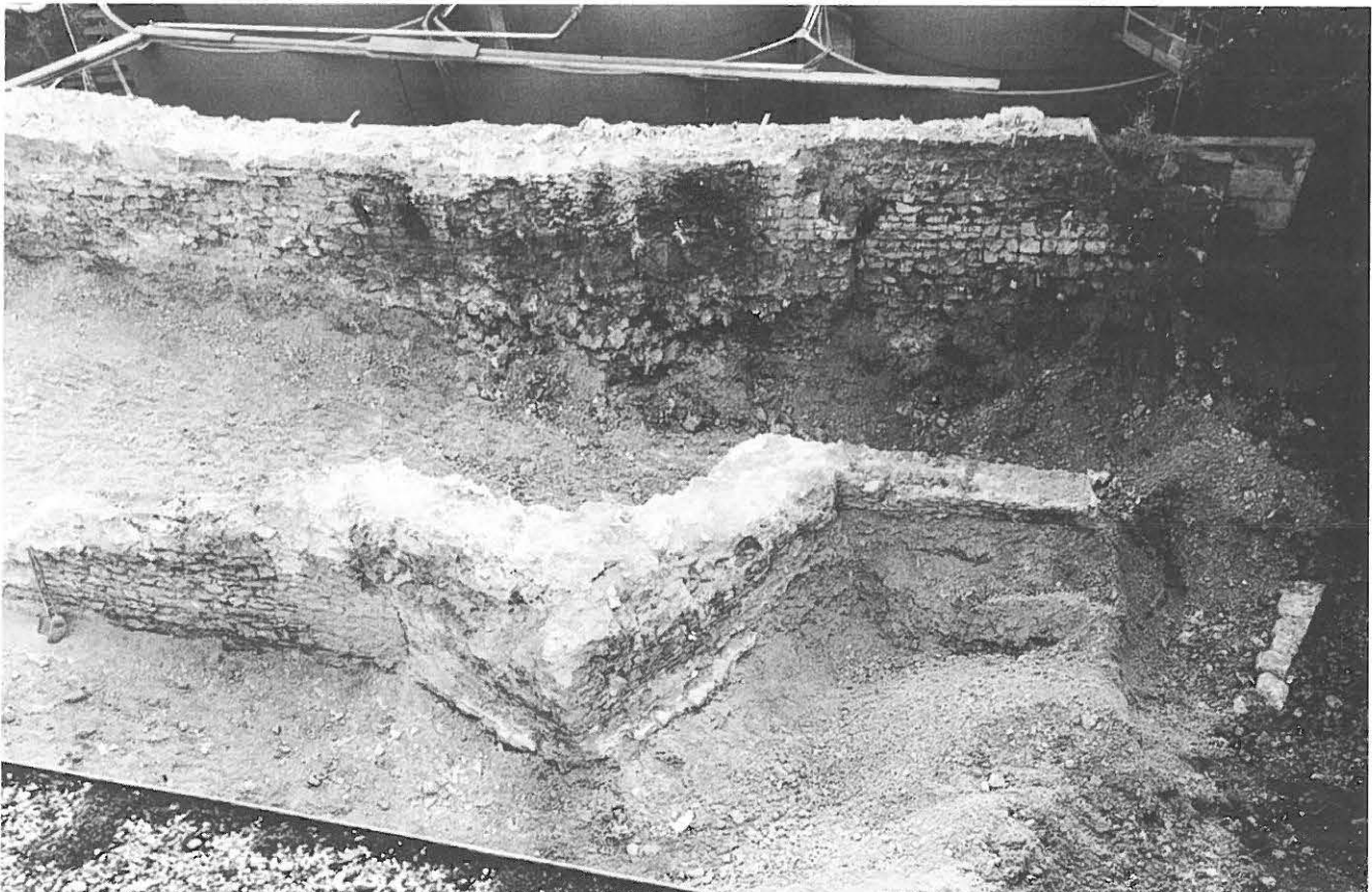
Abb. 515: Zwingen, Schloss 1990. Baugrube mit Grabenmauern nach Südwesten.
