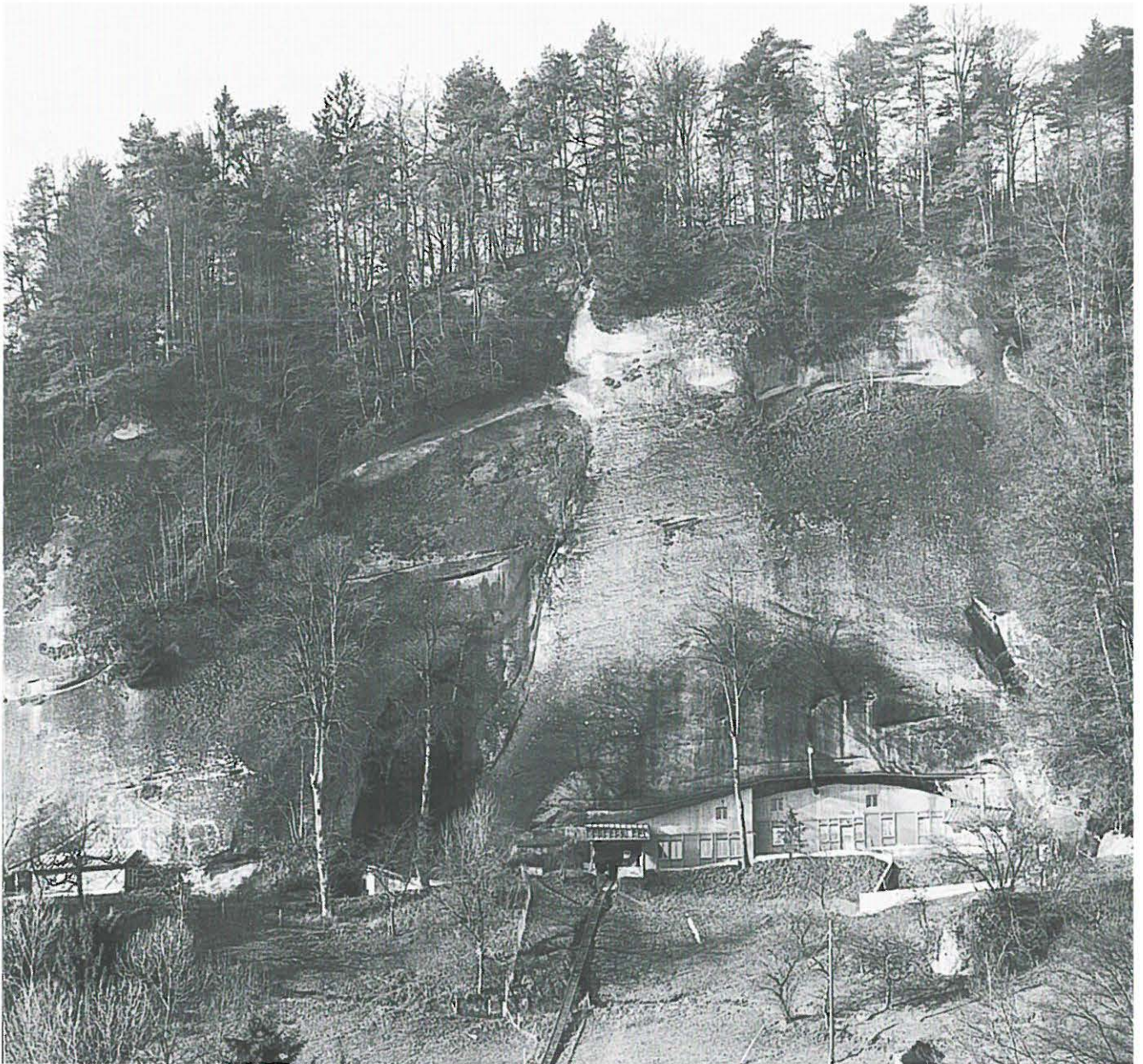
Abb. 248: Krauchthal, Äusseres Fluhhäuschen. Gesamtansicht von Osten nach der Renovation, Zustand 1993.
