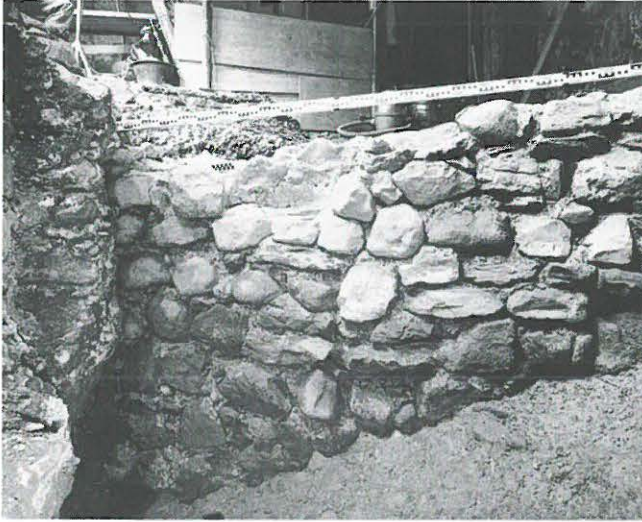
Abb. 433: Thun, Obere Hauptgasse 83. Ansicht des Stadtmauerzuges von Osten.
