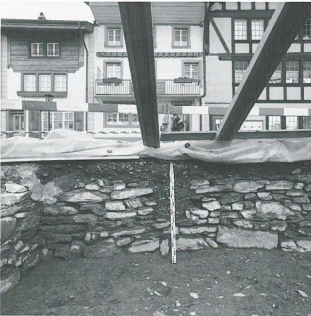
Abb. 450: Unterseen, Stadthaus 1990. Ausschnitt der freigelegten westlichen Kellermauer.
