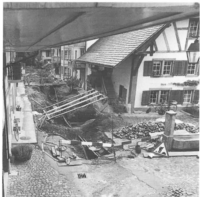
Abb. 457: Wangen an der Aare, Hinterstädtli. Übersicht der Bauarbeiten 1991 nach Norden.
