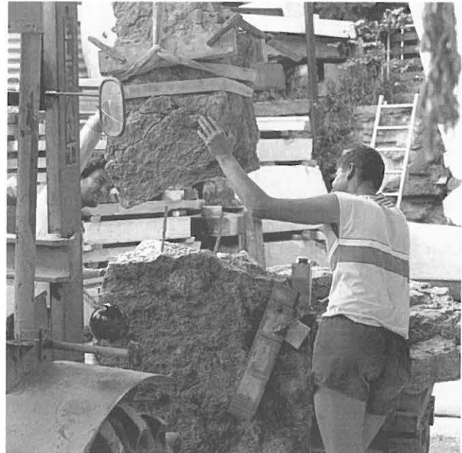
Abb. 16: Laufen - Dolmengrab. Restaurierung 1990/91. Ostplatte (10). Die zwei grossen Plattenteile werden durch zwei eingelassene Chromnickelstahl-Stäbe zusammengehalten.
