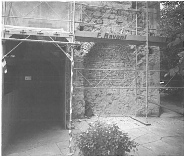
Abb. 44: Detail der Nische mit Stichbogenöffnung.
