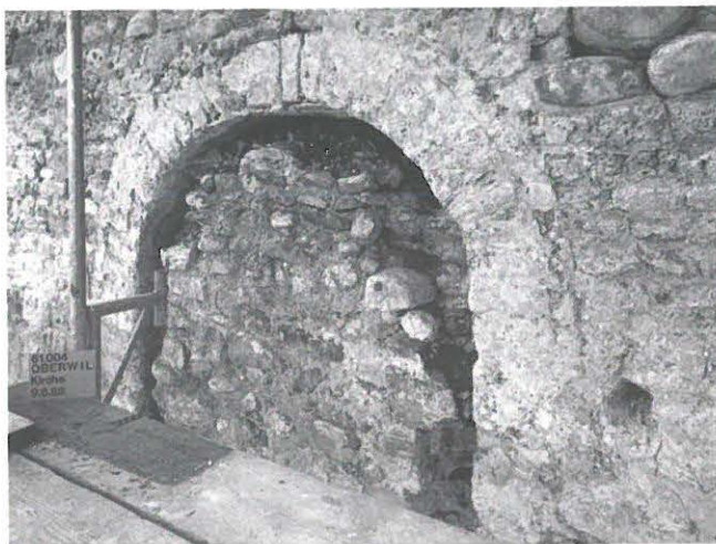
Abb. 5: Der Bogen (104) des Einganges an der Nordwestecke.
