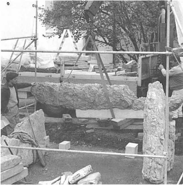
Abb. 21: Laufingen - Dolmengrab. Wiederaufstellung 1991. Die West- und die Ostplatte stehen bereits. Jetzt wird die Südplatte mit dem Kran in die richtige Lage gebracht.
