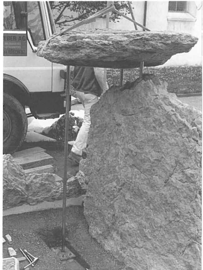
Abb. 22: Laufingen - Dolmengrab. Wiederaufstellung 1991. Die (postulierte) Deckplatte wird mittels Kran auf die vorbereiteten Chromnickelstahl-Träger aufgesetzt und fixiert.
