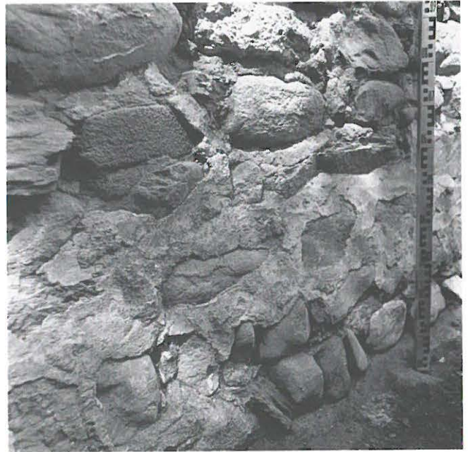
Abb. 32: Mauercharakter der Schiffsmauern (14) mit originalem Pietrasarsa-Verputz.
