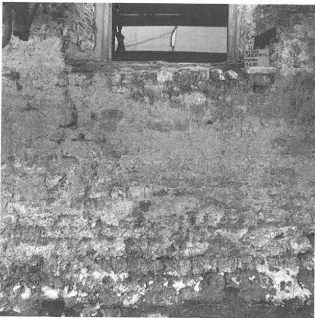
Abb. 3: Mauerwerk (100) der Anlage IV.
