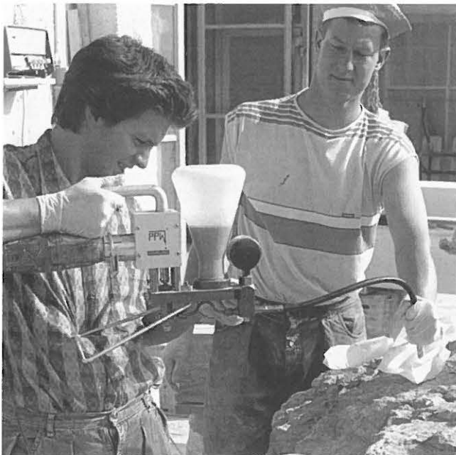
Abb. 15: Laufen - Dolmengrab. Restaurierung 1990/91. Westplatte (12). In die mächtige Kalksteinplatte wird zur Festigung mittels Pumpe Kunstharz injiziert.
