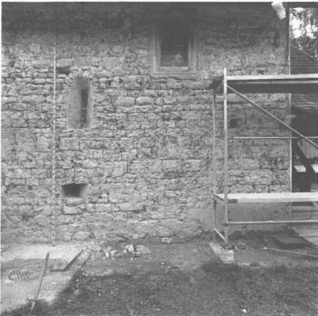
Abb. 4: Die Nordfassade des Schiffes mit romanischem Mauerwerk.
