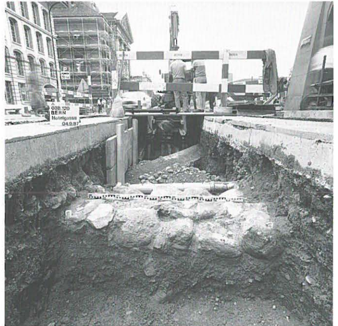
Abb. 83: Bern, Casinoplatz. Nördlicher Mauerbefund in der Hotelgasse. Blick nach Süden.
