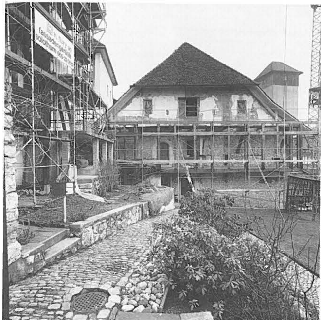
Abb. 273: Wiedlisbach, Mühle. Ansicht Westen während der Restaurierung mit Portal.
