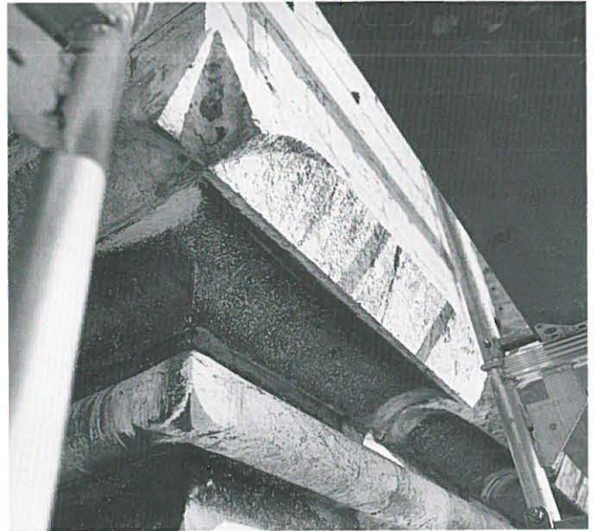
Fig. 213: La Neuveville, Tour carrée. Construction angulaire.
