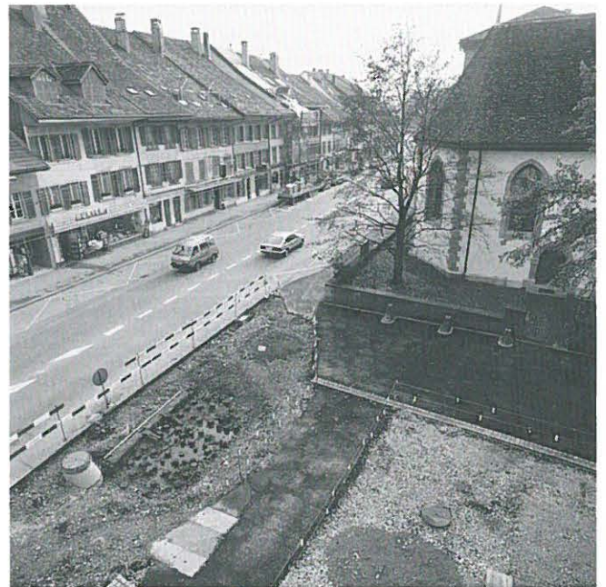
Abb. 224: Nidau, Mittelstrasse. Brunnenfundation.
