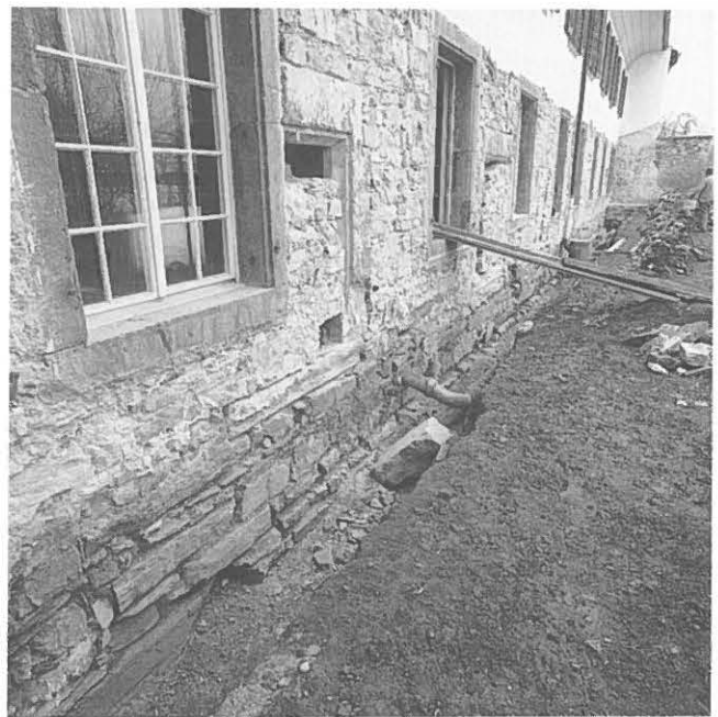
Abb. 184: Interlaken, Schloss. Fensterbefund in der Süd-fassade.
