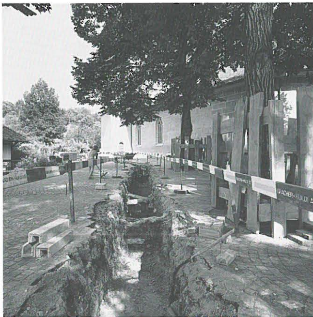
Abb. 110: Bern, Nydegg-Kirchplatz. Blick nach Osten in den offenen Leitungsraben.
