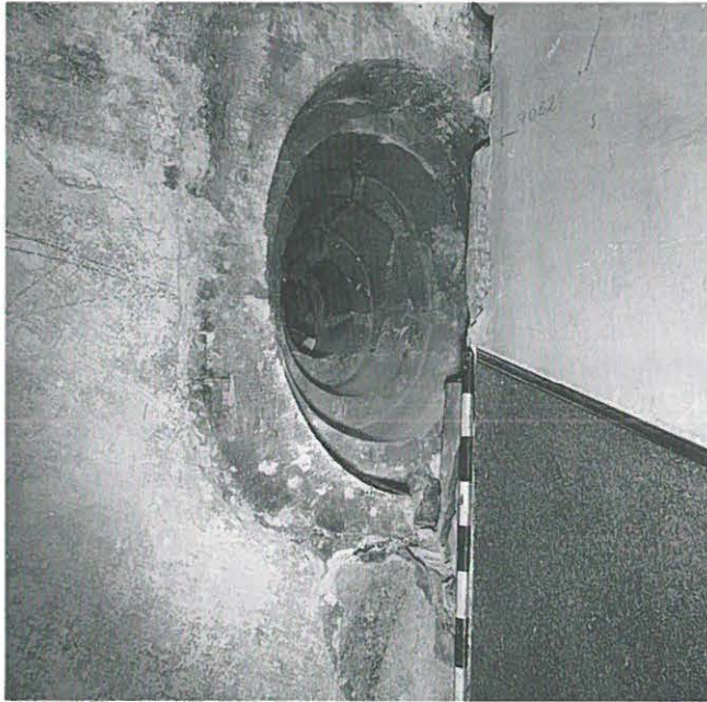
Abb. 94: Bern, Felsenburg. Befund der gestuften Okuli im obersten Turmgeschoss.
