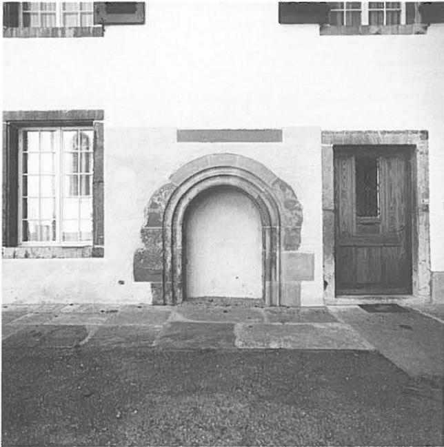
Abb. 181: Interlaken, Schloss. Das Portal nach Abschluss der Renovation.
