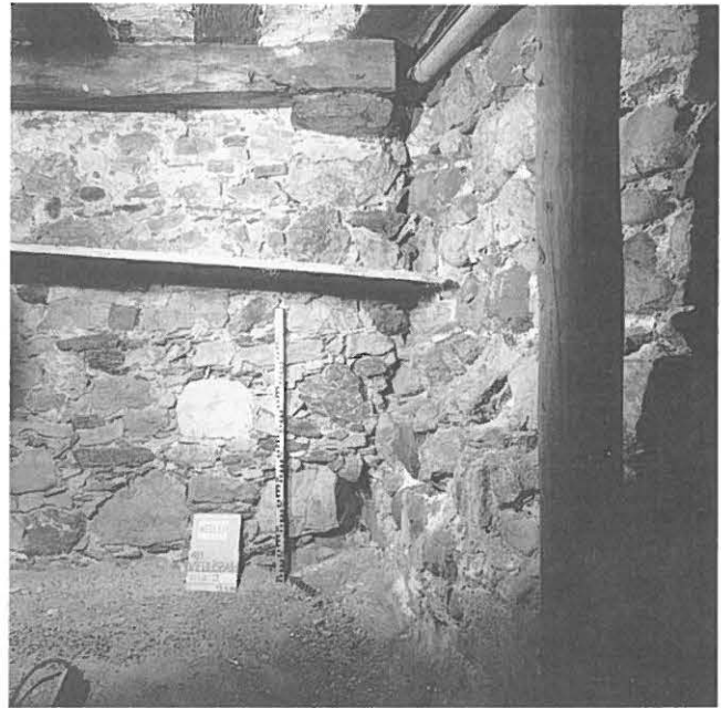
Abb. 284: Wiedlisbach, Städtli 13. Südostecke des Kellers mit Anstoss des turmartigen Kernbaus an die Stadtmauer. Sichtbar der als Konsole sekundär eingesetzte Kragstein für den Streifbalken.
