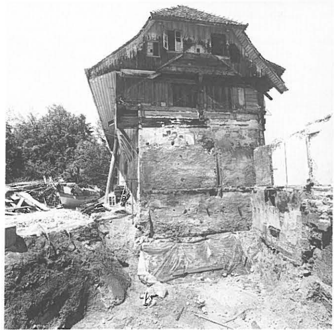
Abb. 149: Burgdorf, «Truberhaus». Ansicht von Osten während der Untersuchungen.
