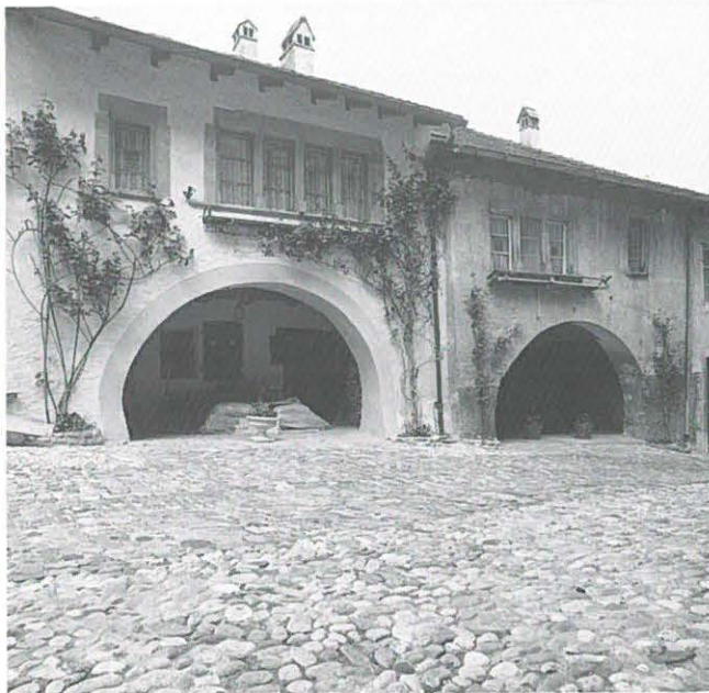
Abb. 157: Erlach, Altstadt 20 (links) und 18. Gassenfassade, Blick von Süden.
