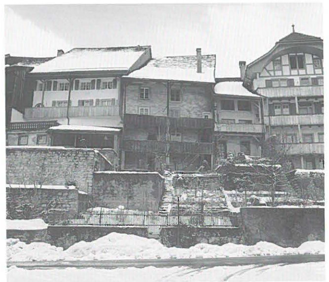
Abb. 276: Wiedlisbach, Städtli 13. Südansicht. V.l.n.r.: Nr. 15, 11 und 9.
