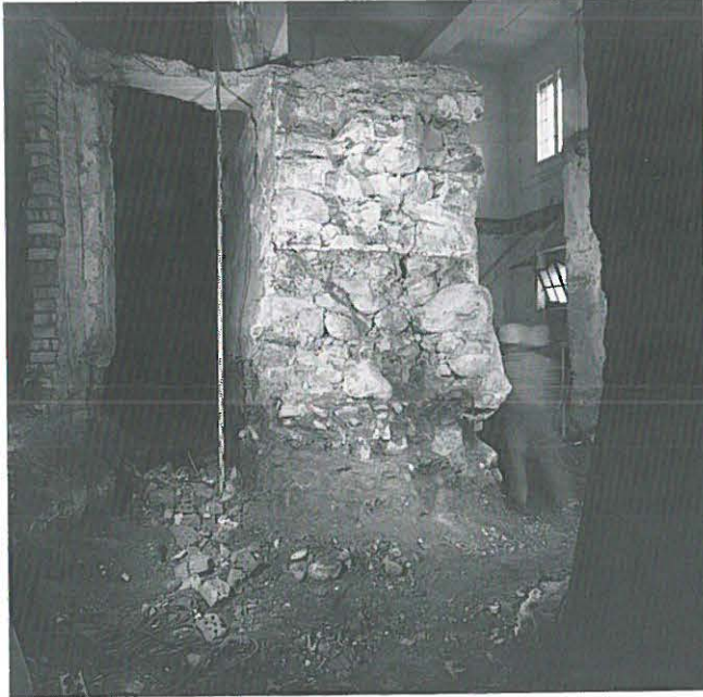
Abb. 237: Thun, Freienhofgasse 21. Die durchbrochene Stadtmauer von Westen, Freilegungszustand. Deutlich sichtbar sind die horizontalen Etappengrenzen.
