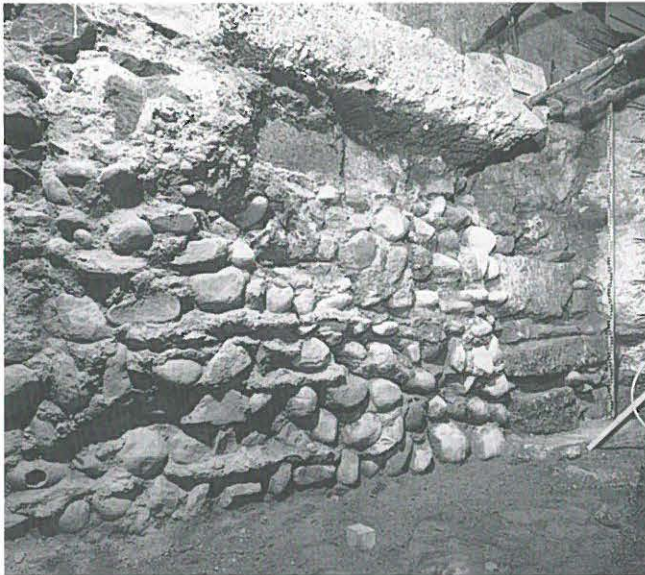
Abb. 115: Bern, Zytgloggelaube 4/6. Ansicht der Rückseite der Grabenstützmauer des sog. Zweiten Westgürtels. Im Vordergrund die jüngere, hinten die ältere Phase.
