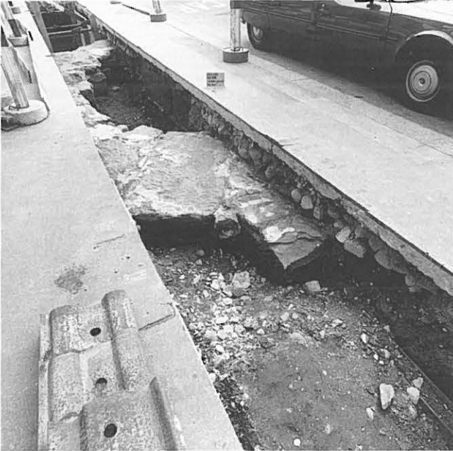
Abb. 86: Bern, Casinoplatz. Mauerbefunde der Bibliotheksgalerie Niklaus Sprünglins. Im Graben die östliche Seite von Hauptfassade und Treppenhaus-Queroval.
