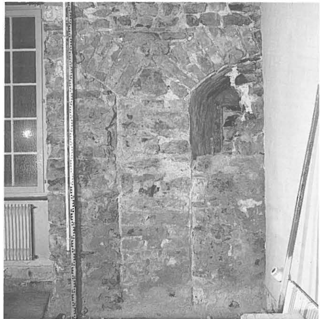
Abb. 183: Interlaken, Schloss. Fenster-nischenbefund in der Süd-wand des ehem. Refektoriums.
