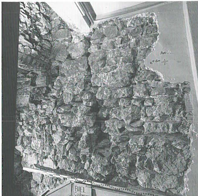
Abb. 124: Biel, Collègasse 1. Stadtmauerdetail.
