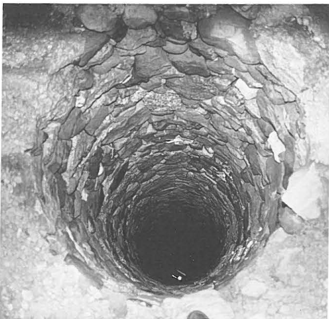
Abb. 77: Bern, Brunnadernrain 10. Einblick in den Sodbrunnen.
