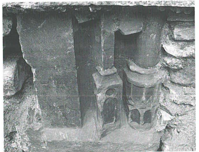
Abb. 180: Interlaken, Schloss. Sockelpartie des gotischen Portals.
