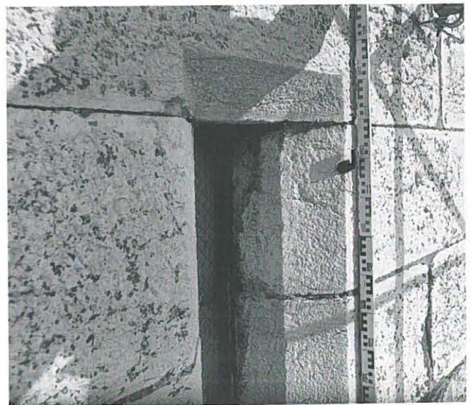
Fig. 214: La Neuveville, Tour carrée. Fenêtre rectangulaire à chanfrein avec détail de la pierre taillée.
