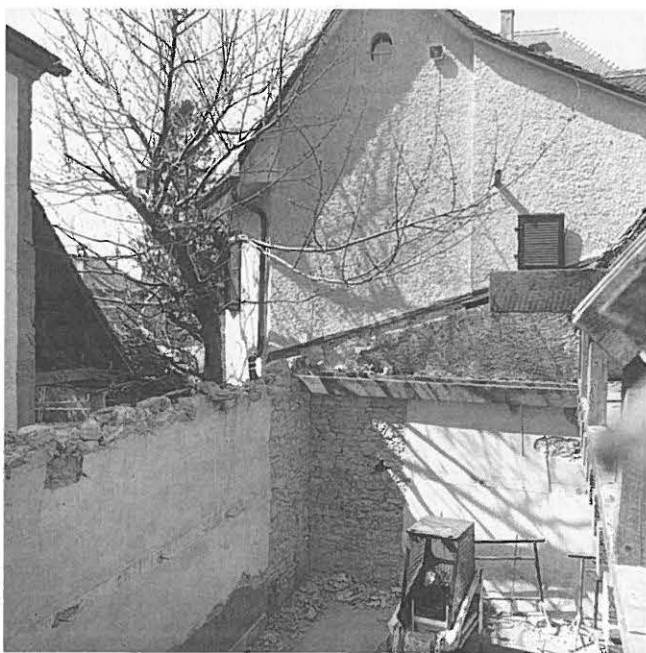
Abb. 226: Nidau, Mittelstrasse 3. Ostfassade der ehem. Kapelle nach Abbruch des Spritzenhauses.
