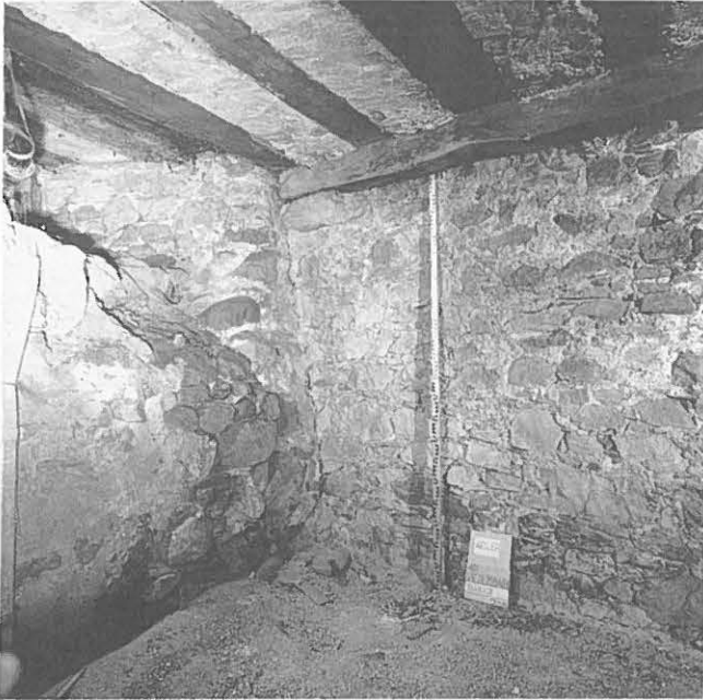
Abb. 282: Wiedlisbach, Städtli 13. Ansicht im Keller nach Südwesten mit Mueranostoss an die Stadtmauer. Deutlich sichtbar ist die erst um 1500 eingebaute Kellerdecke.
