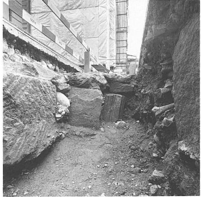
Abb. 87: Bern, Casinoplatz. Fundamente des Treppenhausovals der Bibliotheksgalerie nach Süden. Im Hintergrund ein verworfenes Werkstück, rechts Knochendeponie.
