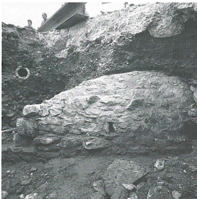
Abb. 91: Bern, Casinoplatz. Blick von Nordosten gegen die Rückwand der letzten Nische des Lehnenviaduktes vor dem Brückenkopf.
