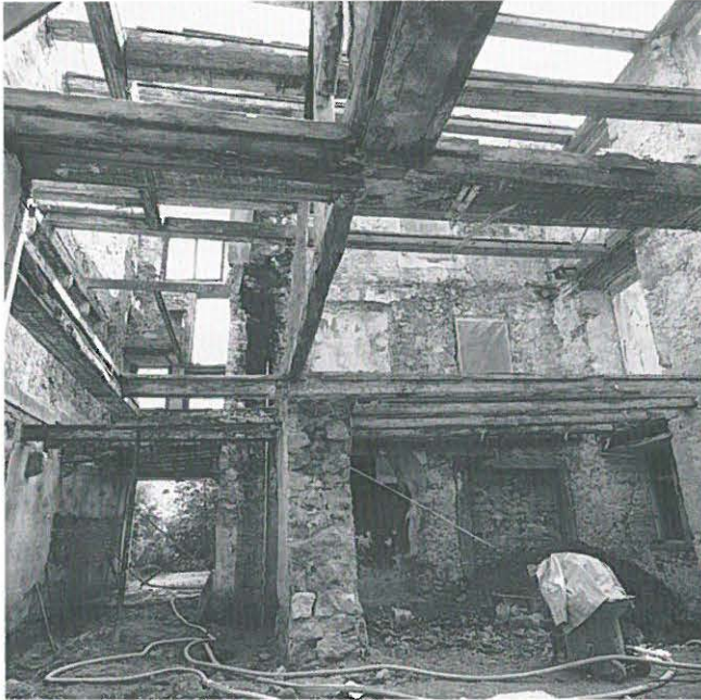
Abb. 222: Nidau, Hauptstrasse 73. Kernbau nach Osten. Aufschluss 1987.
