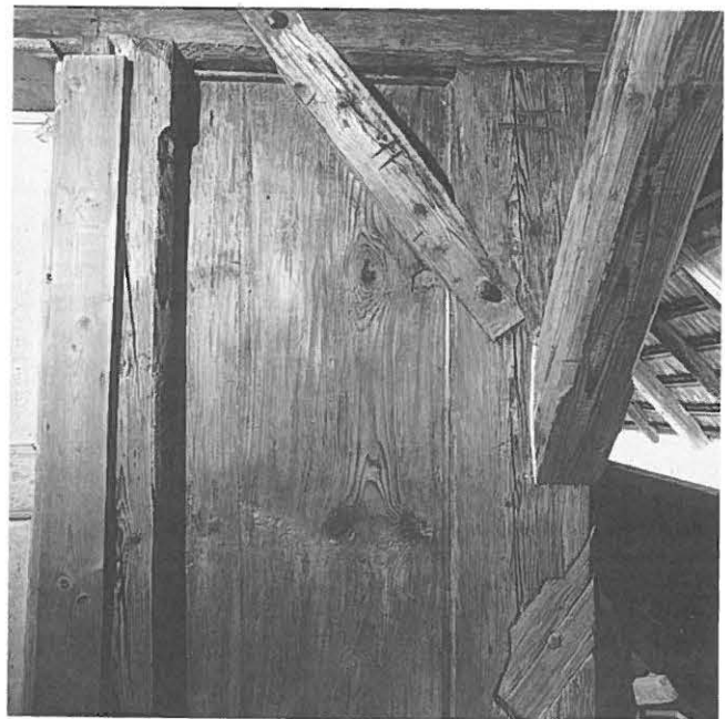
Abb. 260: Urtenen, Längenlooweg 30/32. Detailausbildung an der Südostecke auf Laubenhöhe.
