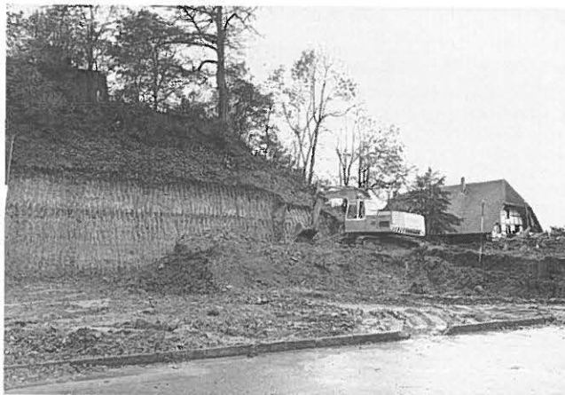
Abb. 205: Lyss, Kirchhübeliweg. Negativbefund an der Grubenwand gegen den Hügel.
