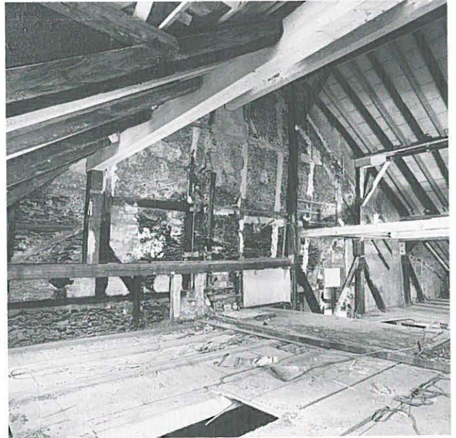
Abb. 242: Thun, Obere Hauptgasse 29. Blick nach Süden im Dachgeschoss.
