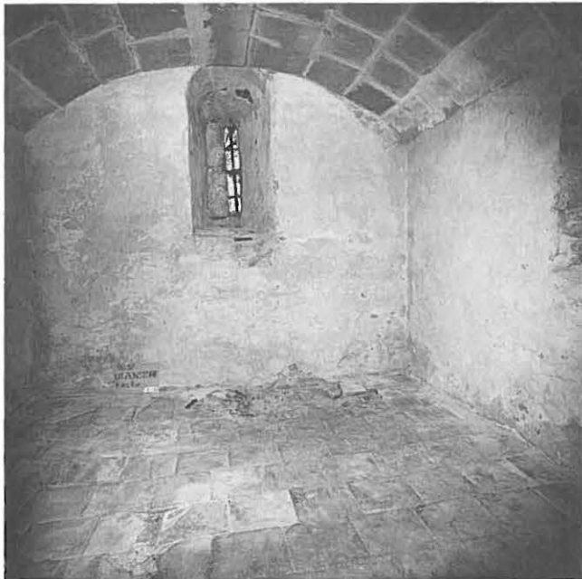
Abb. 16: Das Innere des Turmerdgeschosses nach Norden.
