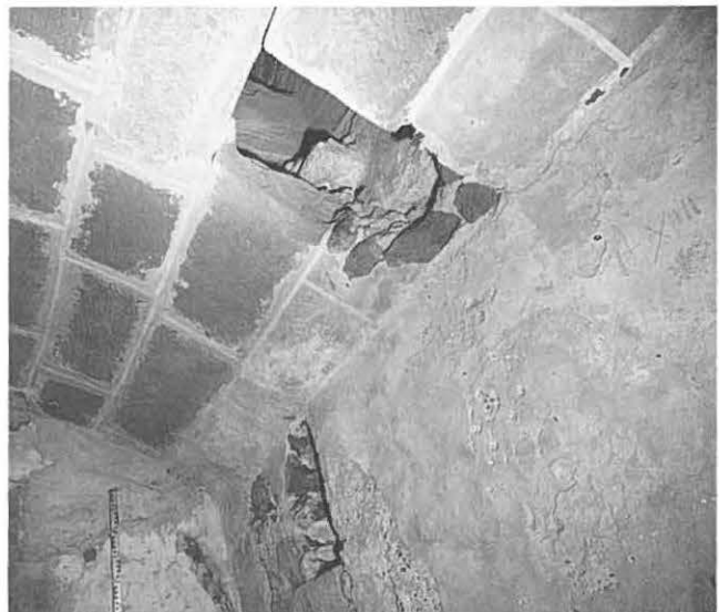
Abb. 19: Sondage im Sakristeigewölbe. Ein Fragment des originalen Deckengesimses ist sichtbar.
