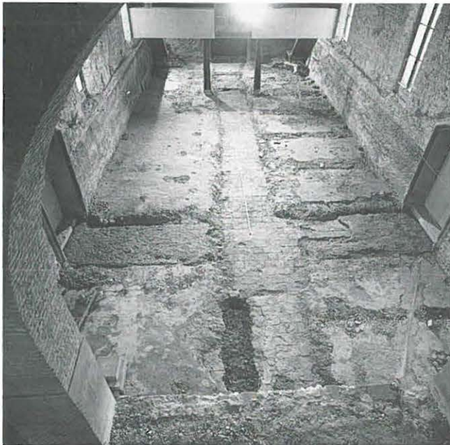
Abb. 12: Übersicht nach Westen auf die Befunde der Mörtelgussböden.
