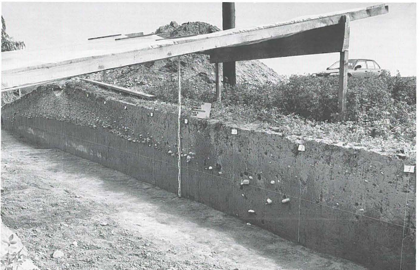
Abb. 3: Barga-Chäseren 1990. Übersicht Profil 16. Links erkennen wir den linsenförmigen Strassenkörper. Die tieferliegenden Steine im rechten Bildteil zeigen den westlichen Strassengraben. Blickrichtung Südost.
