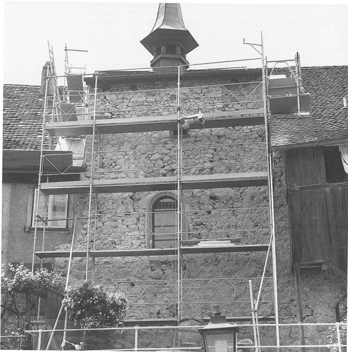
Abb. 2: Die Ostfassade im Zustand der archäologischen Untersuchung.
