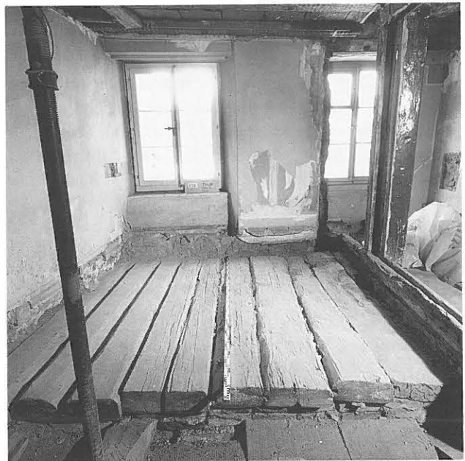
Abb. 5: Balkendeckenkonstruktion von 1409 über der Laube Bälliz 75.
