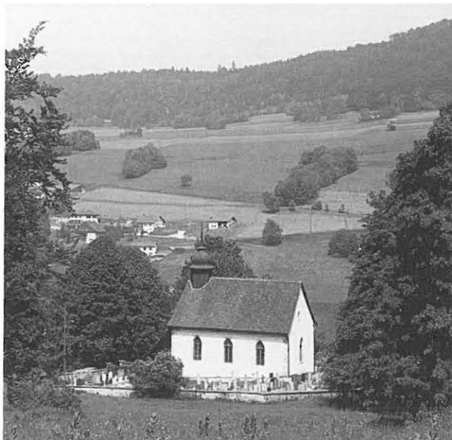
Fig. 1: L'église vue du sud-est.
