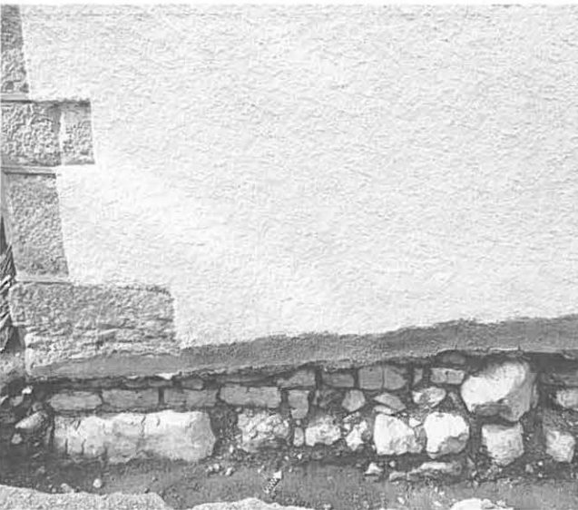
Fig. 9: Fondation du mur sud. Agrandissement (5) pour l'église romane.
