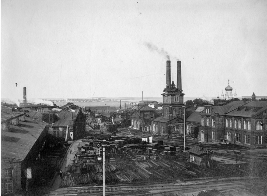
Abb. 11 o. A.: Blick auf das Elektrizitätswerk (Vid na električeskuju stanciju), in: o. A.: Kolomnaer Maschinenfabrik (Kolomenskij mašinostroitel'nyj zavod), o. O. 1916, S. 1. RNB OÈ È((ALTch100)/(2-2))
