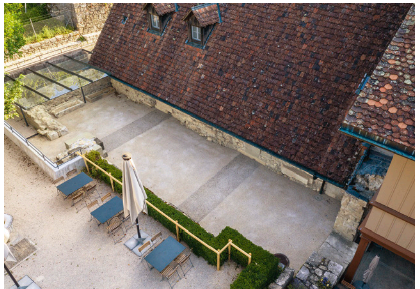
Abb. 3: Twann-Tüscherz, St. Petersinsel. Neuer Bodenbelag mit Markierung der Vierung. Über den Mauerresten des nördlichen Querschiffs erhebt sich ein Schutzdach aus Metallträgern und Plexiglas. Blick nach Nordosten.
