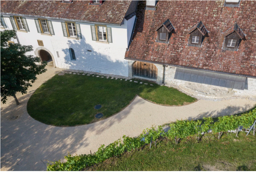
Abb. 4: Twann-Tüscherz, St. Petersinsel. Die Fläche der Haupt- und der nördlichen Seitenapsis der älteren Basilika I wurde mit Rasen begrünt und mit Metallbändern umfasst. Blick nach Südwesten.
