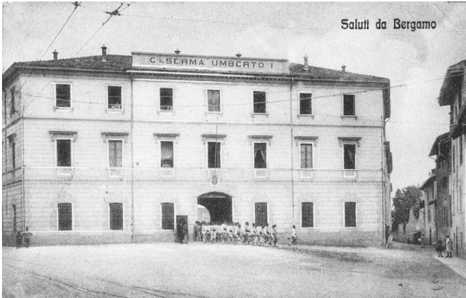
Abb. 1: Die im frühen 19. Jahrhundert erbaute Umberto-I.-Kaserne in Bergamo wurde 1943/44 von deutschen Besatzungstruppen genutzt. Über 800 Personen wurden hier inhaftiert. Außerdem diente das Gebäude als Transitlager für zwei Transporte in deutsche Konzentrationslager, die Bergamo am 17. März und am 5. April 1944 verließen (Postkarte, vor 1925, © Museo delle storie di Bergamo, CAR-1201).
