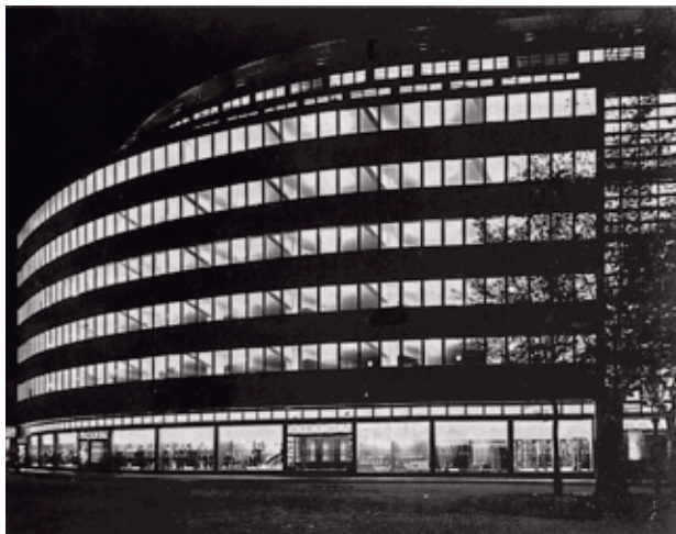
Nachtaufnahme des Kaufhauses Schocken in Chemnitz von Erich Mendelsohn (1927-30) mit deutlich sichtbaren Unterzügen. Bild: Stephan 1998, S.129.
