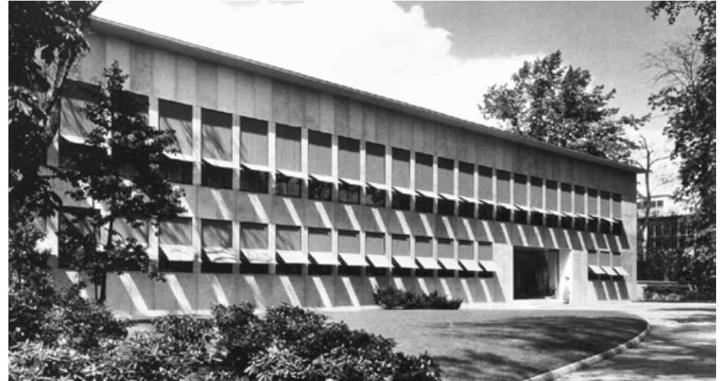
Verwaltungsgebäude Bau 21 von O.R. Salvisberg, Direktionsflügel an der Rheinpromenade 1936. Foto: Robert Spreng. Bild: Bieri 2001, S.39.
