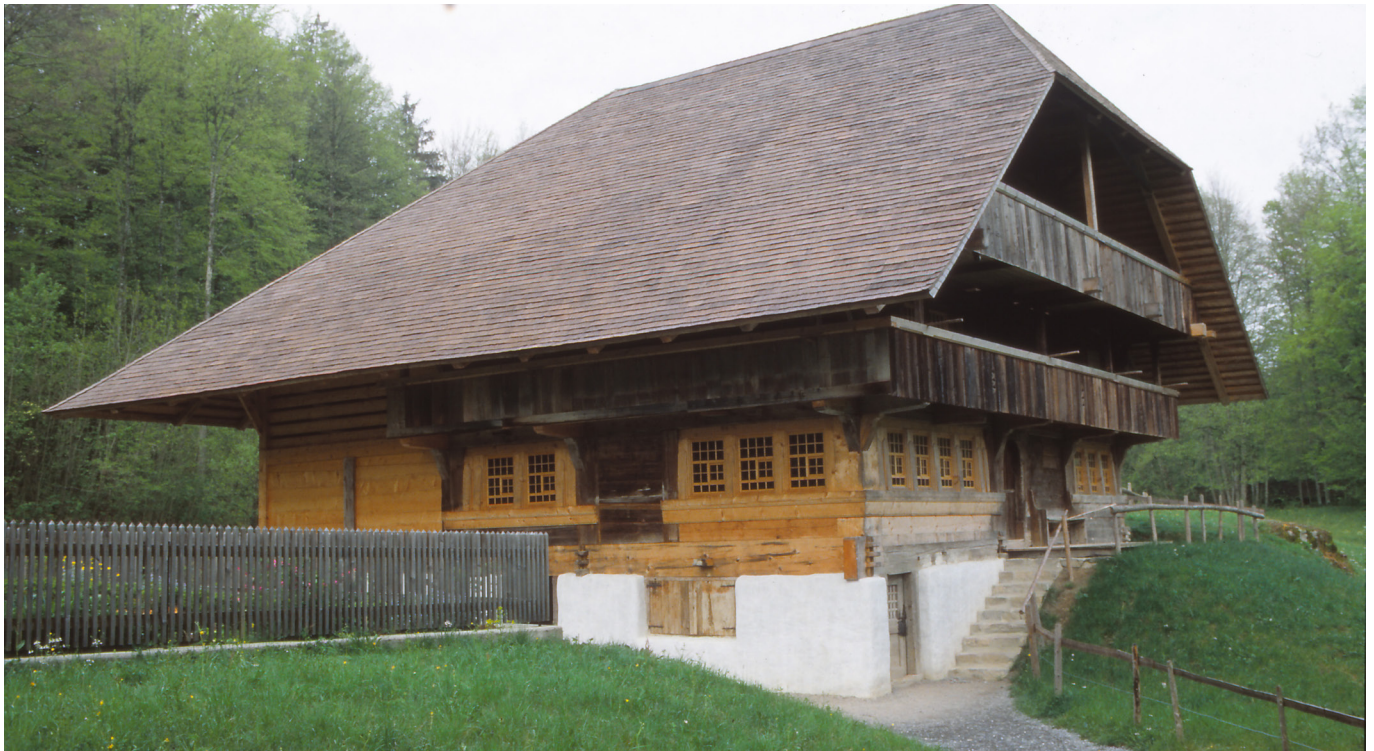
25 Im Museumsbau wurden die Fenstergrößen und der Ökonomieteil auf den Erbauungszustand rückgebaut. Der Holzaustausch war anhand der helleren Färbung der neuen Balken gut ablesbar. Foto, 1993 (FLM digKat).
