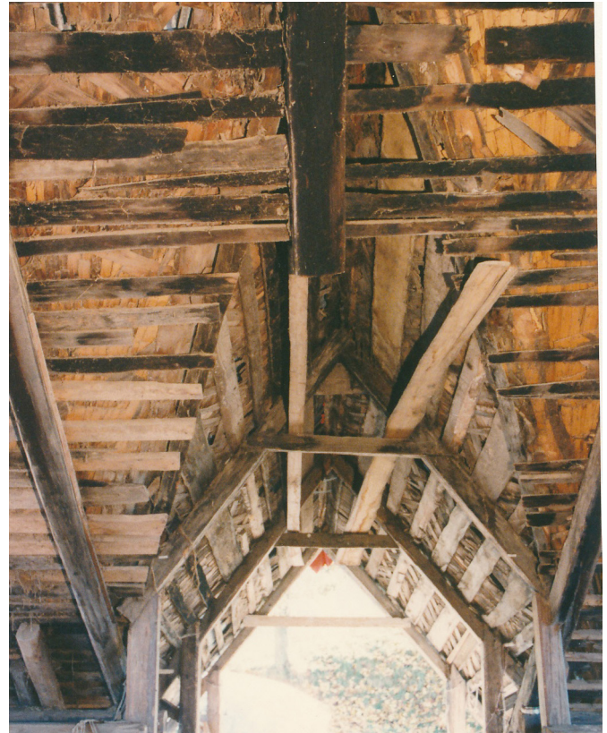
14 Für die Dachkonstruktion der Hocheinfahrt wurde ein Sparren des Daches des Kernbaus abgesägt (Denkmalpflege des Kantons Bern, Archiv, Fotograf Ernst E. Anderegg, Meiringen, 1988-92).
