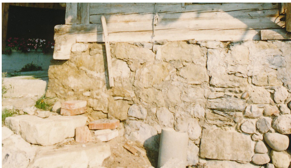
18 Die Erweiterung des Ökonometeils nach Norden war durch eine Baufuge im Sockel gut ablesbar. Foto, 1988 (FLM Fotodokumentation Denkmalpflege Bern).
