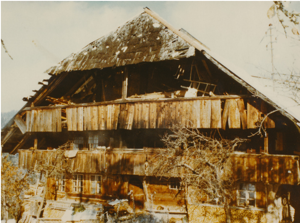
10 Die Schauffassade des Bauernhauses aus Eggwil war nach Süden ausgerichtet (Denkmalpflege des Kantons Bern, Archiv, Fotograf Ernst E. Anderegg, Meiringen, 1988-92). → 11 Die Westfassade zeigte am ehemaligen Standort mehrere grosse Fensteröffnungen (Denkmalpflege des Kantons Bern, Archiv, Fotograf Ernst E. Anderegg, Meiringen, 1988-92).
