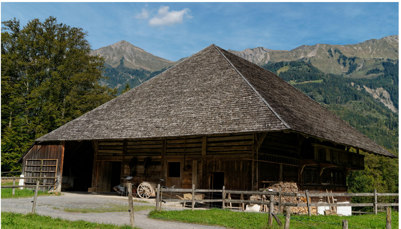
26 Die Erweiterung des Ökonomieteils aus dem 19. Jahrhundert wurde nicht in das FLM übernommen. Auf der ehemaligen Nordseite wurde ein Vollwalmdach rekonstruiert. Foto, 2014 [FLM digKat].
