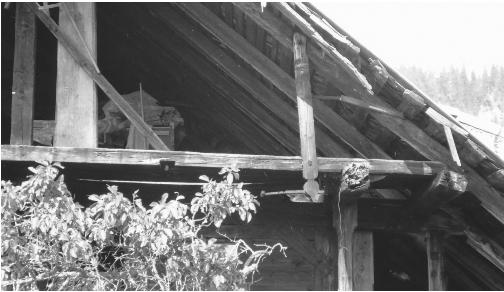
15 Blick in den Dachraum an der Südöstlichen Giebelseite (Denkmalpflege des Kantons Bern, Archiv, Fotograf Ernst E. Anderegg, Meiringen, 1988-92).
