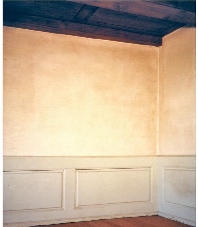
14 Farbuntersuchungen zeigten, dass sich das Täfer der Obergeschoss-Stube zuvor in der Hauptgeschoss-Stube befunden hatte. Foto, 1984 (FLM 12411).
