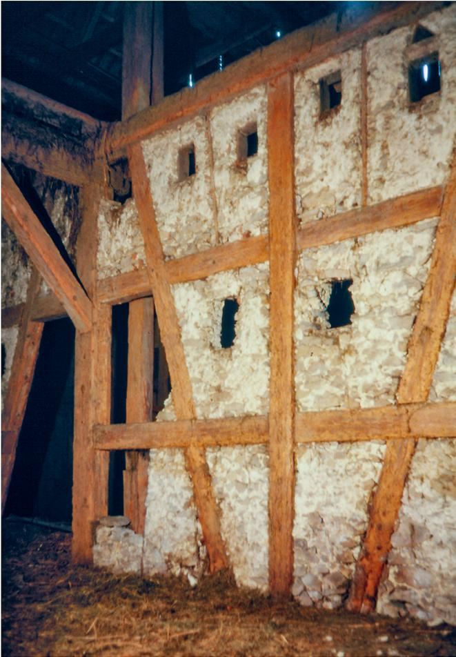
8 Die Ostwand des Kernbaus bestand aus Fachwerk mit Bruchsteinausfachung und verschieden geformten Lüftungslöchern. Foto, 1984 (FLM 12418).
