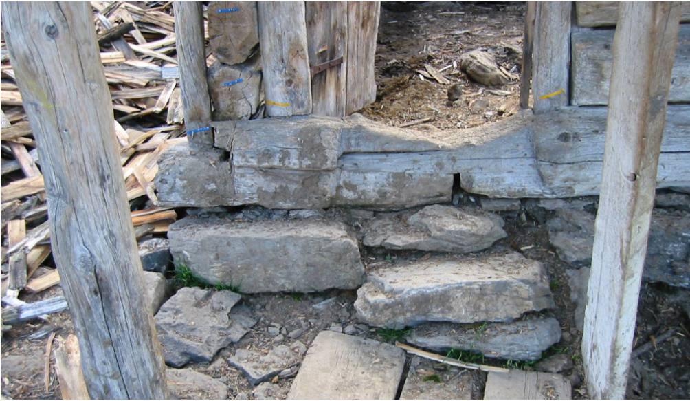
11 Die Türschwelle des Eingangs in die Melkhütte war durch die jahrhundertelange Benutzung abgetreten. Foto, 2001 (FLM digKat).
