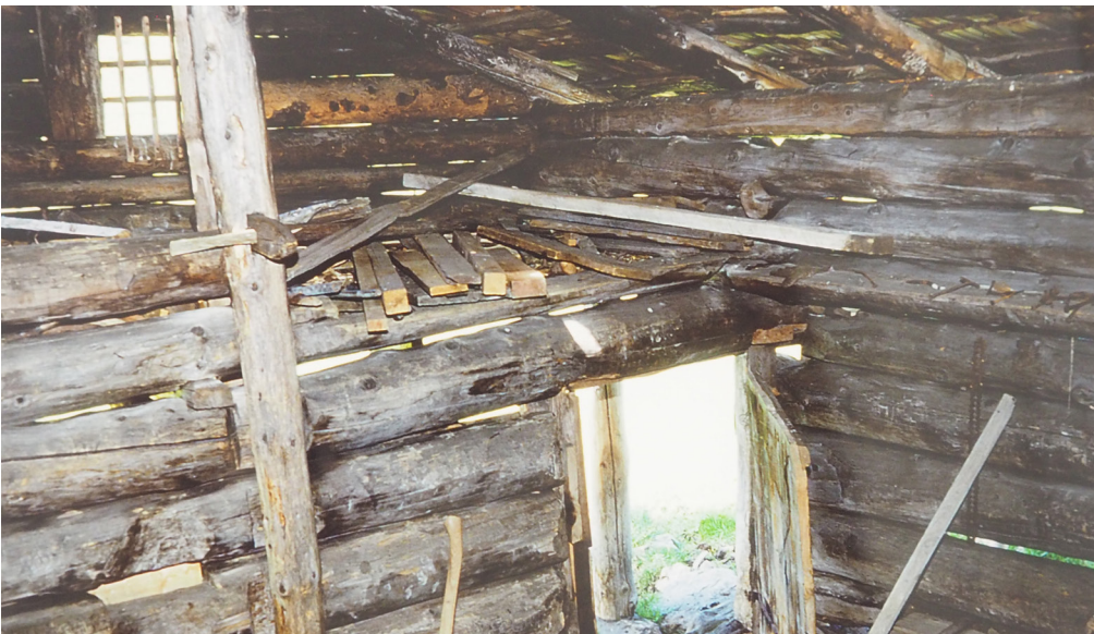
12 Im Innenraum zeigten die Balken und Rafen eine deutliche Schwärzung durch Russpartikel der offenen Feuerstelle. Foto, 2000 (FLM digKat).
