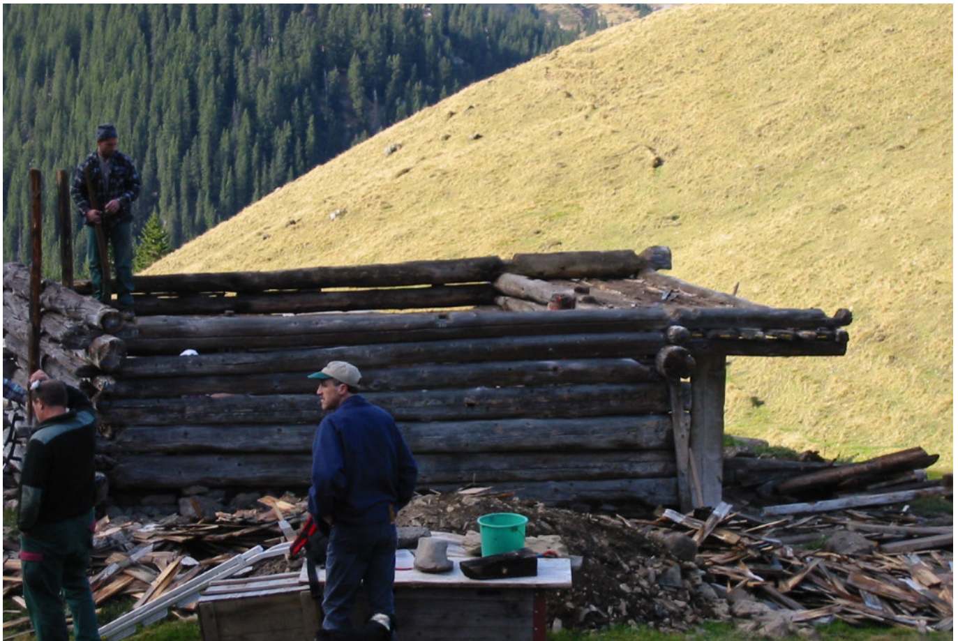
19 Beim Abbau des Blockbaus konnten die historische Konstruktion und der Aufbau nachvollzogen werden. Foto, 2001 (FLM digKat).
