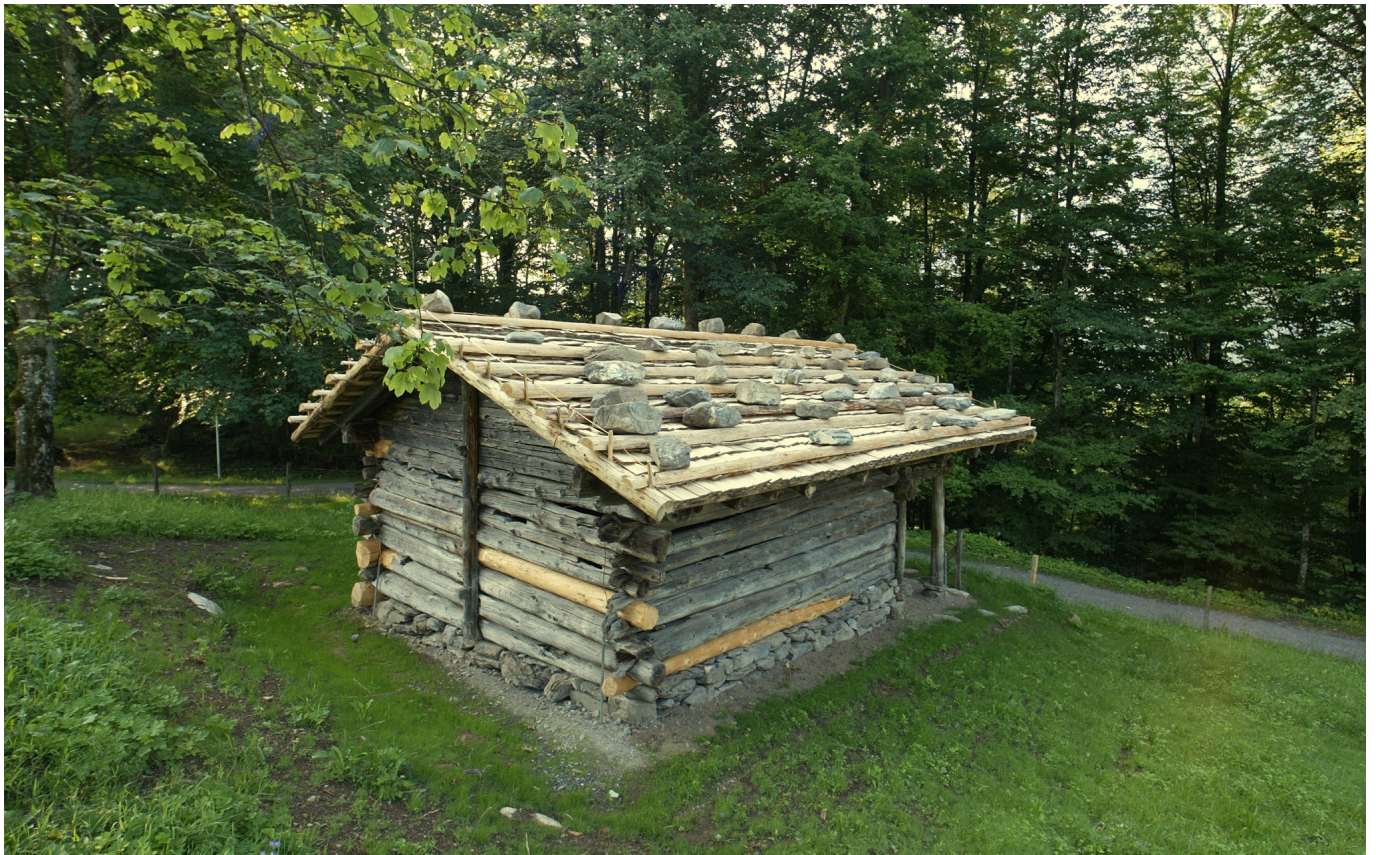
21 Auf der kurz nach dem Aufbau im Museum gemachten Foto sind die ersetzten Holzbauteile durch die helle Färbung gut zu erkennen. Foto, 2002 (FLM digKat).
