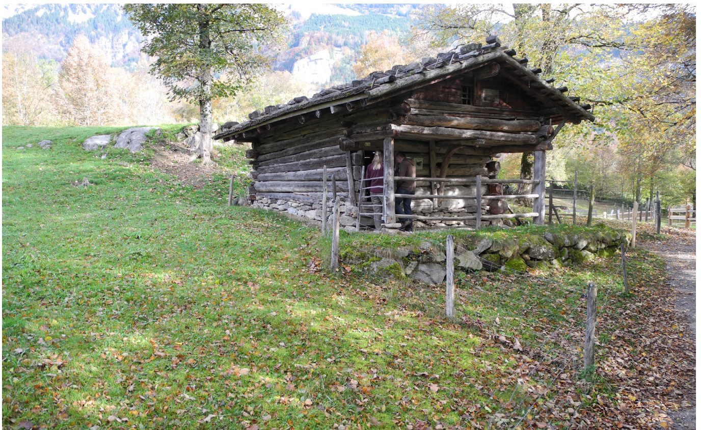
22 Zwischen den Stützen des Vorkrags wurde später eine Lattung rekonstruiert, die für das Melken der Kühe sinnvoll war. Foto, 2013 (FLM digKat).
