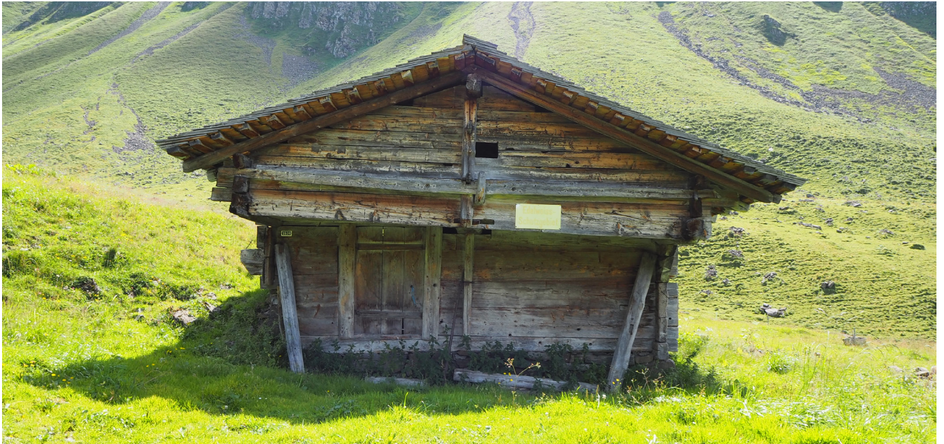
8 Das wenige Jahre ältere Nachbargebäude der Melkhütte war dem Museumsbau sehr ähnlich. Foto, 2020 (FLM digKat).
