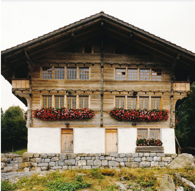
13 Die Hauptfassade des Wohnhauses aus Brienz BE kurz nach dem Aufbau im Freilichtmuseum im Jahr 1975 [FLM digKat].
