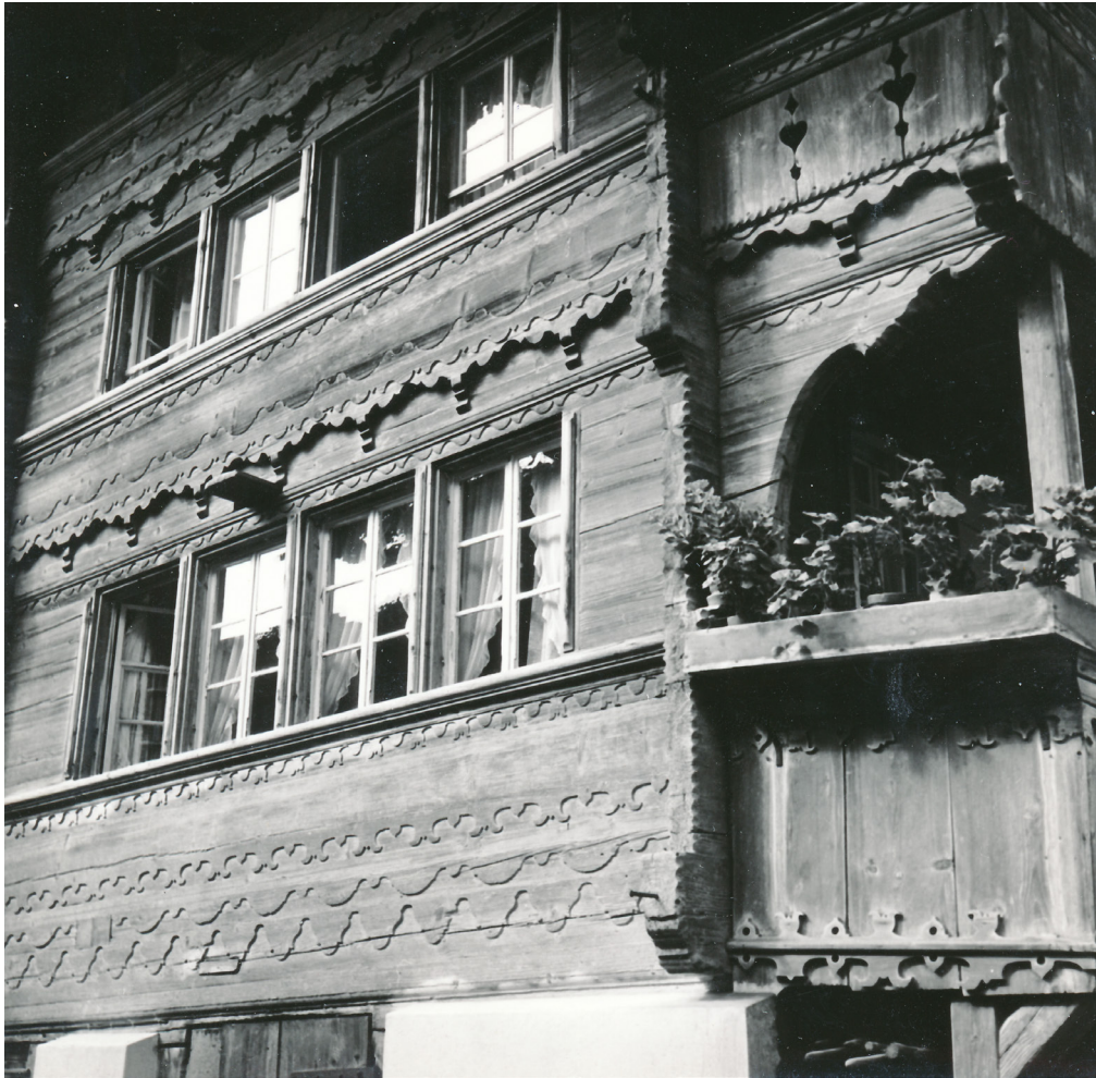
9 Nordostecke des Wohnhauses aus Brienz am ehemaligen Standort: Die reiche Verzierung der Ostfassade setzt sich in der Gestaltung der Balkenvorstösse und der Konsolen fort. Die später hinzugefügte Laube im Hauptgeschoss unterscheidet sich durch Zierbretter anstelle von Flachschnitzereien. Foto 1969 (FLM digKat).
