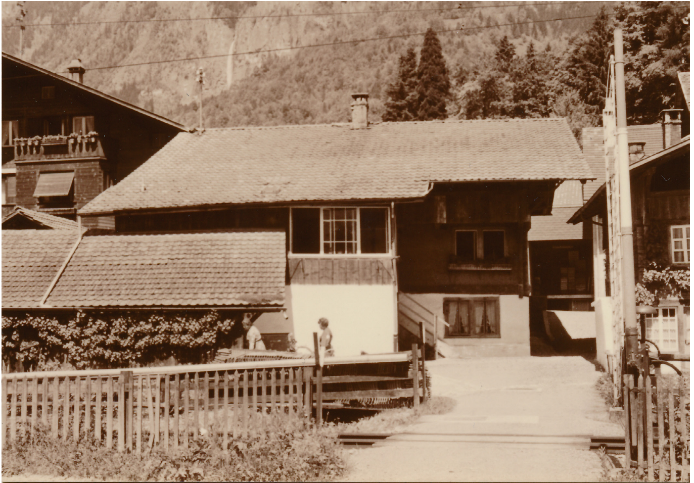
6 Südlich des Wohnhauses führte ab 1916 die Bahnstrecke nach Interlaken entlang. Seeseitig war an das Haus ein Anbau vorgesetzt. Zwischen Bahnlinie und Haus stand ein Schopf. Foto, um 1969 (FLM AltA 3154).
