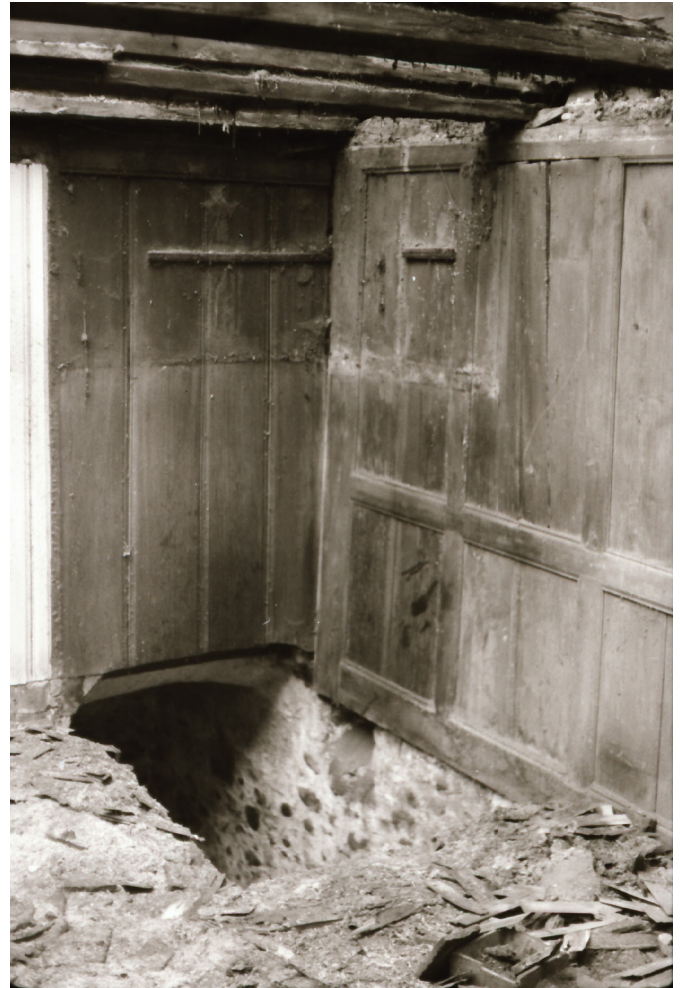
15 Der Gewölbekeller unter dem Wohnteil war über die Wirtsstube erschlossen. Der Treppenaufgang war vermutlich ehemals eingehaust. Foto, 1974 (FLM, BalFot 19650).
