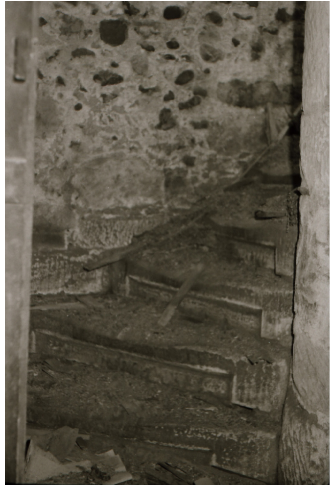
26 Die Kellertreppe unter dem Wohnteil war aus Werksteinen gearbeitet und wendelte sich in Richtung des Kellereingangs. Foto, 1974 (FLM, BalFot 19648).
