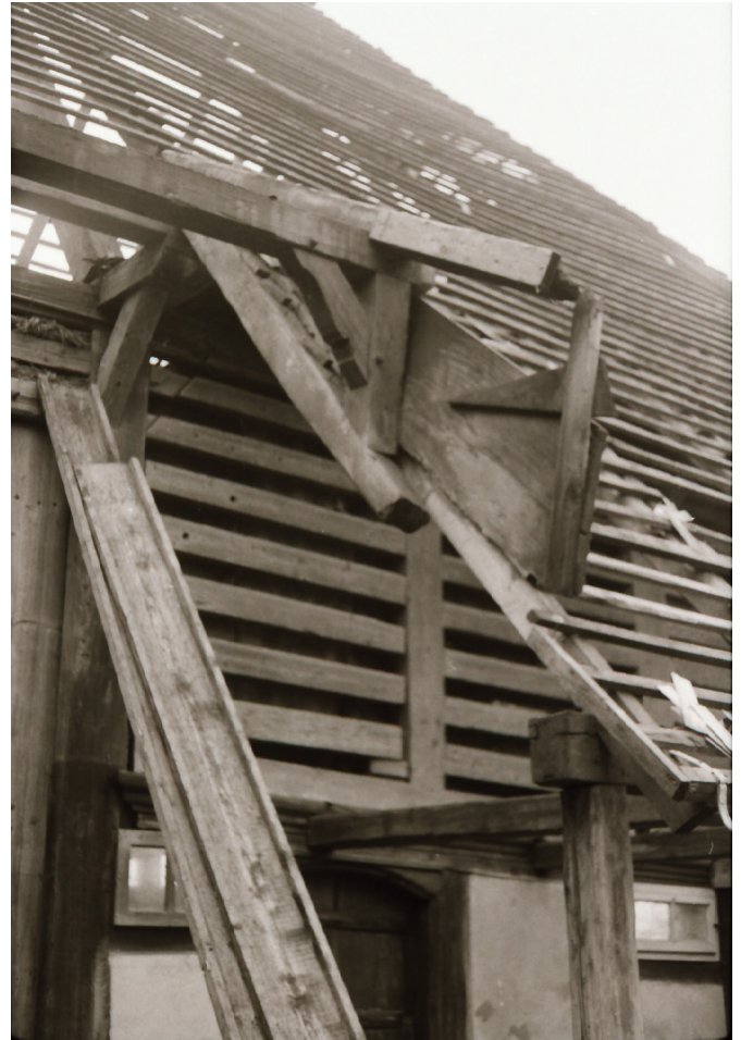
28 Das abgedeckte Dach zeigte die Konstruktion des Vordachs von dem Tenn über dem Vorbaus des Stalls. Foto, 1974 (FLM, BalFot 19678).
