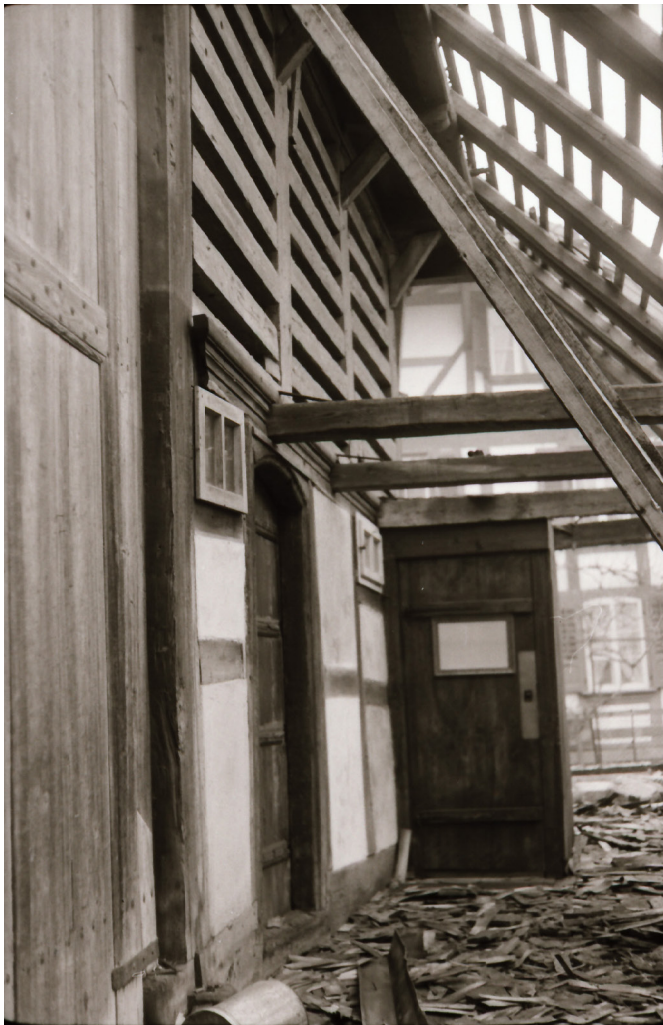
9 Auch die Ostfassade des Stalls war mit einem Zierfries verkleidet und der Stall- eingang mit einem Segementbogen versehen. Foto, 1974 (FLM, BalFot 19607).
