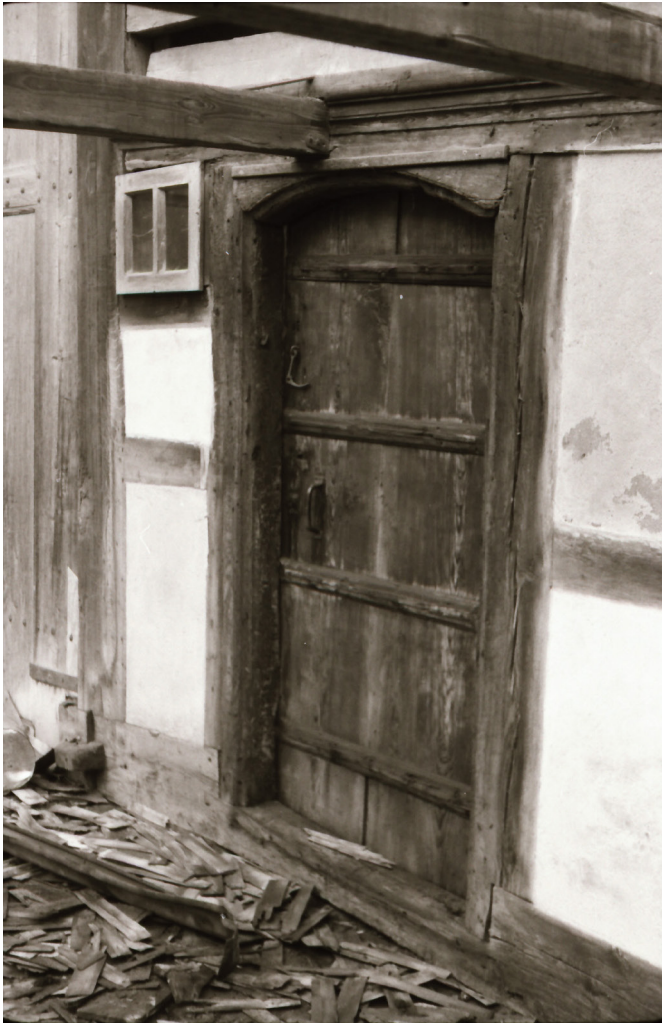
11 Das Türblatt der Stallzugangs bestand aus einer Bretterkonstruktion mit Querleisten. Das Türgewände wies eine Abfasung auf. Foto, 1974 (FLM, BalFot 19608).
