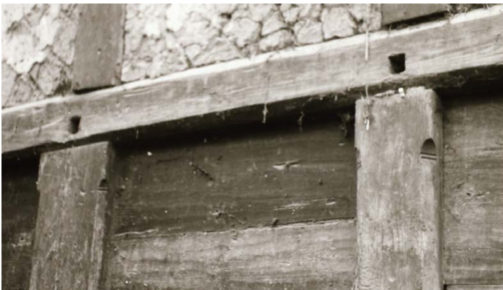
24 Die Trennwand zwischen Wohnteil und Tenn war im Hauptgeschoss eine Bohlen-Ständer-Konstruktion mit Abfasungen an den Ständern und im Obergeschoss Fachwerk mit diagonalen Ritzungen in den Lehmwickel-Gefachen. Foto, 1974 (FLM, BalFot 19636).
