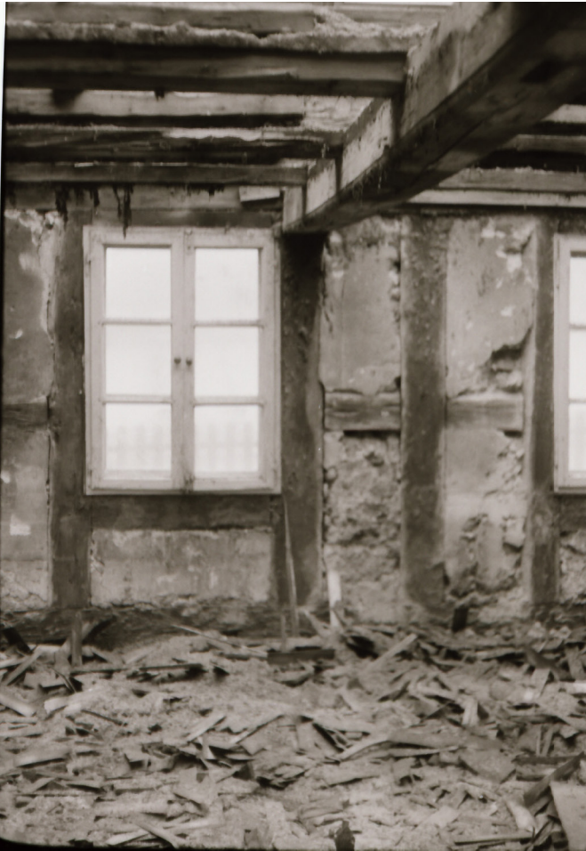
27 Beim Abbruch wurden baukonstruktive Details sichtbar, wie die Deckenkonstruktion oder die Füllung der Gefache. Foto, 1974 (FLM, BalFot 19649).
