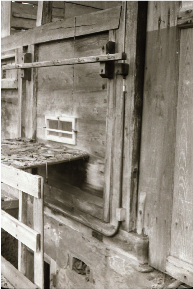
25. An Westfassade des Stalls führte ein Treppenabgang in einen tonnengewölbten Keller. Foto, 1974 (FLM, BalFot 19616).
