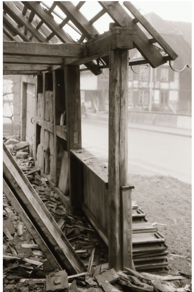
10 Der Vorbau vor dem Stall war eine einfache Ständerkonstruktion. Foto, 1974 (FLM, BalFot 19606).
