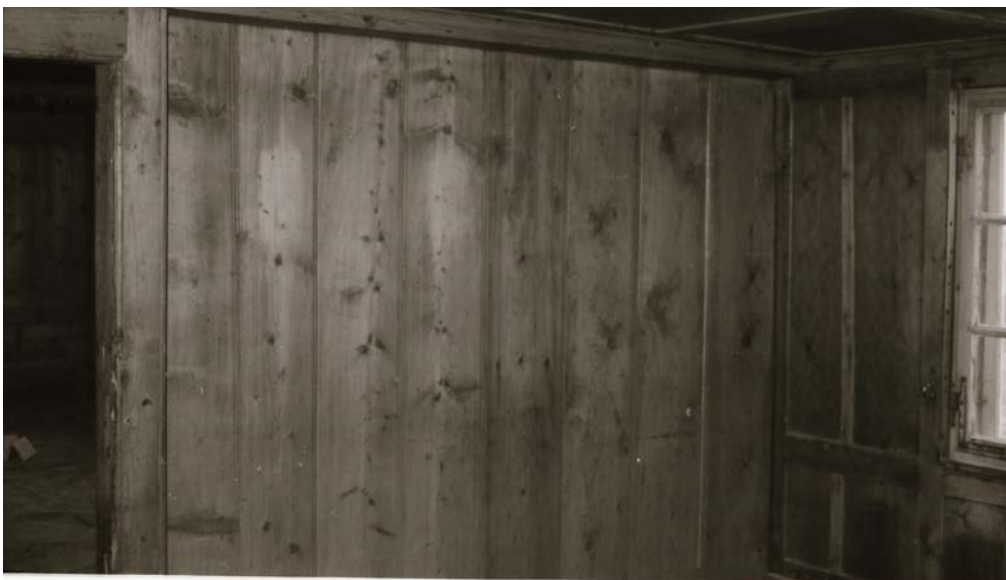
17 In den Kammern neben der Küche unterschied sich das Täfer an der Außenwand von demjenigen der inneren Trennwand. Daher ist anzunehmen, dass die Trennwand zu einem späteren Zeitpunkt eingebracht wurde. Foto, 1974 (FLM, BalFot 19657).
