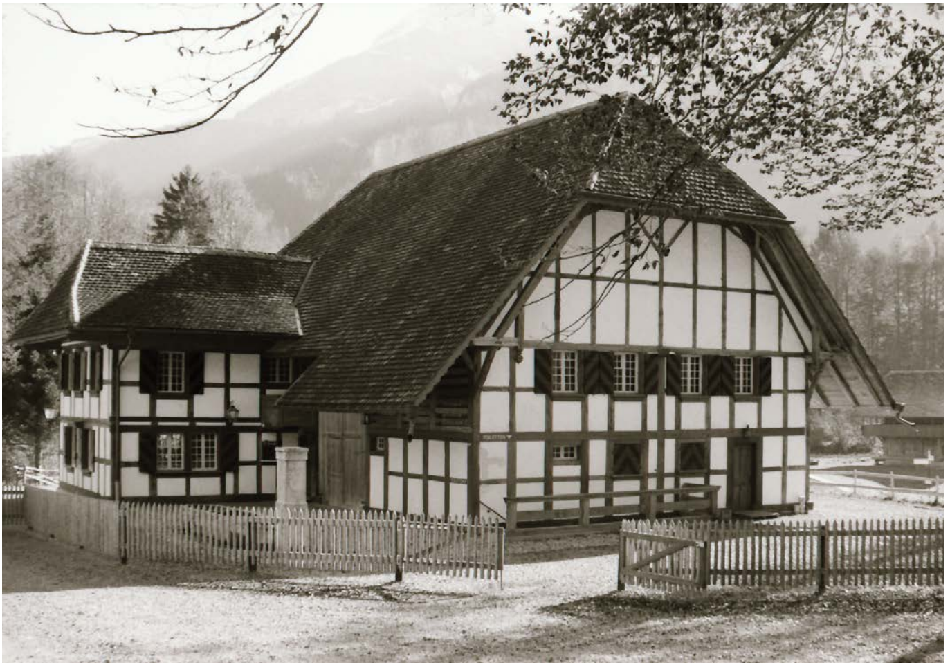
29 Das Bauernhaus mit Wirtsstube aus Rapperswil BE wurde im Freilichtmuseum als Museumsgaststätte am ehemaligen Ein- und Ausgang wiederaufgebaut. Die Einzäunung des Museumsgebietes befand sich direkt vor dem Haus. Foto, 1978 (FLM, BalFot 19604).
