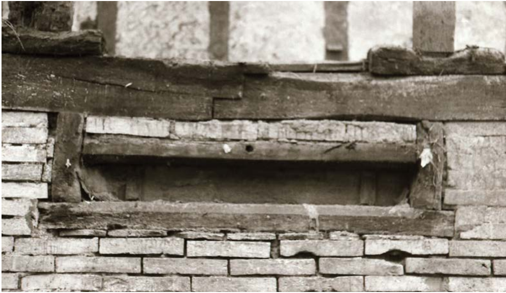
22 Die Wand zwischen Stall und Tenn war aus Backsteinen gemauert. Die Futterluken hatten ein Holzgewände. Foto, 1974 (FLM, BalFot 19669).
