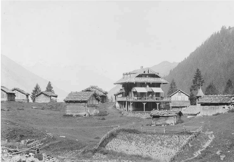
Abb. 99. Schärhag und Lattähag kombiniert, bei Pension Stäubi in Äsch (Unterschächen), um 1900/1910. Foto Michael Aschwanden, Staatsarchiv des Kantons Uri.
