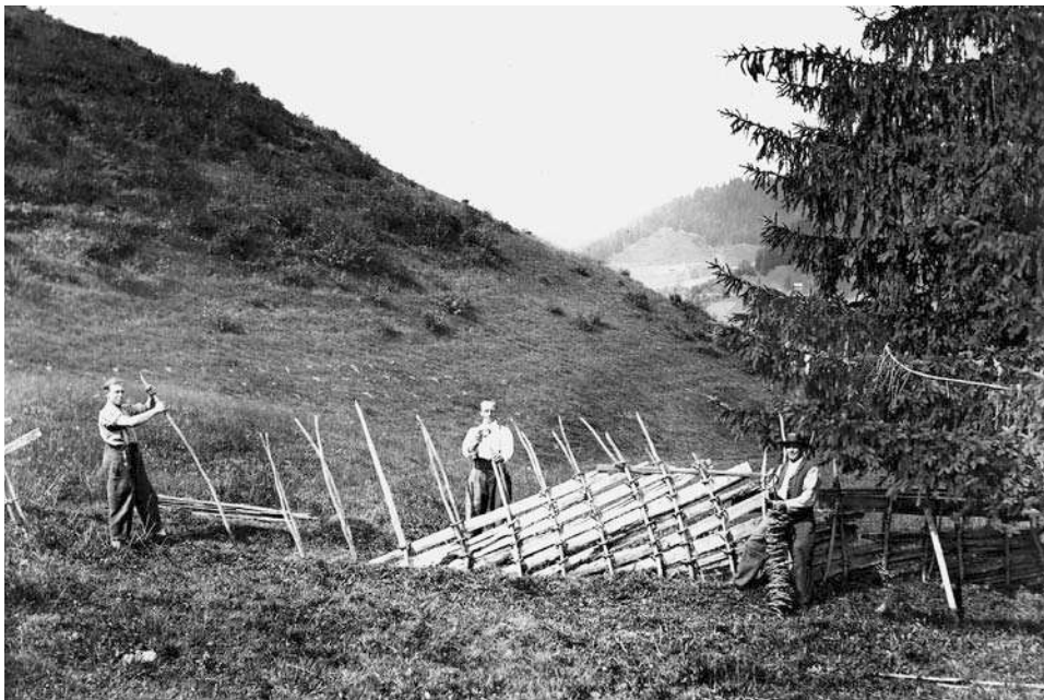
Abb. 32. Erstellen eines Schweiffelzauns, Teufenthal bei Thun (BE). Schweizerisches Institut für Volkskunde, Basel.
