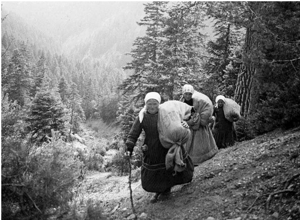
Abb. 35. Frauen tragen in Säcken gesammeltes Moos zum Abdichten der Wasserleitungen (Suonen), bei Savièze (VS) um 1935. Foto Charles Paris, Mediathek Wallis, Sion.
