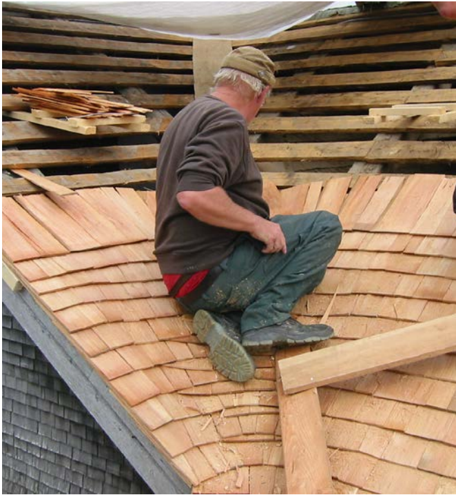
24 Das Schindeldach des Hauses wurde 2010 erneuert. Foto, 2010 (FLM digKat).
