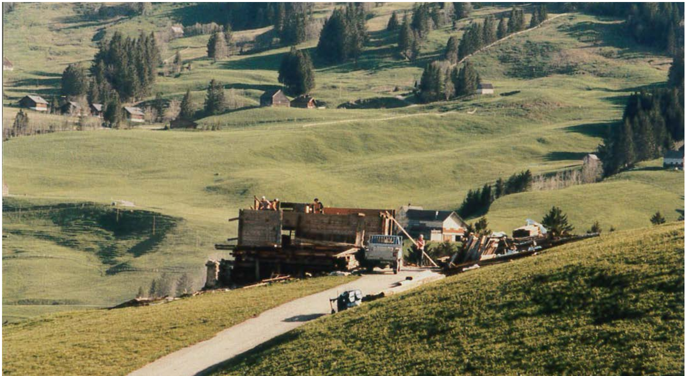
21 Beim Abbau des Bauernhauses in Brülisau wurden die Holzbauteile Balken für Balken abgetragen und zum FLM transportiert. Foto, 1984 (FLM AltA 545).
