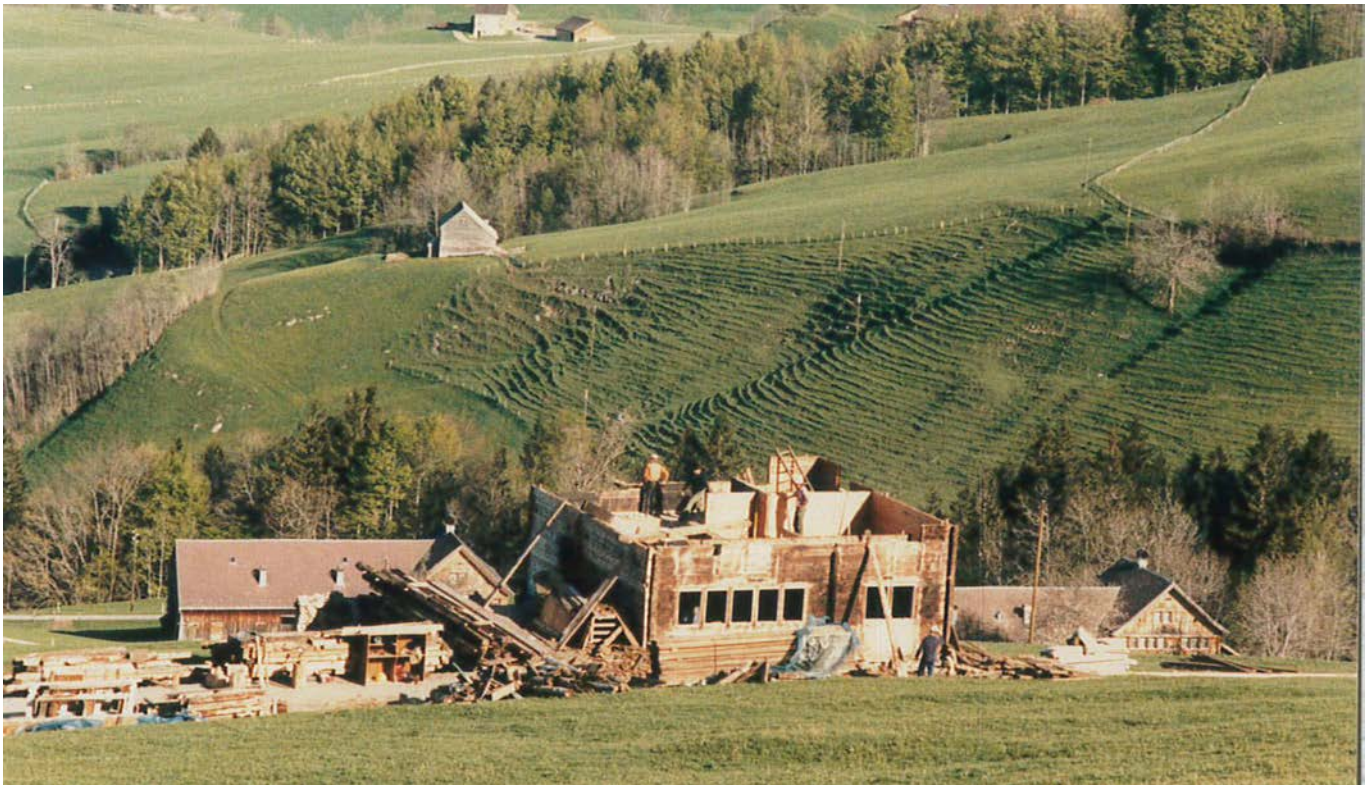
22 Zuerst wurde die Stallscheune abgebaut, anschliessend das Wohngebäude. Foto, 1984 (FLM AltA 545).
