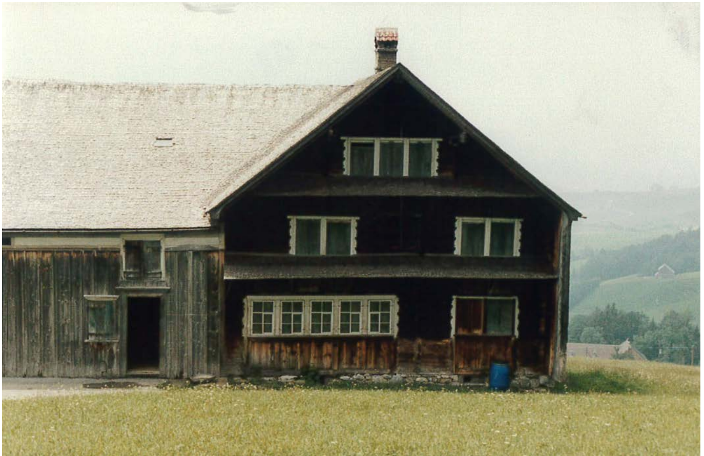
10 Die Schauffassade des Wohnhauses war nach Osten ausgerichtet. Die Fenster waren mit weissen Zierrahmen versehen. Foto, vor 1984 (FLM AltA 545).
