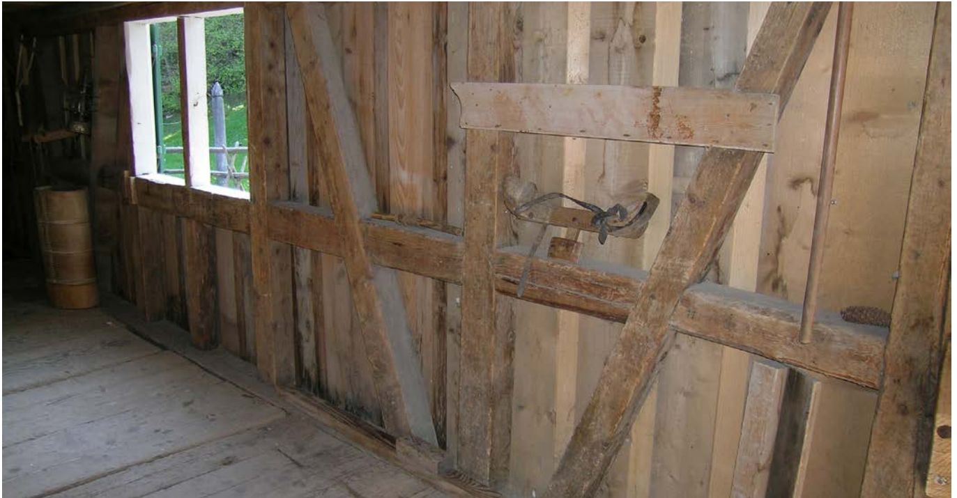
26 Die verbretterte Fachwerkwand der «Vorbrugg» im Museumsbau. Foto, 2011 (FLM digKat).
