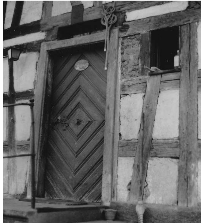
14 Der Hauseingang war auf der Nordseite. Über der Türe befand sich ein Oberlicht. Foto, vor 1969 (FLM AltA 514).
