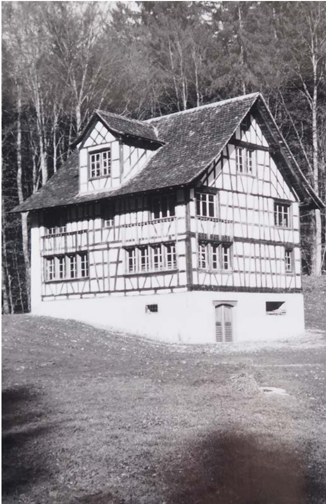
26 Das neue Museumgebäude von Südosten. Grössere Veränderungen wurden hauptsächlich am Sockelgeschoss vorgenommen. Foto, um 1975 (FLM AltA 517).
