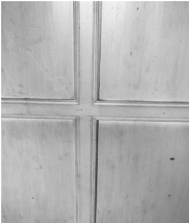
24 Detail des Deckentäfers am ehemaligen Standort mit sich überkreuzenden profilierten Leisten. Foto, vor 1969. [FLM AltA 517].
