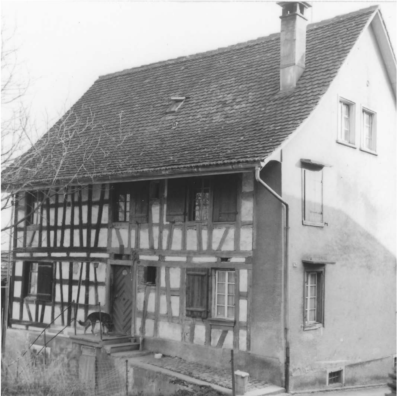
20 Die westliche Seite des Fachwerks der Nordfassade wurde im 20. Jahrhundert in grossen Teilen ausgetauscht. Auf dem Foto vom ehemaligen Standort sind deutlich die farblichen Unterschiede zwischen den älteren und neueren Hölzern zu sehen. Foto, vor 1969. (FLM AltA 517)..
