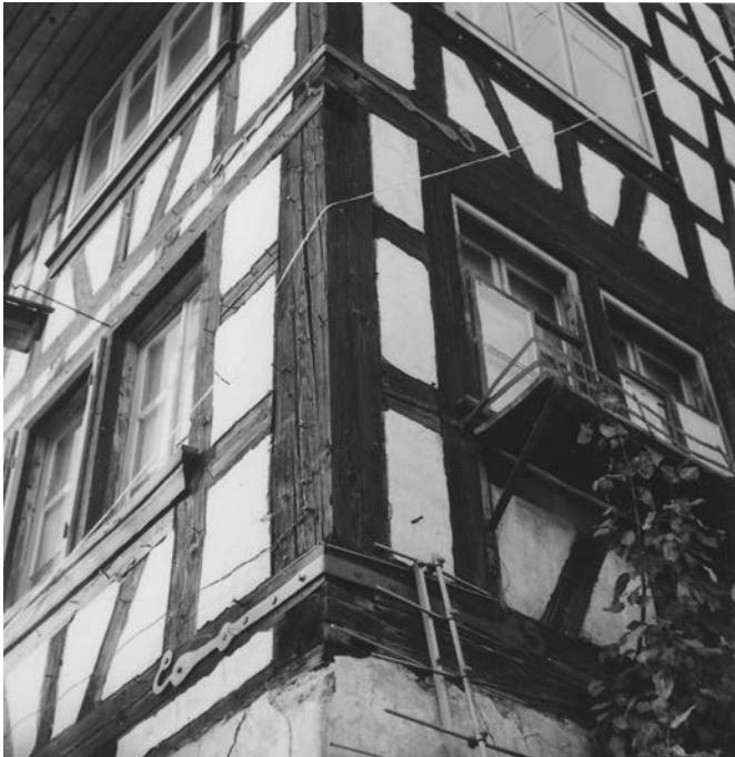
8 Nordostecke des Hauses am ehemaligen Standort mit verkämmten Schwellenbalken mit Eisenbändern, Foto, vor 1969. (FLM AltA 514).
