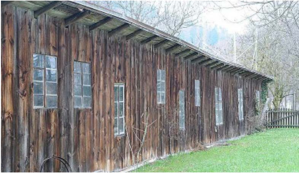
9 Die Südfassade der Seilerei aus Unterägeri ZG war stark durchfenstert. Die wiederverwendeten Fenster waren von unterschiedlicher Grösse und unregelmässig über die Fassade verteilt. Foto, 2010 (FLM, 1061-Unterägeri. Fotos alter Standort, Lidostrasse 21, 004_VS).
