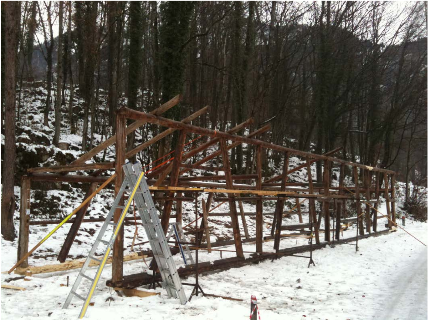
17 Der Wiederaufbau der Seilerei aus Unterägeri ZG am neuen Standort im Freilichtmuseum Ballenberg Foto 2011 (FLM digKat).
