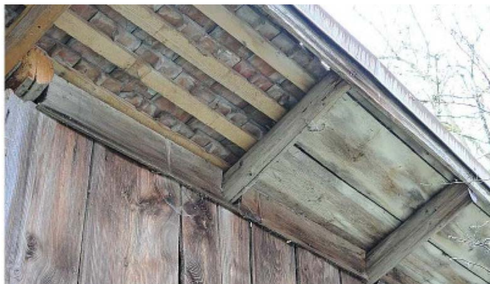
11 Das Pultdach war mit Biber-schwanzziegeln gedeckt, die Unterseite des Dachüberstands war verbrettert. Foto, 2010 (FLM, 1061-Unterägeri. Fotos alter Standort, Lidostrasse 21, 029_VS).
