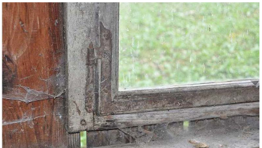
14 Die Fensterbeschläge der wiederverwendeten Fenster datieren teilweise in die Zeit um 1800. Foto, 2010 (FLM, 1061-Unterägeri. Fotos alter Standort, Lidostrasse 21, 055_VS).
