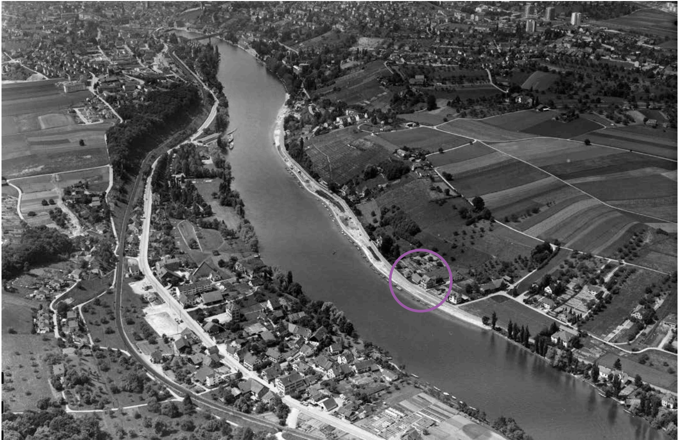
4 Die Luftaufnahme zeigt den bis weit ins 20. Jahrhundert hinein dünn besiedelten östlichen Ausläufer der Stadt Schaffhausen und das Bauensemble der beiden Ökonomiegebäude, der Trotte und des jüngeren Gasthauses. Foto Comet Photo AG, 1963 [ETHZ BildA Com_F63-00547].
