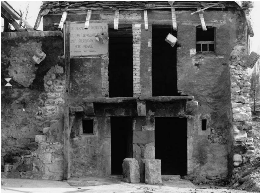
10 Der Taubenschlag kurz vor seinem Abbau. Foto, 1984 (FLM AltA 104.01) / 11 Die Baufuge zwischen dem Wohn- und dem nordwestlichen Ökonomieteil belegt, dass die beiden Gebäudeteile nicht zeitgleich entstanden sind. Foto, 1984 (FLM AltA 113).
