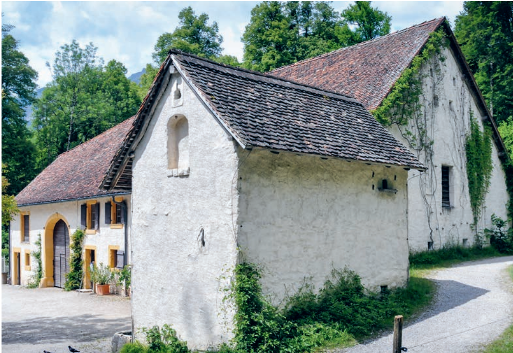
23 Das Taubenhaus mit Ausflüglöchern aus zweitverwendeten Schiessscharten des Schlosses Saconnex d'Arve. Ansicht Südost, Foto FLM, 2018 (FLM BildA).
