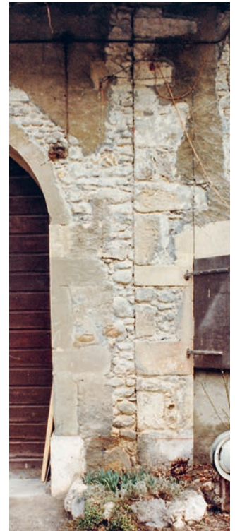
10 Der Taubenschlag kurz vor seinem Abbau. Foto, 1984 (FLM AltA 104.01) / 11 Die Baufuge zwischen dem Wohn- und dem nordwestlichen Ökonomieteil belegt, dass die beiden Gebäudeteile nicht zeitgleich entstanden sind. Foto, 1984 (FLM AltA 113).
