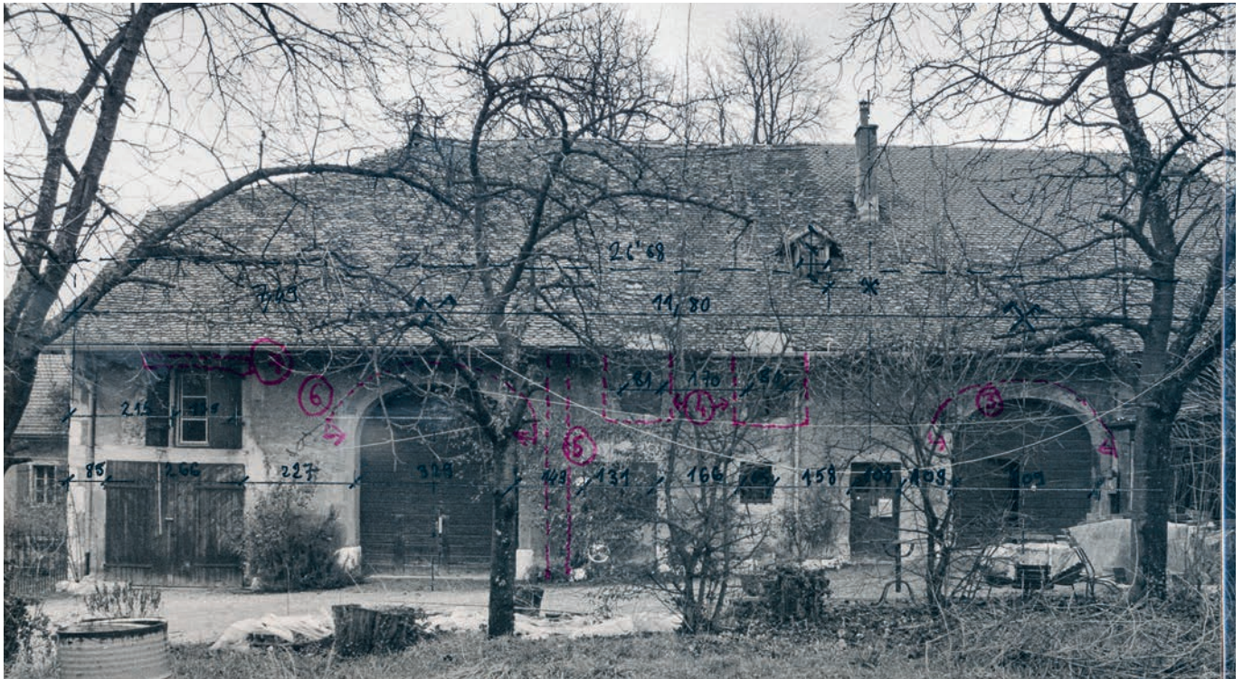
9 Die Schauseite des Mehrzweckgebäudes aus Lancy GE wies nachträgliche Eingriffe auf. Ansicht ehem. Südwest. Fotogrammetrische Bauaufnahme, 1984 (FLM AltA 111).
