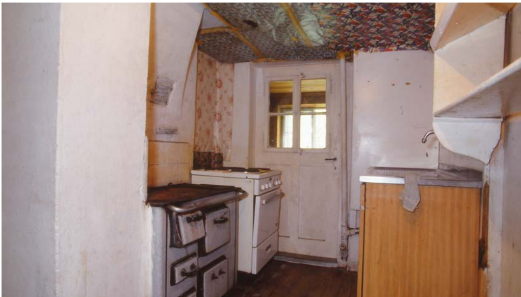
18 Im 19. Jahrhundert wurde in der Mitte des Hauses ein Gang abgetrennt. In den westlichen Teil des Ganges, vor der Nebenstube im Hauptgeschoss, wurde eine Küche eingebaut. Belichtet wurde die Küche durch ein Fenster in der Türe, die zur Westlaube führte. Dia: Georg Sidler, Juli 1995 (FLM BalFot 54143).
