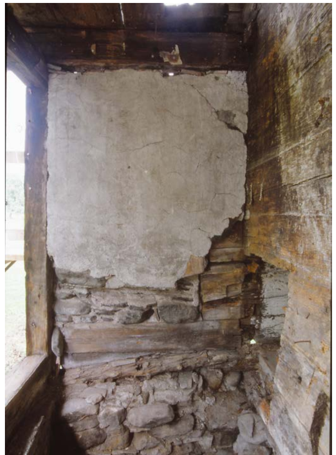
24 Die Nordwand der Westlaube war im Hauptgeschoss ausgemauert und verputzt. Vor der Wand befand sich ein Abort. Dia: Georg Sidler, Okt.1995 (FLM BalFot 54178).
