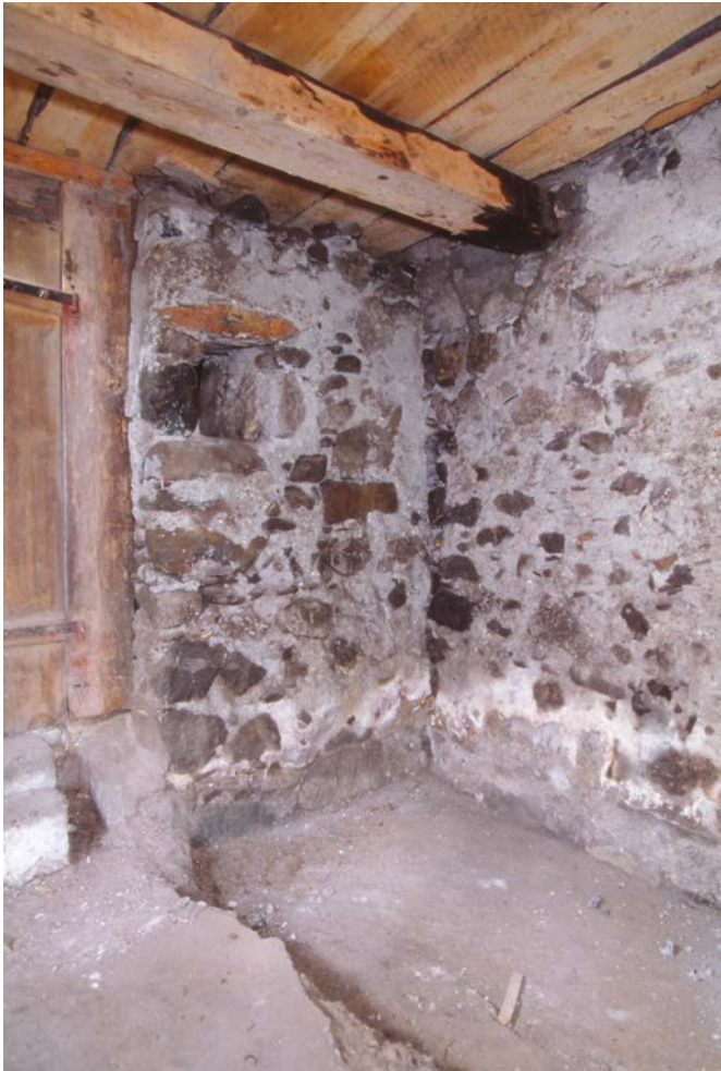
8 In der Südwestecke im Sockelgeschoss wurde der bauzeitliche Mörtelstrich freigelegt. Dia: Georg Sidler, Juli 1995 (FLM BalFot 54231)
