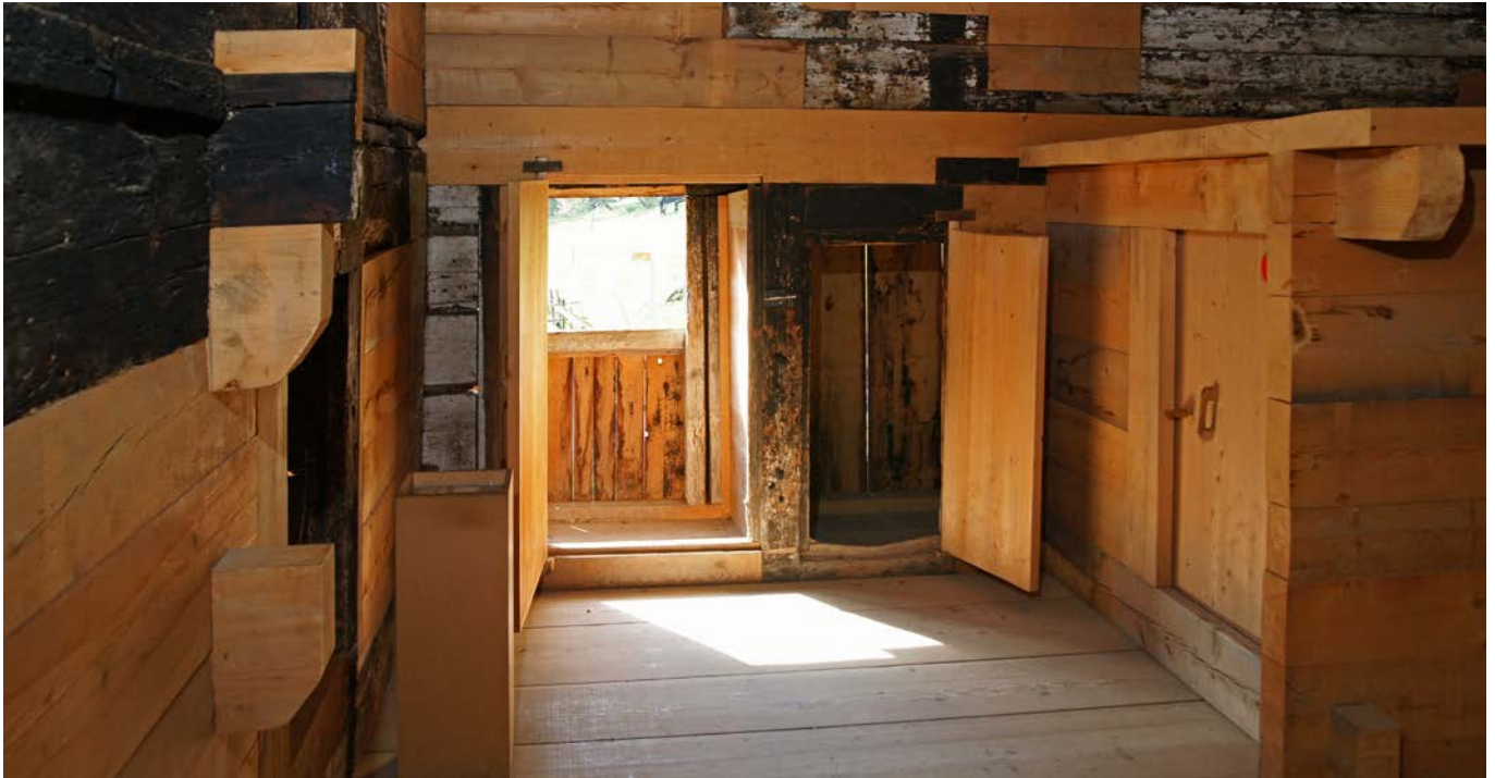
31 Später abgesägte Balkenköpfe wurden im Museumsbau rekonstruiert. Spätere Einbauten wurden entfernt. Fehlende und stark beschädigte Balken wurden ersetzt. In der Nordwestecke wurde analog zur Nordostecke eine Kammer rekonstruiert (FLM digKat).
