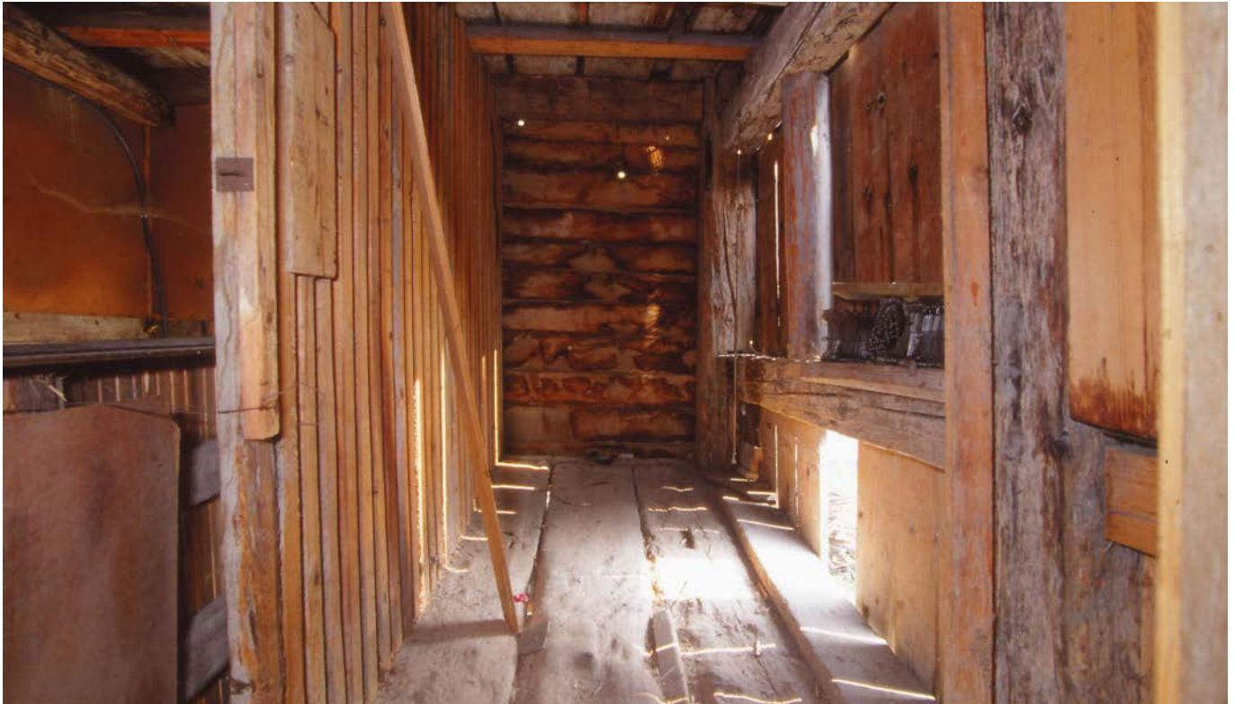
16 Neben dem Treppenaufgang befand sich in der Ostlaube im Hauptgeschoss ein sogenannter «Stapelraum», der als Lagerfläche genutzt wurde. Blick von Süden nach Norden. Dia: Georg Sidler, Juli 1995 (FLM BalFot 54138).
