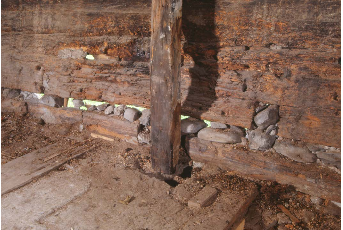
25 Beim Abbau kamen an der Nordwand im Hauptgeschoss Spuren einer ehemaligen Herdstelle zum Vorschein. Ein Schlitz zwischen den Balken und ein seitliches Balenloch waren mit Steinen verfüllt. Die Wand darüber war verglast. Dia: Georg Sidler, Juli 1995 (FLM BalFot 54234).
