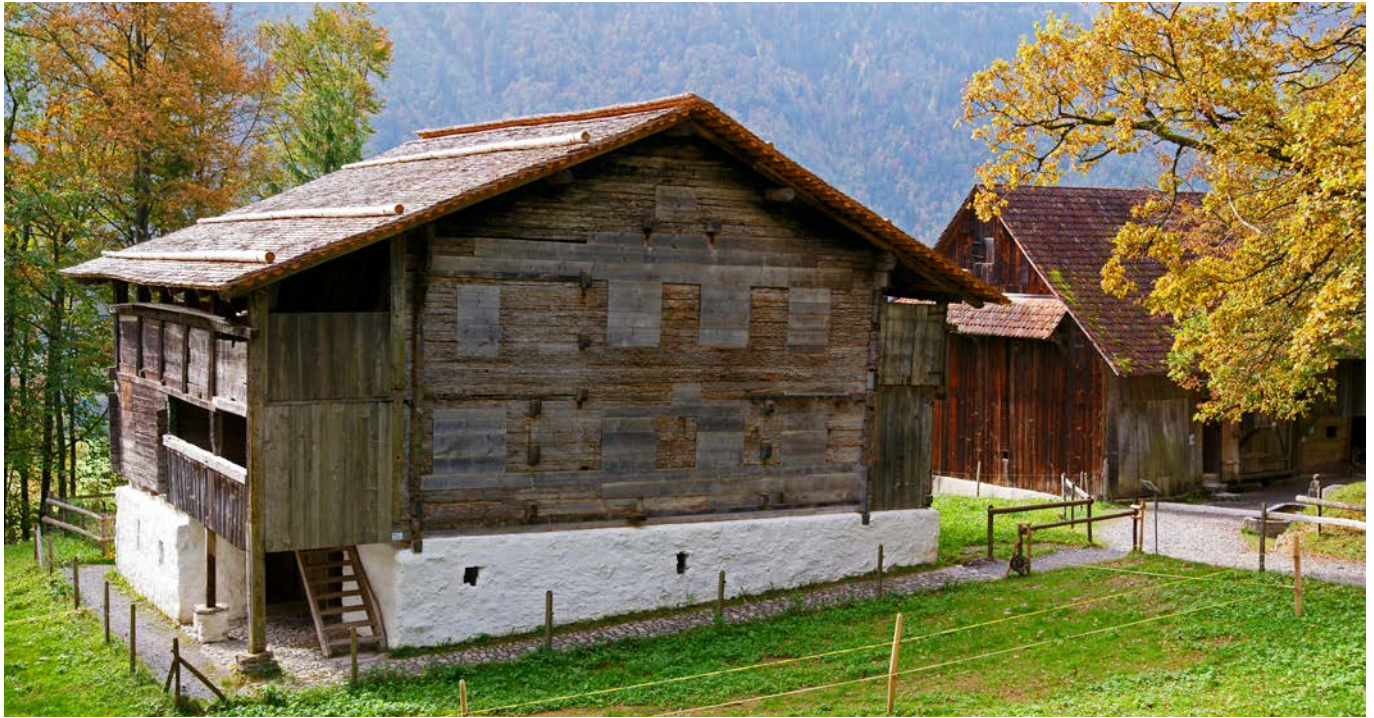
30 Im Freilichtmuseum wurde das Haus in einen Bauzustand «um 1400» rückgebaut. Die im 19. Jahrhundert in die Nordfassade eingebrachten Öffnungen wurden wieder geschlossen. Schindelschirm und Verbretterung wurden entfernt und die Balken sichtbar gelassen (FLM digKat).
