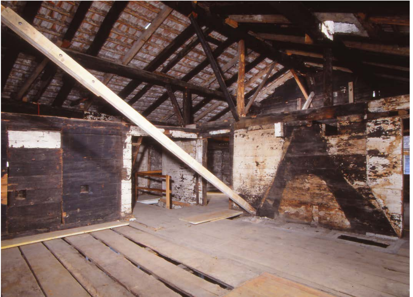
10 Im Dachgeschoss waren die Spuren eines ehemaligen Kaminhuts an der Trennwand zwischen Nord- und Südteil sichtbar. Dia: Georg Sidler, Okt. 1995 (FLM BalFot 54184).
