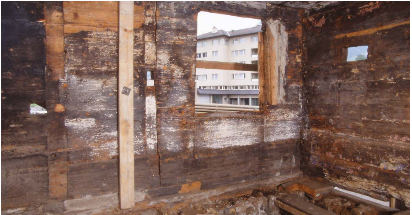
26 Beim Abbau kamen im Hauptgeschoss, im östlichen Teil der Nordwand Spuren von zwei ehemaligen Wandeinbauten zum Vorschein. Hauptgeschoss, Neben dem später eingebrachten Fenster in der Nordwand fand sich in der Ostwand noch ein bauzeitliches Lukenfenster Dia: Georg Sidler, Juli 1995 (FLM BalFot 54235).
