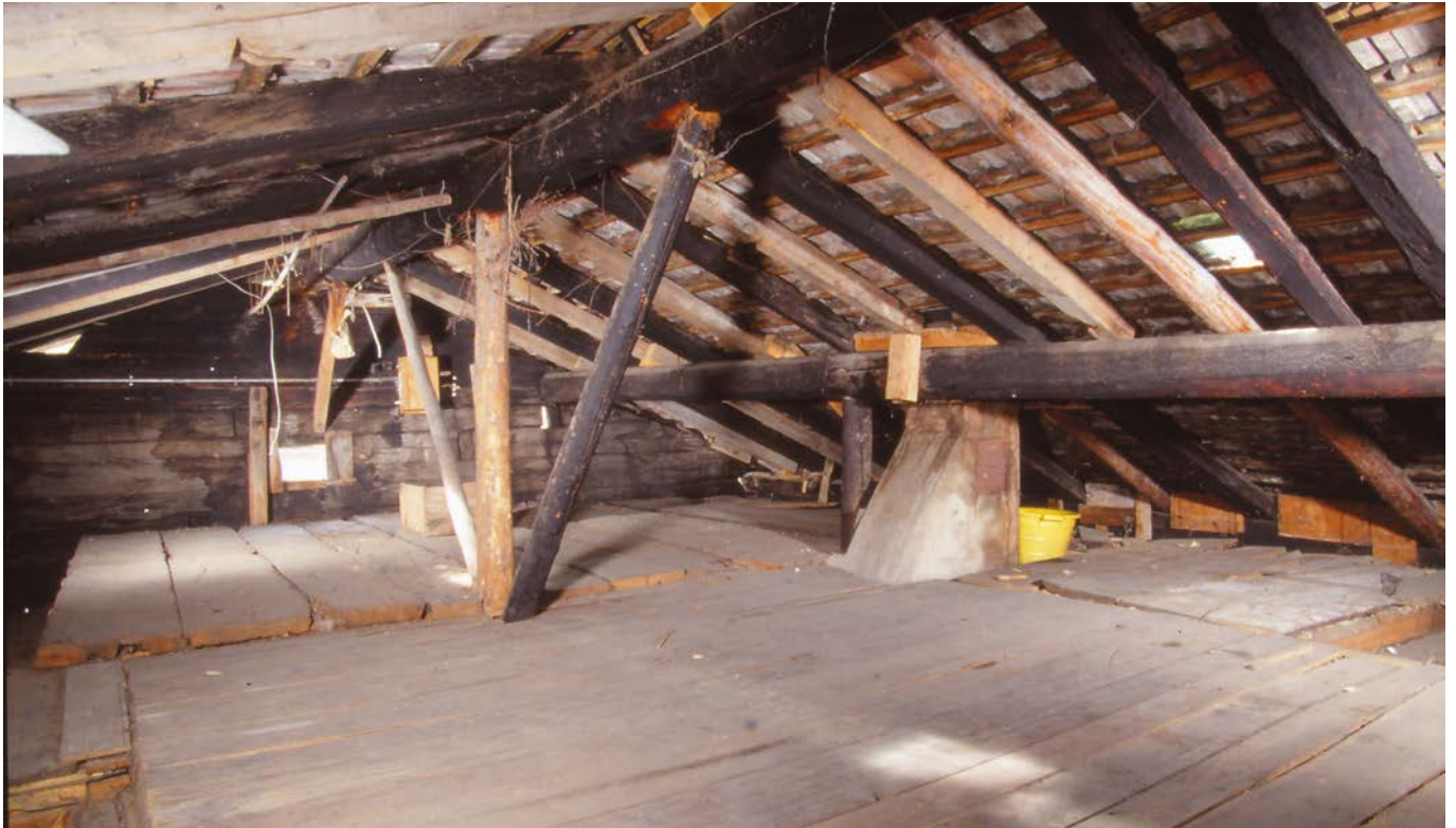
15 Im 20. Jahrhundert wurde die Dachkonstruktion verstärkt: Die hinzugekommenen Rafen sind im Unterschied zu der älteren Konstruktion nicht russgeschwärzt. Dia: Georg Sidler, Juli 1995 (FLM BalFot 54114).
