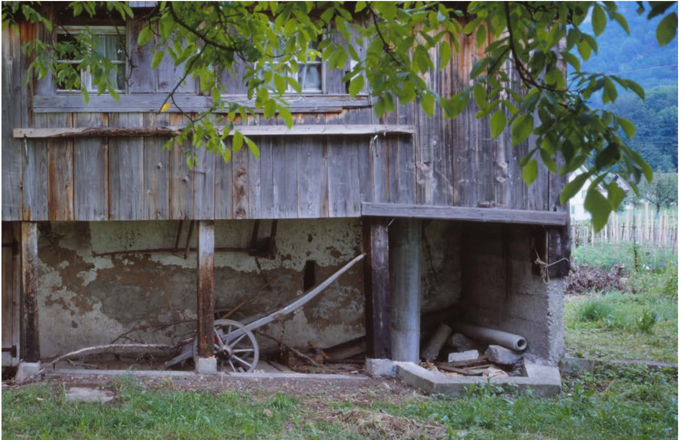
12 Der Raum unter der westlichen Laube erhielt 20. Jahrhundert eine Betonwand und eine neue Sickergrube. Dia: Georg Sidler, vor 1997 (FLM BalFot 54271).
