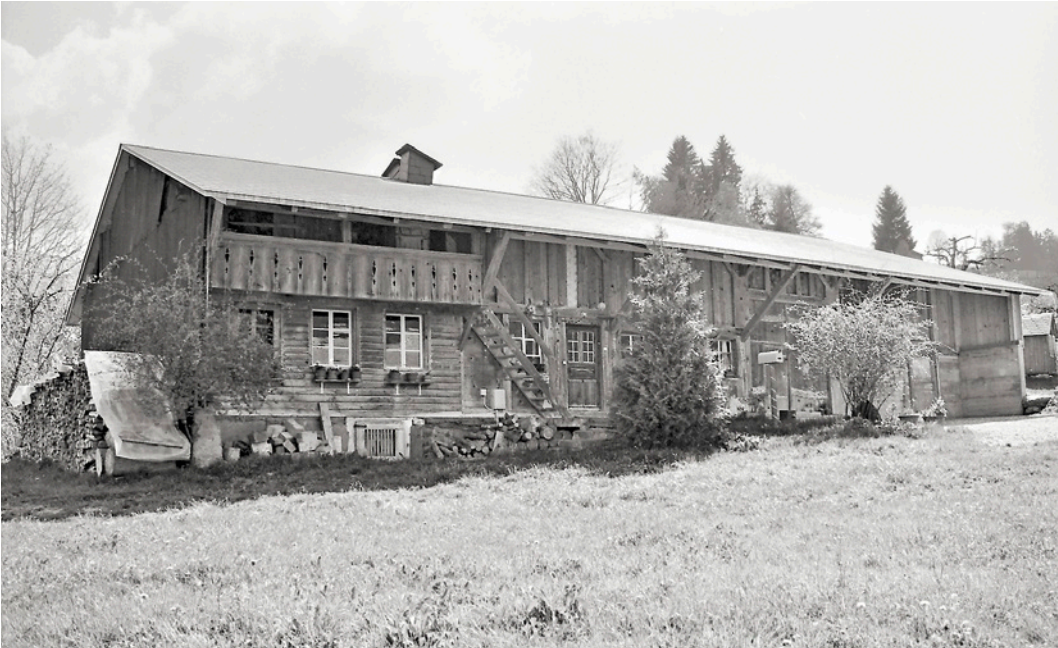
Abb. 2: Rüscheegg Sangern 183, Zustand 2008. Die Nordhälfte des Hostettlergutes wurde in den letzten dreihundert Jahren mehrfach umgebaut. Im Vordergrund der 1880 erneuerte Stubentrakt mit der angehobenen Vordachlaube. Blick nach Südwesten.
