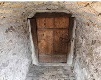
66 Reichenbach i. Kandertal, Kientalstrasse 12
