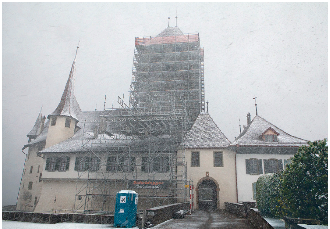
Abb. 1: Spiez, Schloss. Der eingerüstete Turm im Schneegestöber im Winter 2018/19. Blick nach Osten.
