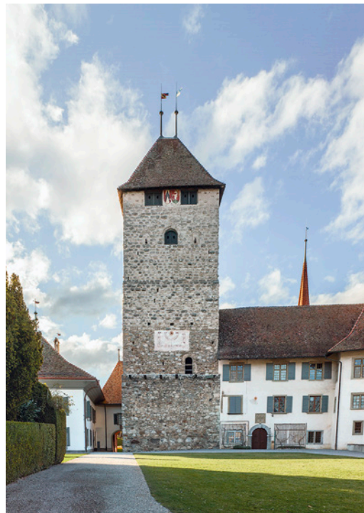
Abb. 5: Spiez, Schloss. Die hofseitige Fassade (Ostfassade) des Turms im Frühling 2019. Zu berücksichtigen ist, dass die untersten 4 m des Turmes nicht sichtbar sind, weil sie in einer Grabenaufschüttung stecken. Blick nach Nordwesten.
