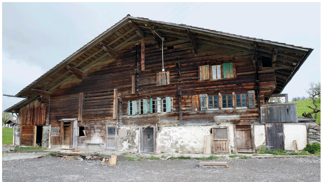
Abb. 1: Aeschi b. Spiez, Suldhaltenstrasse 31. Westfassade an der Suldhaltenstrasse, rechts der Wohnteil mit der 1779 ausgewechselten Wohnstube und links die seitlich angeordnete vergrösserte Ökonomie von 1849.
