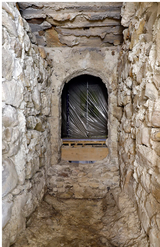
Abb. 5: Grosshöchstetten, Schlosswil, Schloss Wyl. Blick durch den wiedergeöffneten Hocheingang ins Turminnere. Oben sind Negative der Balken, die den Durchgang abdeckten, zu erkennen. Die unverputzten Wände waren vielleicht mit einer Holzverschalung versehen.
