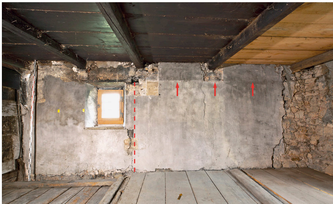
Fig. 7 : Petit-Val, Souboz, Haut du Village 37. Chambre nord. On remarque sur le mur nord, juste à droite de la fenêtre, la trace d'une cloison disparue (tireté) et surtout un rehaussement du plafond (daté vers 1820/25) marqué par un rhabillage de l'enduit (flèches).
