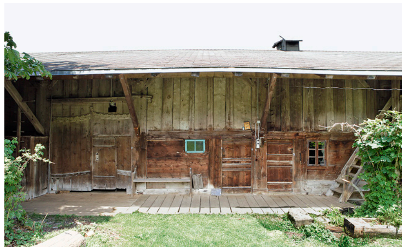
Abb. 16: Rüschegg Sangern 183. Südliche Haushälfte zwischen dem zweiten und fünften Querbund. Abgesehen von den vergrösserten Fenstern präsentiert sich dieser Bereich in ursprünglicher Gestalt. Blick nach Norden.
