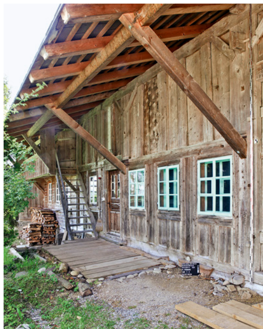
Abb. 10: Rüschegg Sangern 183. Wohntrakt der nördlichen Haushälfte zwischen dem zweiten und vierten Querbund. Die Nebenstube im Vordergrund (Raum 7, Abb. 13) ersetzte einen Schmalviehstall. An den Bundachsenschnittpunkten zeigen sich auf Schwelbalkenhöhe die alten Zapfenschlösser. Gerüst und Gefüge im Dachgeschoss sind überwiegend original. An den Ständerbohlenwänden finden sich die regionaltypischen, tupfenartigen Verzierungen. Blick nach Südosten.
