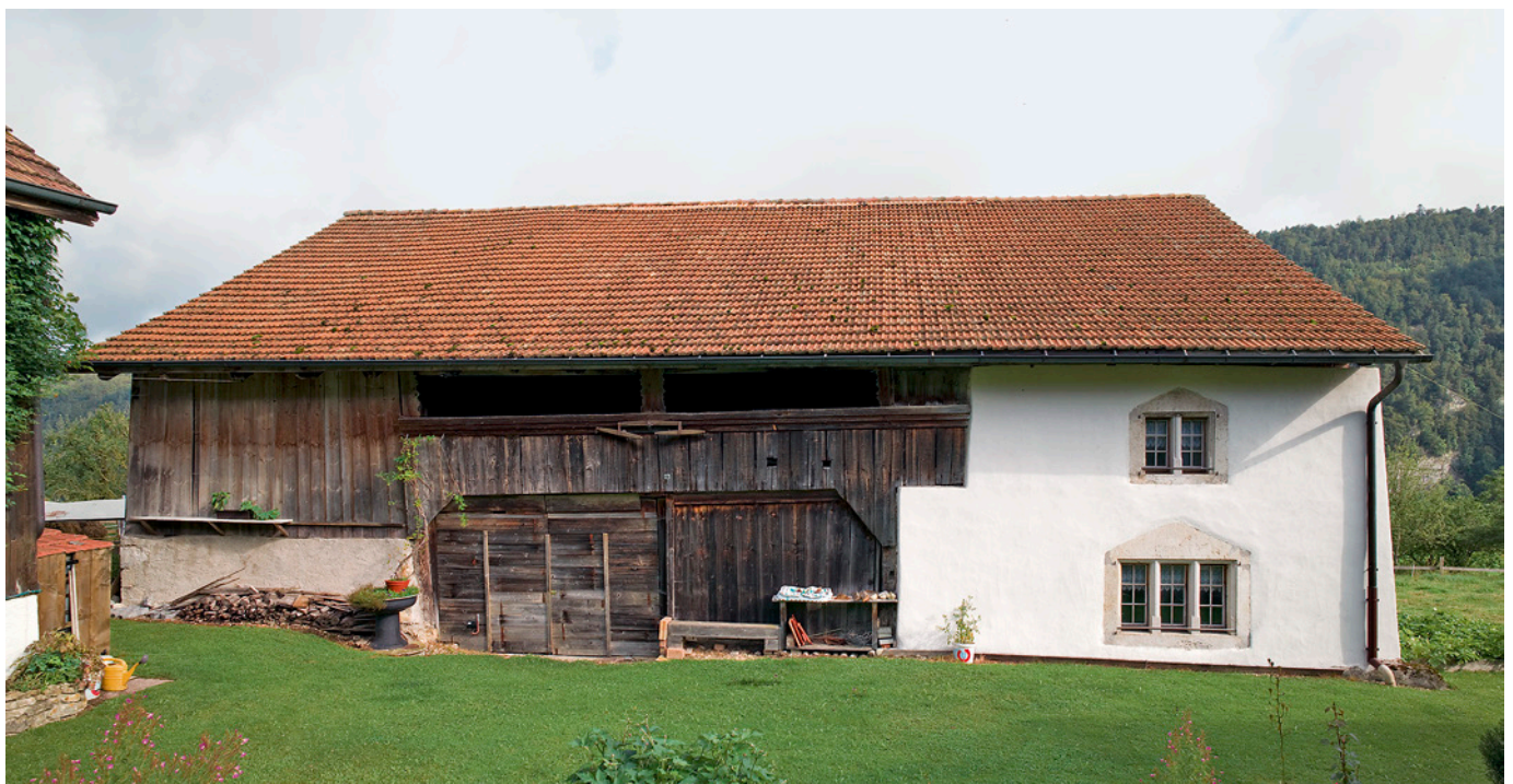
Fig. 1 : Petit-Val, Souboz, Haut du Village 37. Façade sud du bâtiment. Au centre, la porte du devant-huis et, à droite, le corps de maçonnerie percé de deux baies à meneaux.
