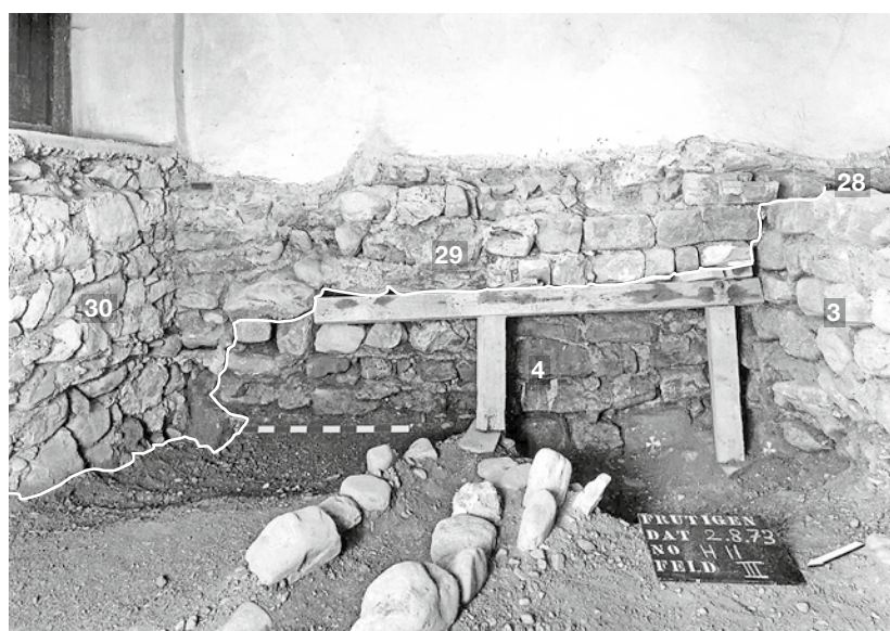
Abb. 14: Frutigen, Kirche. Ansicht an die nördliche Schultermauer des Schiffes (Tagebuchskizze und Foto). Unter der vorragenden Schultermauer von 1727 (29) liegt das ältere gerade Mauerstück (4). Blick nach Osten. M. ca. 1:50.
