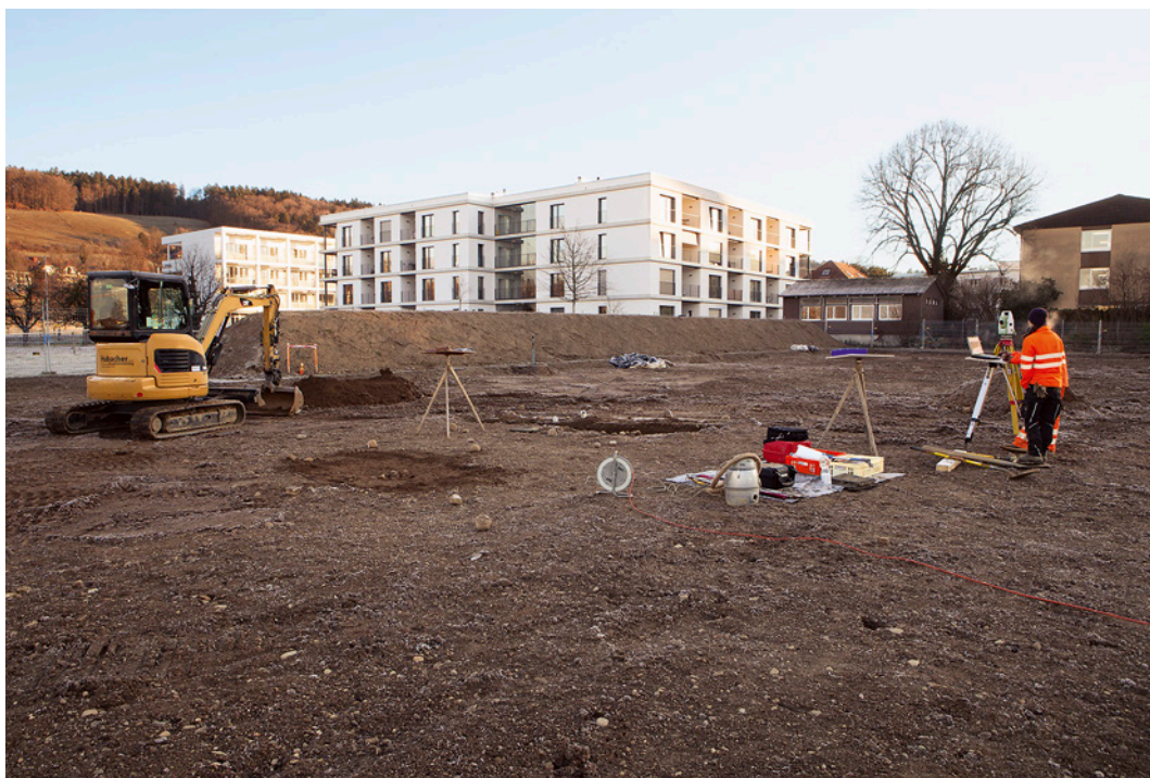
Abb. 1: Muri b. Bern, Allmendingenweg 3, 3a, 3b. Bei der Rettungsgrabung wurden nach Abtrag der oberen Bodenschichten auffällige Strukturen kleinflächig freigelegt, eingemessen und dokumentiert, bevor sie zur weiteren Untersuchung und Fundbergung mit dem Bagger geschnitten wurden. Blick nach Nordosten.
