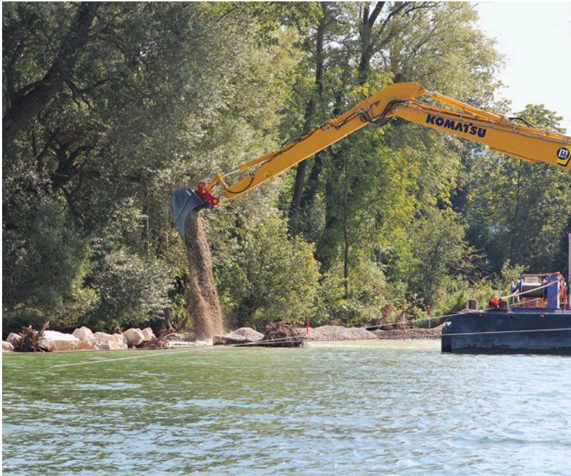
Abb. 10: Kokosmatten und Kies schützen die gefährdeten, jungsteinzeitlichen Kulturschichten unter Wasser der Unesco-Welterbe-Fundstelle Sutz-Lattrigen, Rütte. Der Uferbereich wurde mit Dämmen vor weiterer Erosion geschützt.
