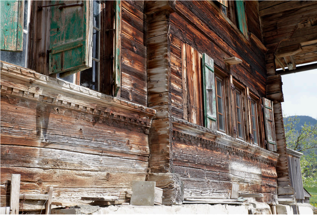
Abb. 6: Aeschi b. Spiez, Suldhaltenstrasse 31. Die 1779 erneuerten Reihenfenster auf der Westseite des Stubengeschoßes. Typisch für den Holzbau dieser Zeit sind in der Region reich profilierte und mit Flachschnitzereien verzierte Brüstungs- und Sturzhölzer um die Fensterzone der Wohnräume. Die heute stark verwitterten Hölzer dürften ehemals noch bunt bemalt gewesen sein. Blick nach Süden.
