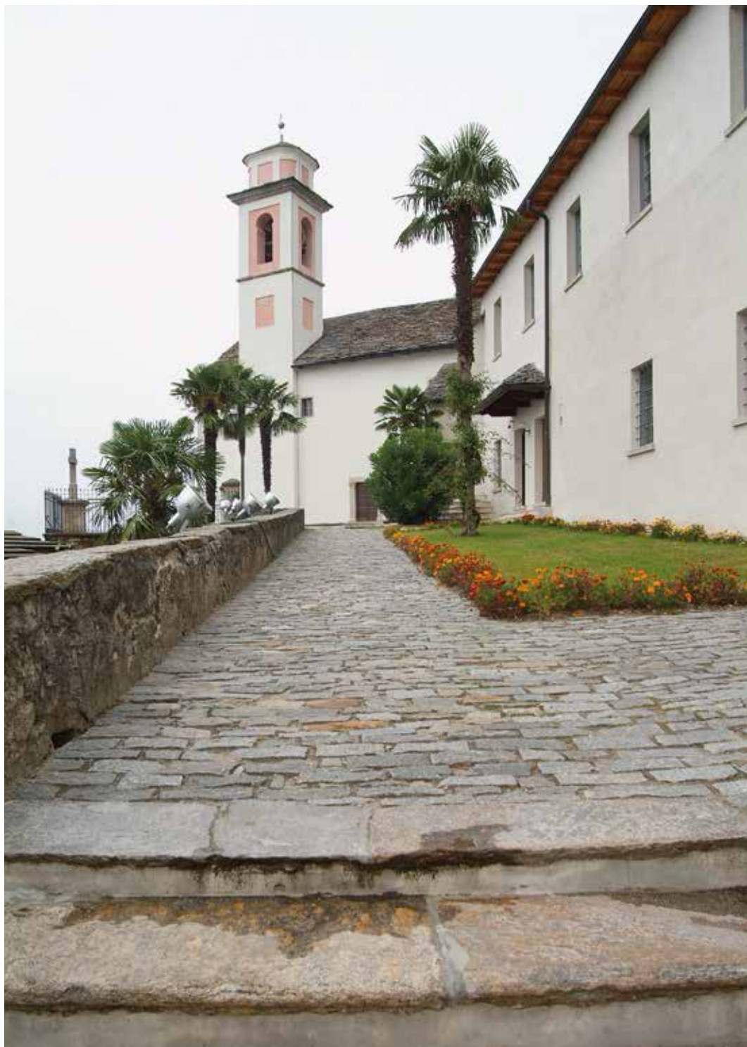
Tav. 5. La chiesa di Santa Maria Assunta di Claro attualmente restaurata. Il campanile fu costruito nel 1783 su progetto di Tommaso Colonetti e ingloba quello romanico. Sulla sinistra s'intravede il cimitero delle monache. (© Associazione Amici del Monastero)
