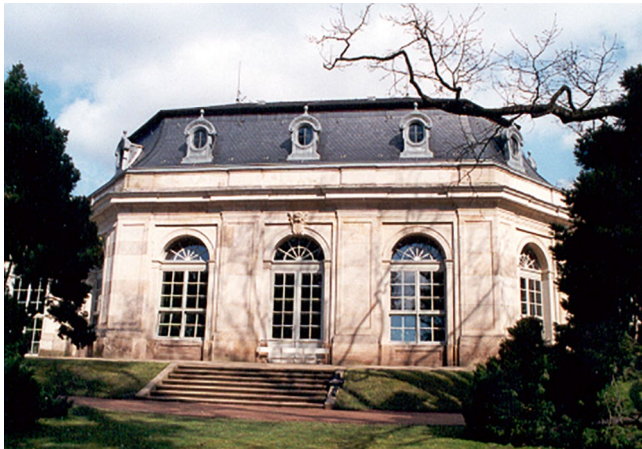
Abbildung 8. Mittelbau der Orangerie; ehem. Ringrennhaus (heutiger Zustand).
