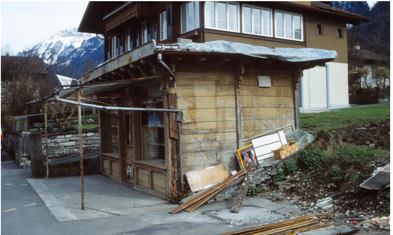
14 Die geschlossene Südwestseite vor dem Abbau. Foto, 1993 (FLM digKat).
