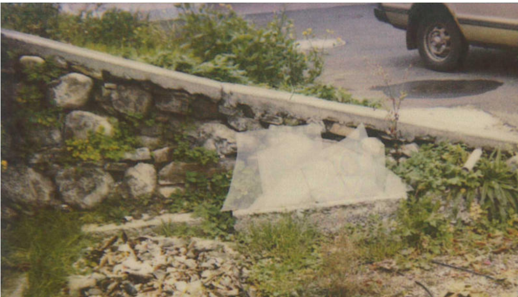
16 Beim Abbau des Kiosks wurden die den Hang stützenden Bruchsteinmauern sichtbar. Foto, 1993 (FLM digKat).
