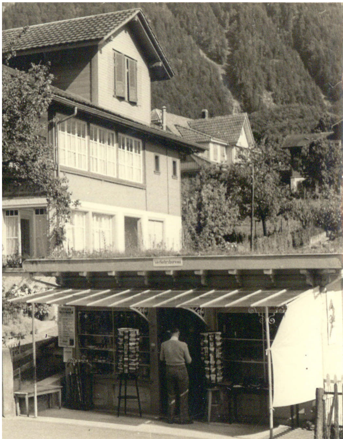
4 Der Kiosk stand neben dem Wohnhaus. Der Platz vor dem Kiosk war durch ein Glasdach überdeckt unter dem Postkartenständer aufgebaut waren. Foto, vor 1962 (Familienarchiv Rachelly).
