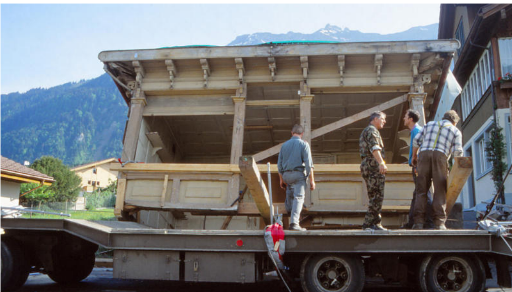
17 Am 18. Mai 1993 wurde der Kiosk als Ganzes verladen und zur Restaurierung zum Parkplatz Brienzwiler transportiert. Foto, 1993 (FLM digKat).
