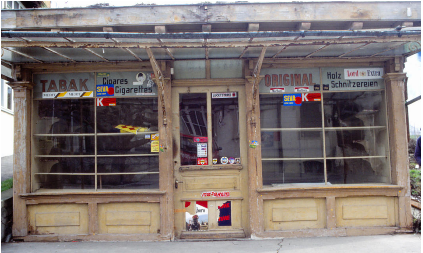
13 Die nach Nordwesten, zum Seeufer hin ausgerichtete Schauseite vor dem Abbau. Foto, 1993 (FLM digKat).
