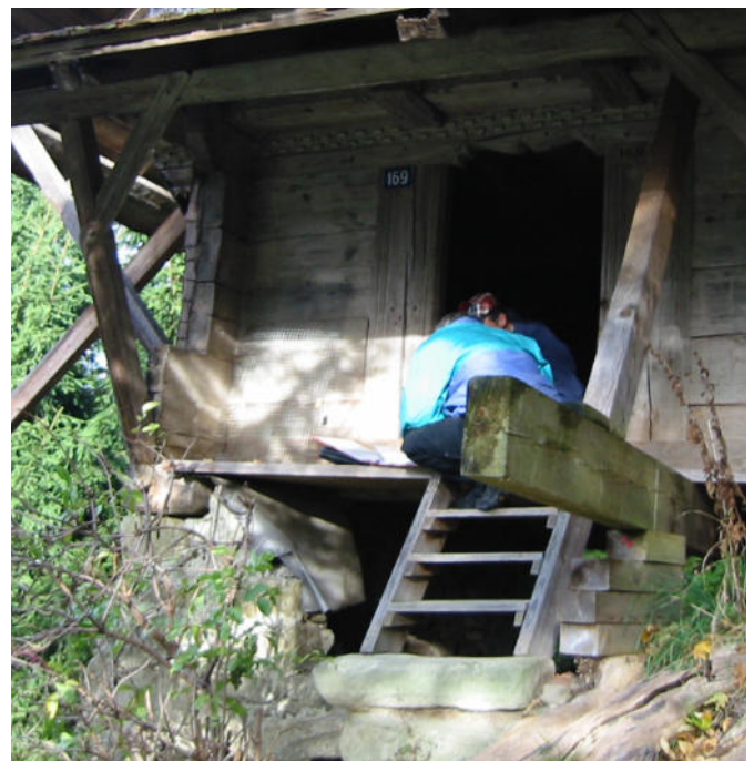
13 Der Speicherbau war über eine dreistufige Treppe erschlossen. Der vorkragende Balken ist Teil einer nachträglichen Stützkonstruktion. Ansicht Südost. Foto, 2002 (FLM digKat).
