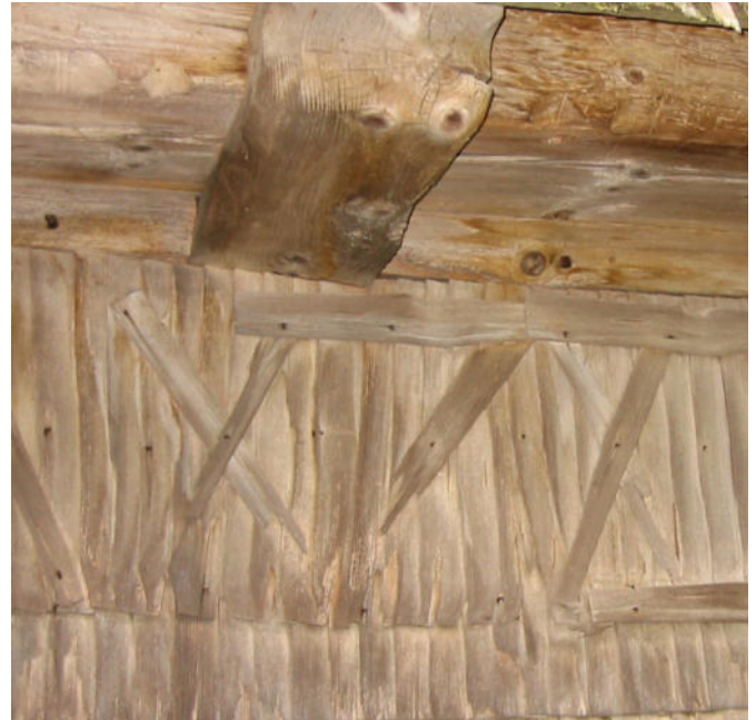
12 Die langen, schmalen Schindeln waren beim Abschluss des Hauptgeschosses kreuzweise angebracht. Ansicht Südwest. Foto, 2002 (FLM digKat).
