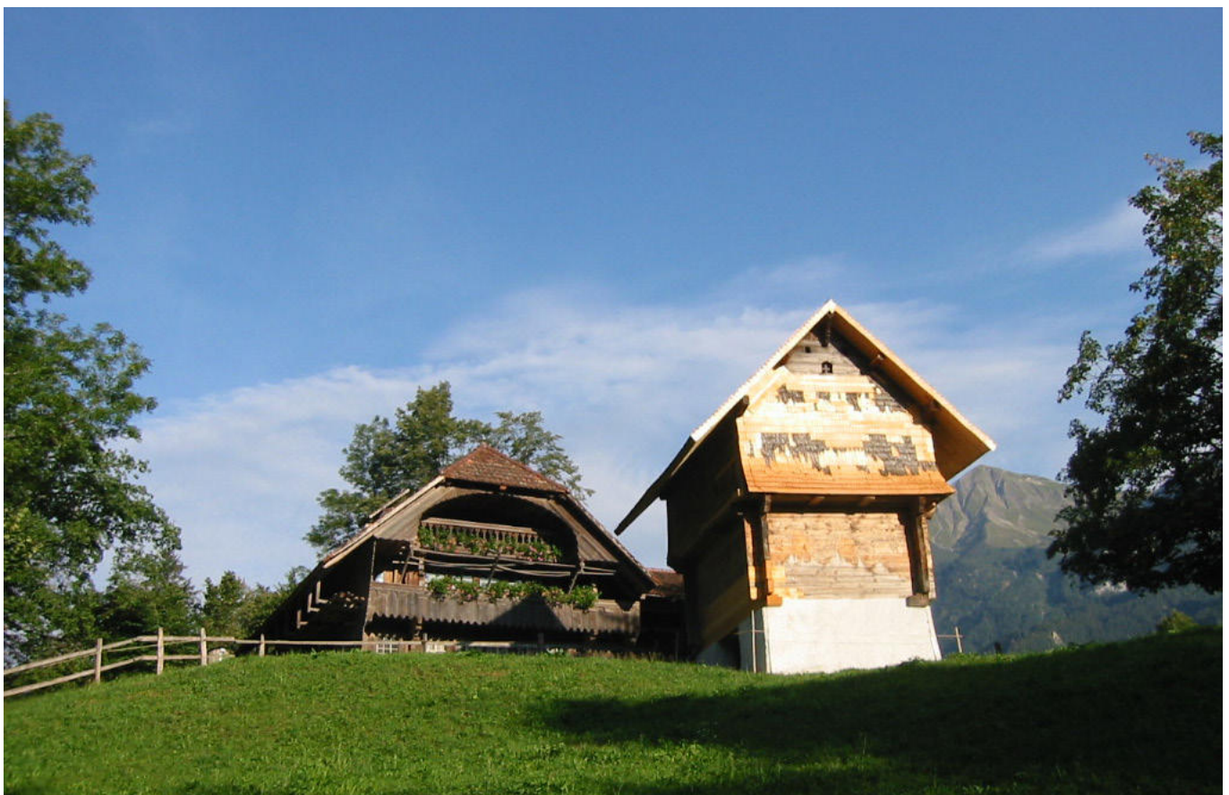
21 Der Kornspeicher aus Heitenried am neuen Standort in der Geländekammer Westschweiz. Gegenüber steht das Bauernhaus aus Tentlingen. Foto, 2007 (FLM, digKat).
