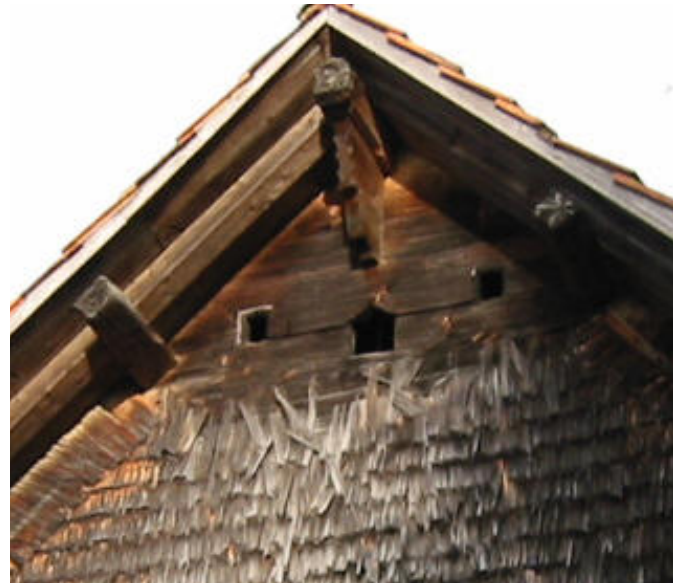
15 Im Giebfeld auf der Südostseite war das mittige Fenster abweichend gestaltet. Foto, 2002 (FLM digKat).
