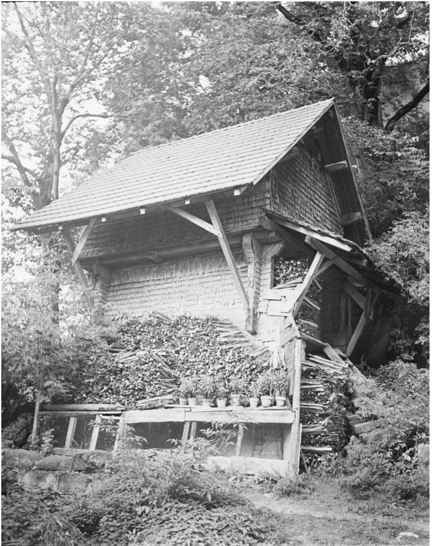
7 Der Kornspeicher wurde auch zur Lagerung von Brennholz unter den weit vorkragenden Dächern genutzt. An der Giebelseite ist eine einfache Holzterappe zu sehen, die in den Speicherbau führt, Ansicht Süd. Foto, April 1943 (© Amt für Kulturgüter Freiburg, Sammlung Héribert Reiners).
