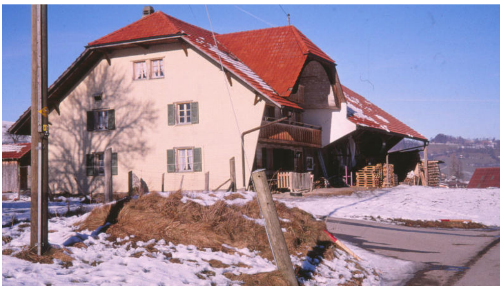
6 Der Keller lag südlich des Bauernhauses «im Bifang». Das Bauernhaus war nach Osten, zur Strasse hin orientiert, der Keller hingegen nach Norden in Richtung des Hauses. Foto, 2007 (FLM, digKat).
