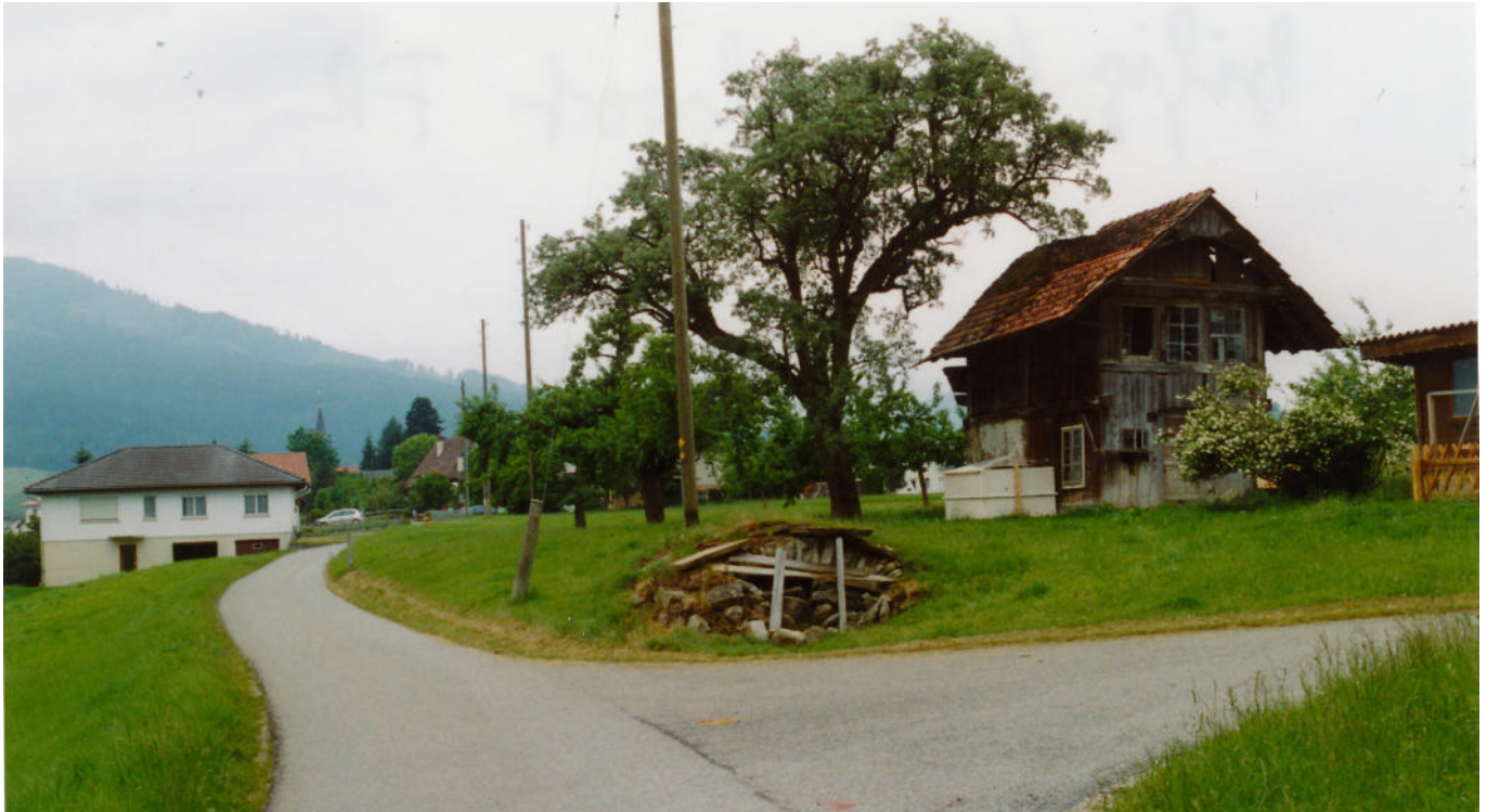
11 An der Zufahrt zum Bauernhaus stand der eingestürzte Kabiskeller, dahinter das Stöckli mit integriertem Ofenhaus. Foto, 2007 (FLM, digKat).
