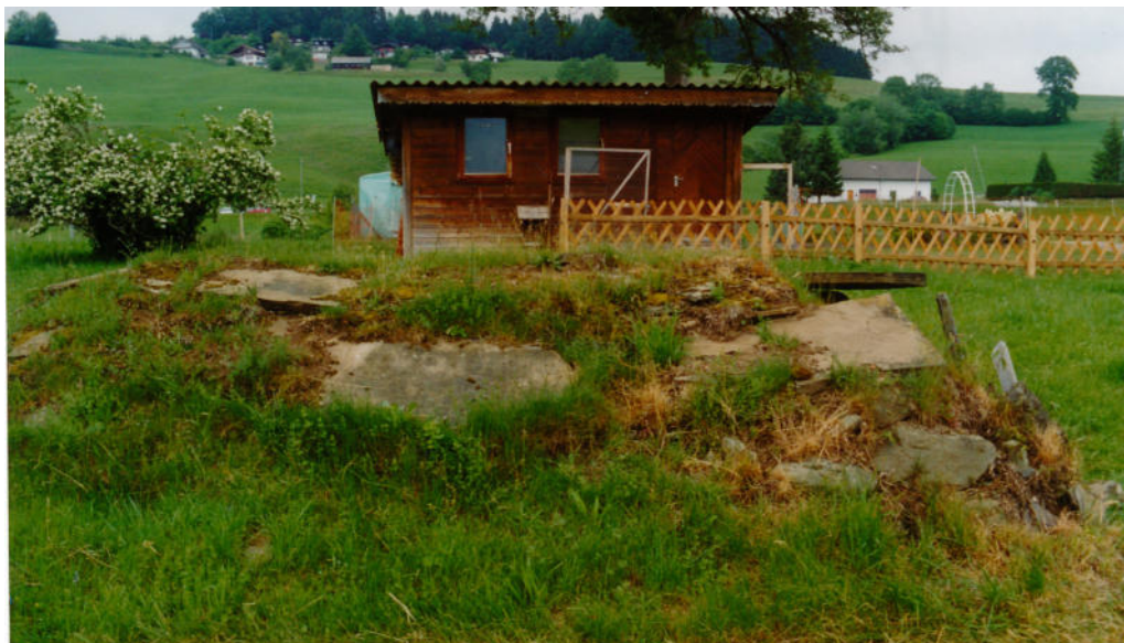
5 Der Keller war von drei Seiten nur als mit Steinplatten bedeckter Erdhügel sichtbar. Foto, 2007 (FLM, digKat).
