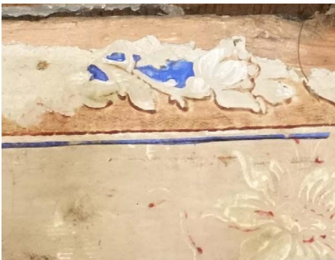
22 Tapetenreste im Ersten Dachgeschoss, heute Raum 3.3. Foto, 2020 (L. Imhof).
