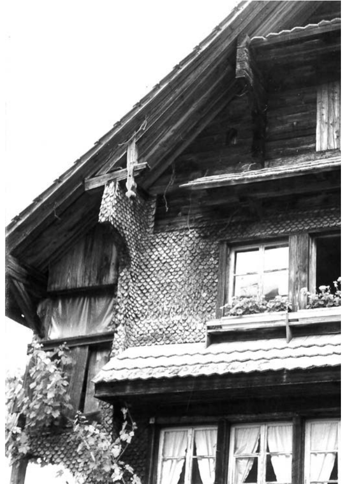
12 Das um 1850 aufgesetzte steile Sparrendach besitzt auf jeder Giebelseite ein Flugsparrenpaar. Foto, vor 1980 (FLM AltA 131).
