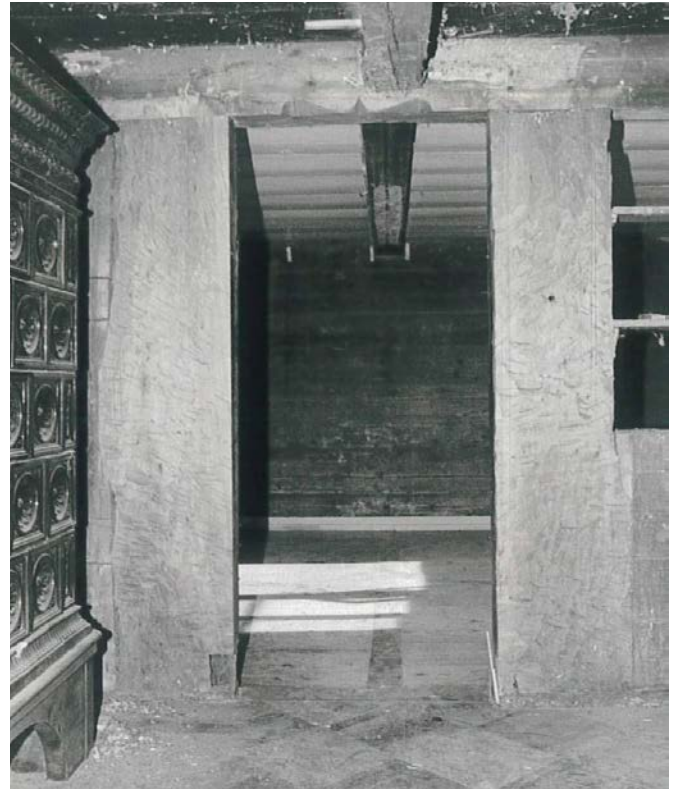
16 In den Türsturz zwischen Stube und Nebenstube war ein Eselsrücken eingekerbt. Foto, 1980 (FLM AltA 136).
