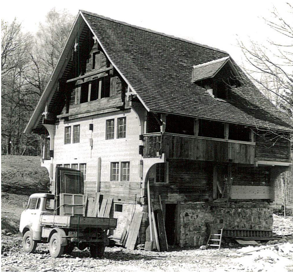
23 Beim Wiederaufbau des Z'Moos Haus im Ballenberg mussten an der Südseite viele morsche Holzbalken ersetzt werden. Foto, 1981 (FLM Gschwend 3398-K 711).
