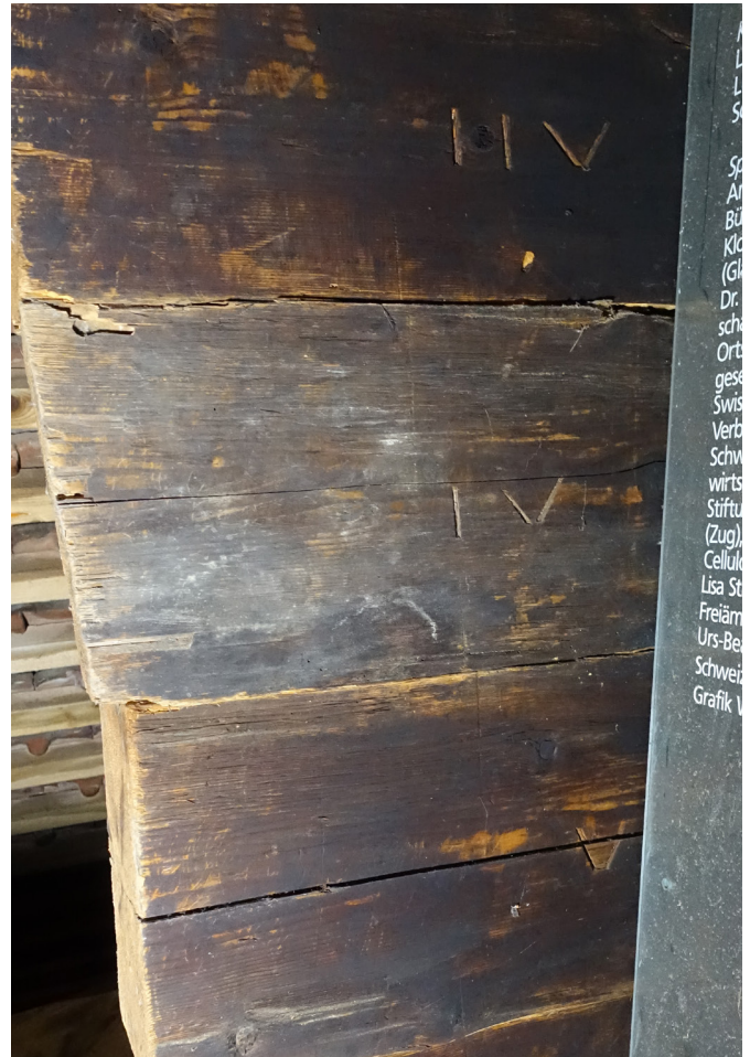
14 Abbundmarken kamen im Dachstock zudem an den Balken vor, die im 2. Dachgeschoss gegen Süden die Blockkonsolen ausbildeten (I-IX). Foto, 2020 (L. Imhof).
