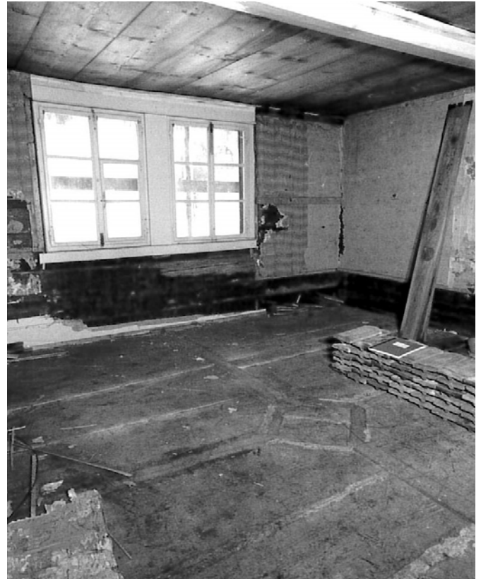
18 Beim Abbau fanden sich unter dem Wandtäfer der Nebenstube Reste von mehreren Tapetenausstattungen. Foto, 1980 (FLM Bal Fot 53775).
