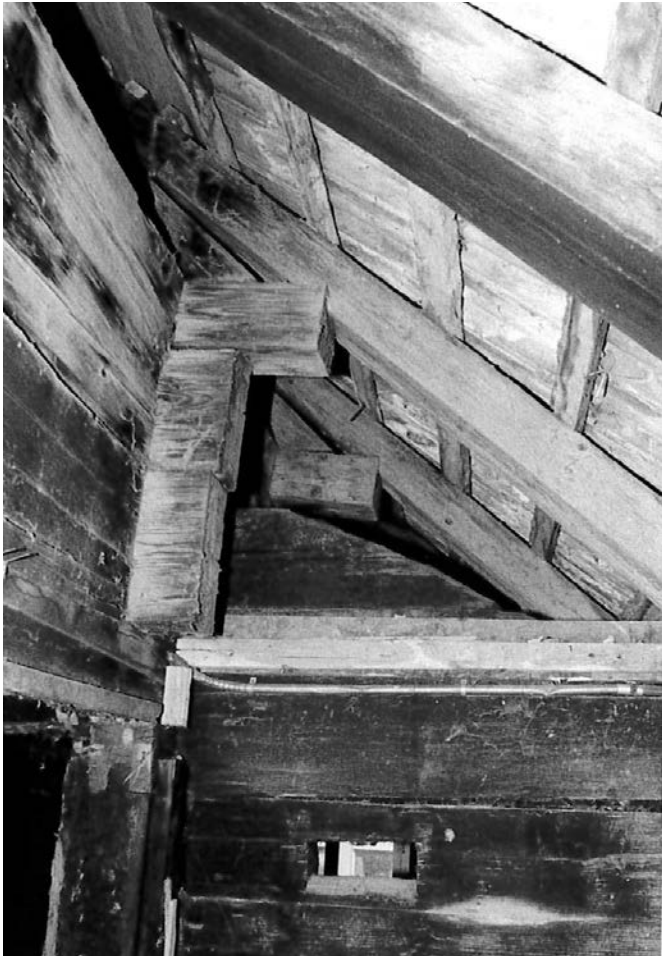
11 Die Dachneigung des ehemals vorhandenen Tätschdachs war an dem oberen Abschluss der Balkenwand im Bereich der Lauben ablesbar. Foto, 1980 (FLM AltA 136).
