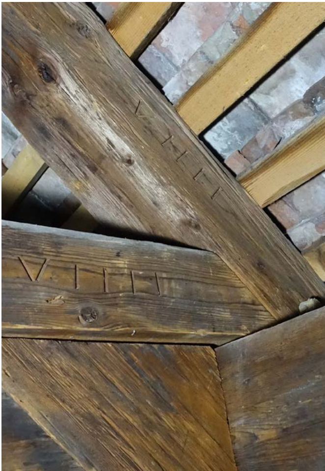
13 An den Sparren und Kehlbalcken waren Abbundmarken in Form römischer Ziffern angebracht (I-VIII). Foto, 2020 (L. Imhof).
