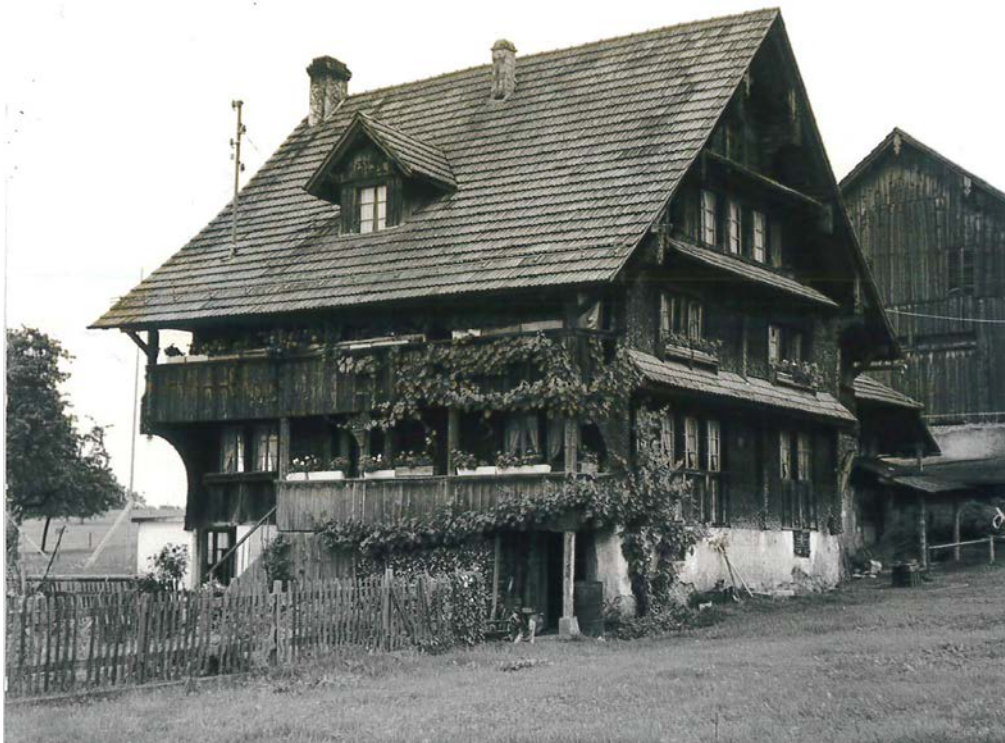
5 Auf der Westseite des Hauses lag der Haupteingang. Um 1900 wurde die Vorlaube im Hauptgeschoss angebaut. Foto, vor 1980 (FLM BalFot 53755).
