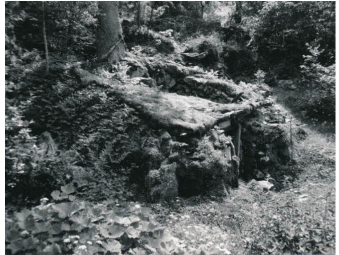
5 Ein Steinschlag hatte das Dach zerstört, der Bau wurde aufgegeben. Ansicht ehem. Ost, 1982 (FLM AltA 536).
