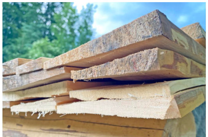
12 Die frisch aufgebrauchten Legschindeln fügen sich allmählich als Dachhaut zusammen. Foto, 2021 (BildA)
