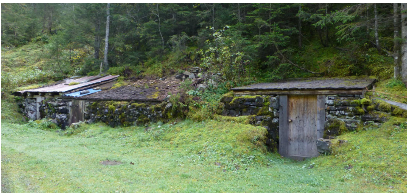
7 Baugleiche Kaltkeller am Weg nach Unterschächen-Äsch (Trauferschliessung). Foto, 2012 (FLM XXX).
