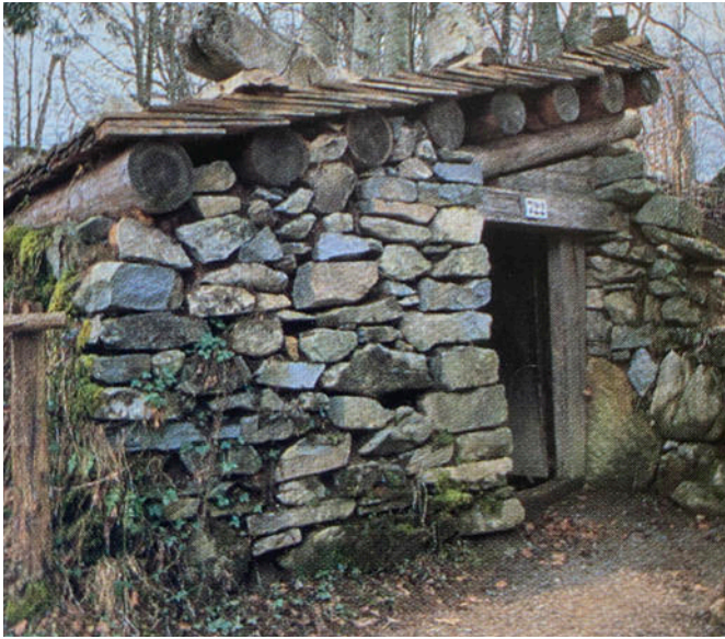
9 Das erste Dach entsprach nicht ganz den Schächentaler Vergleichsbauten. Ansicht Nord, Foto 2004 (FLM BildA).
