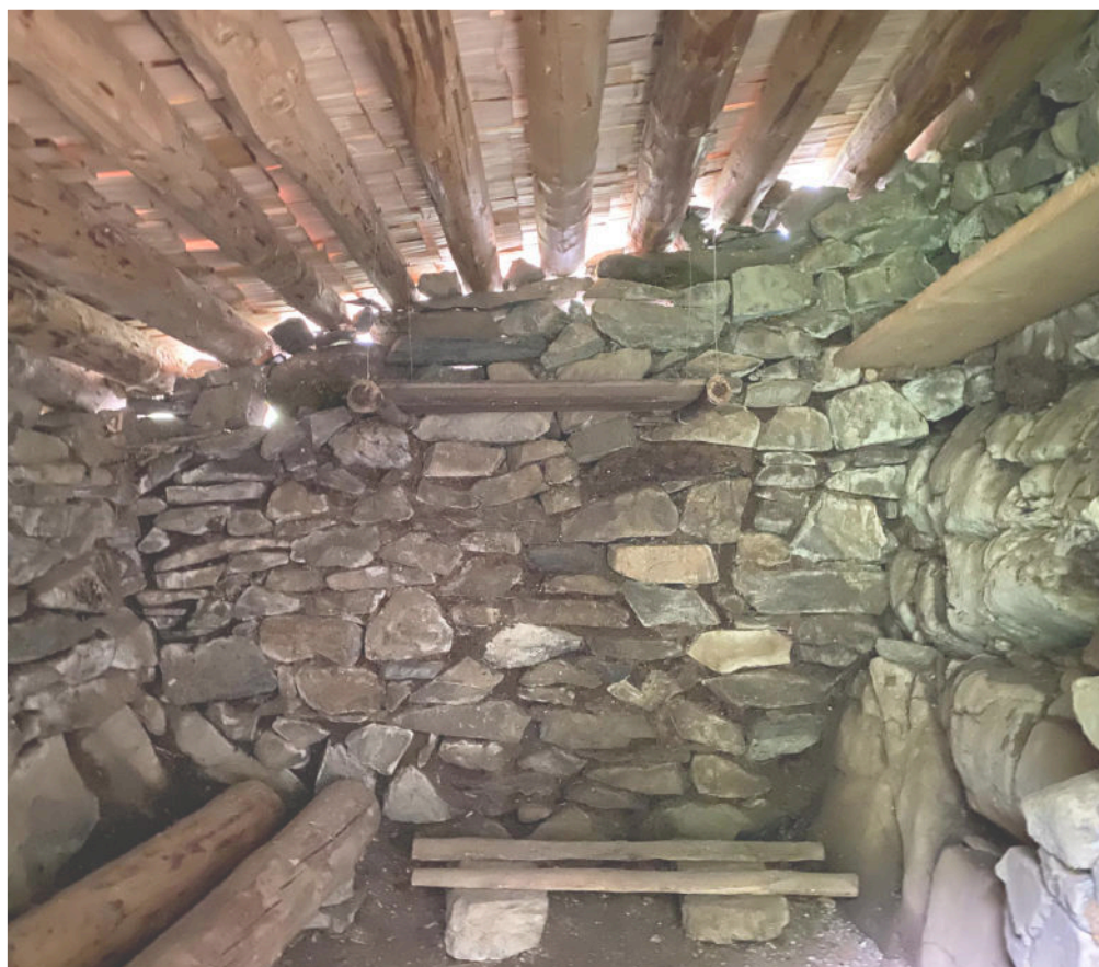
14 Der Innenraum unmittelbar nach der Dachrenovation. Foto, 2021 (FLM).
