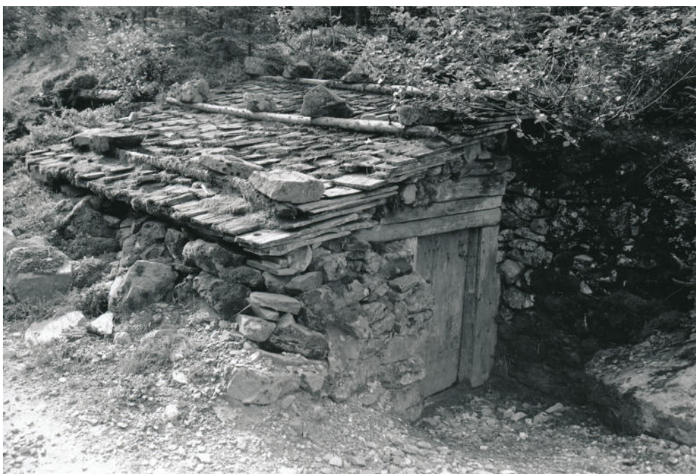
8 Vorbild für die Rekonstruktion des Ballenberg-Kalkkellers war ein intaktes Nachbargebäude, das allerdings über die Giebelseite erschlossen ist. Foto, 1982 (FLM BalFot 39482).
