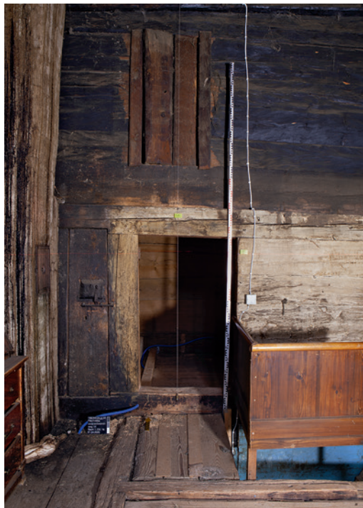
8 Kandergrund, Ausserrüti 121. Nordwand der Rauchküche auf Höhe des Gadengeschosses. Im Boden sind die Balken der Galerie erhalten. Hinter dem Kamin links befindet sich die Originaltüre, welche verschlossen und an die heutige Stelle verschoben wurde. Blick nach Norden.
