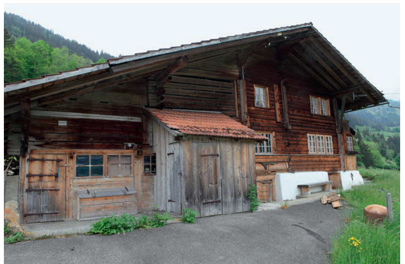
2 Kandergrund, Ausserrüteni 121. Westfassade. Blick nach Südosten.
