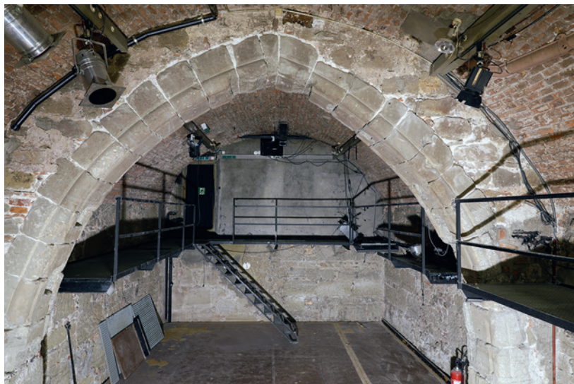
2 Bern, Kramgasse 4. Der spitzige Gurtbogen mit zwei Rundstäben in den gekehlten Gurtkanten. Blick nach Norden.
