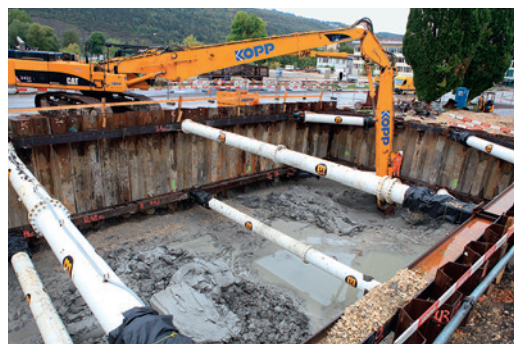
2 Nidau, Seewassernutzung. Mit einem Longfront-Bagger wurde der Boden Schicht für Schicht abgetragen. Trotz Spundwänden und Wasserpumpen drang immer wieder Wasser in die Grabungsfläche. Blick nach Norden.
