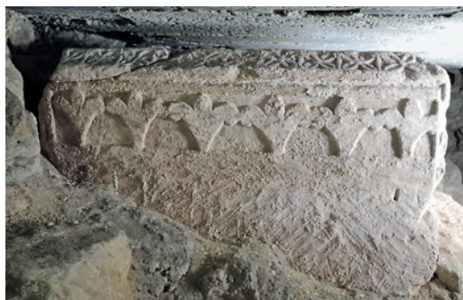
49 Saint-Denis/Paris, Fulrad-Basilika. Säulenbasis, in situ unter dem heutigen Bau.
