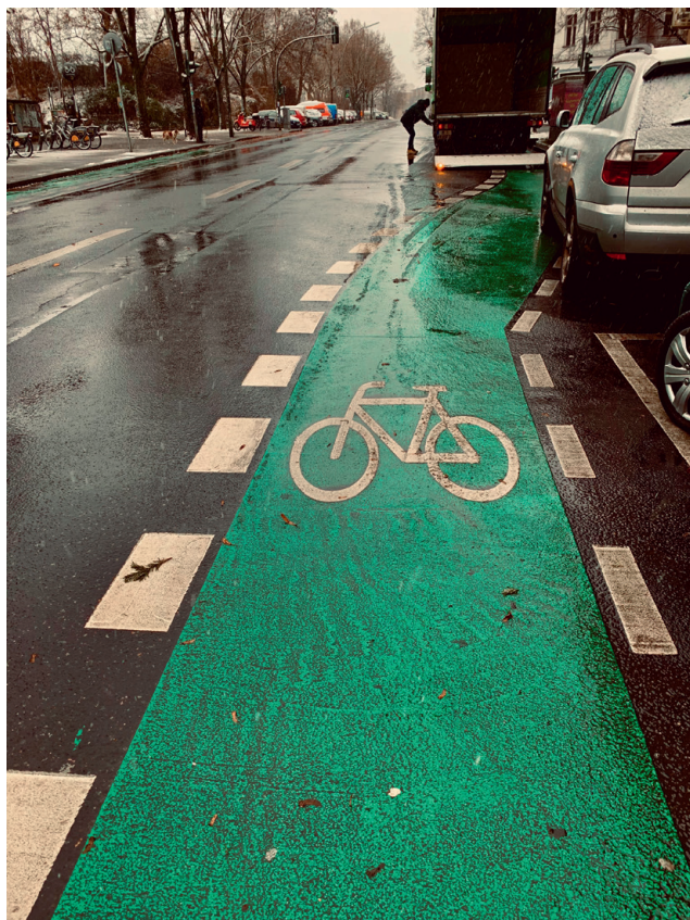
Abbildung 6. Berlin Katzbachstrasse – farbig markierte Radwege sollen für Achtsamkeit sorgen und Dooring-Unfälle vermeiden (Quelle: eigene Aufnahme).
