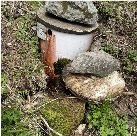
Abbildung 8: Gefasste Quelle mit einer kleinen Brunnenstube und Überlauf. (Foto: Nicolas Anderegg)
